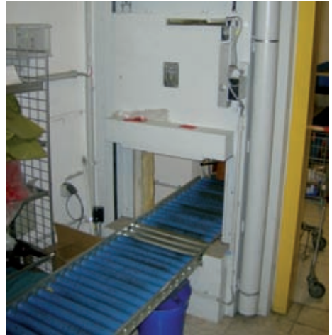
Bild 9: Brandschutzklappe
