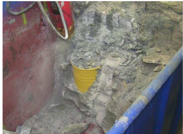
Abbildung 70: Staubentwicklung beim Meißeln in Steinsalzbeton.
