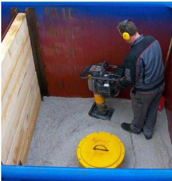
Abbildung 95: Zur Salzverdichtung eingesetzter Vibrationsstampfer.
