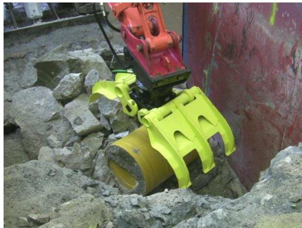
Abbildung 84: Eingesetzter Nukleargreifer des Herstellers Kinshofer GmbH.
