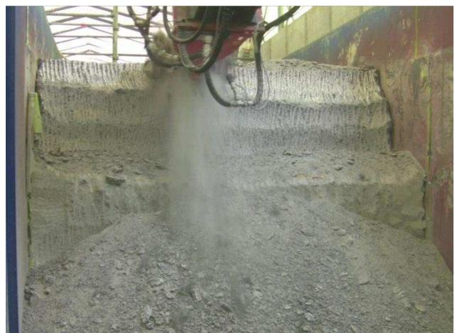
Abbildung 54: Staumentwicklung beim Fräsen in Steinsalzbeton.
