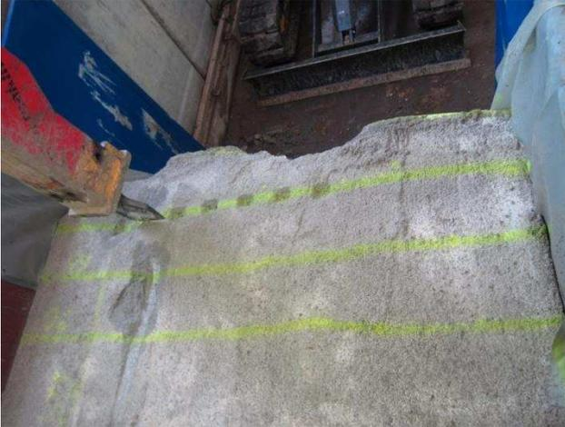
Abbildung 61: Flachmeißel am Steinsalzbetonblock, 30 cm zur Abbruchkante.
