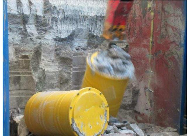
Abbildung 68: Flachmeißel – Herauslösen der Gebinde aus dem Steinsalzbeton.
