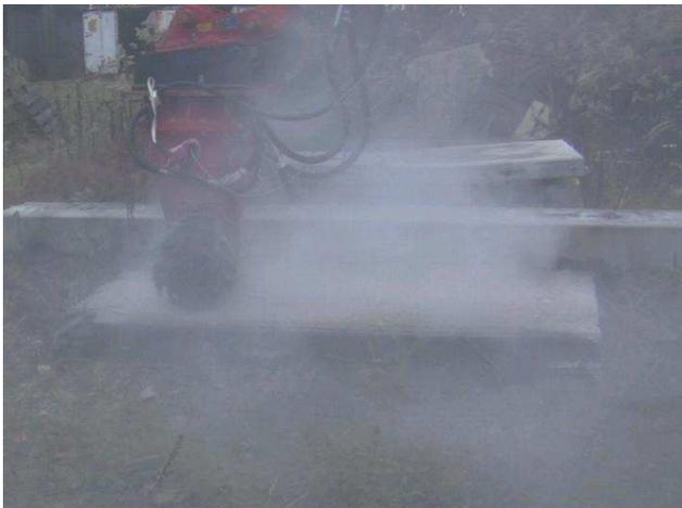
Abbildung 53: Staumentwicklung beim Fräsen in Beton.
