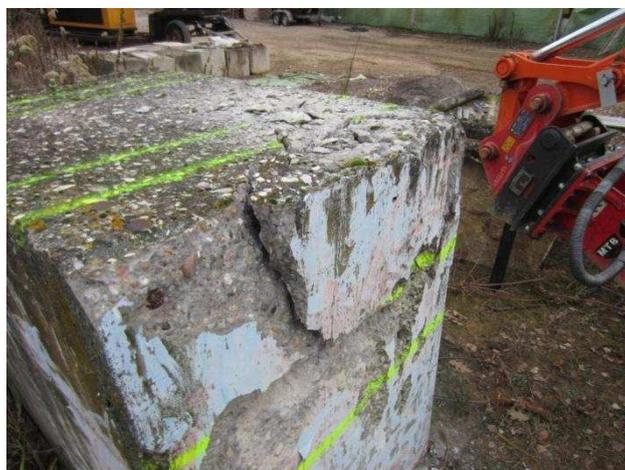
Abbildung 58: Hydraulikmeißel – keilförmig herausgelöstes Betonstück.
