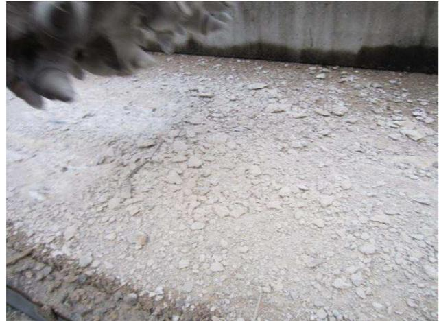
Abbildung 42: Hydraulikfräse – Bruchstücke aus dem Beton.
