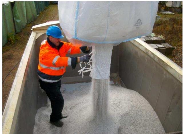
Abbildung 14: Befüllen des Transmixes mit Steinsalz.
