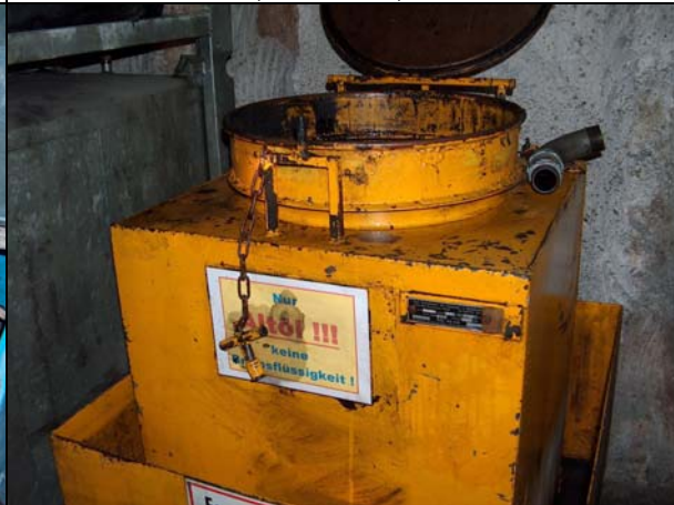
Photo 04: 490-m-Sohle, KfZ-Werkstatt, Behälter für Altöl; Probe A4
