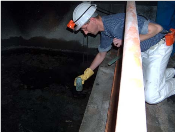
Photo 01: 490-m-Sohle, Waschplatz in Ka 3; Probe A1
