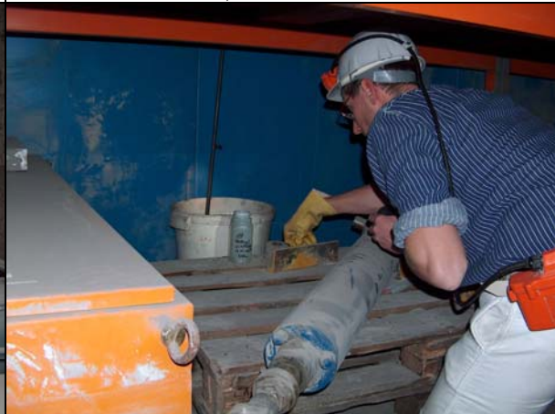
Photo 06: 490-m-Sohle, E-Werkstatt, Eimer mit Kondensat Klimaanlage; Probe A8
