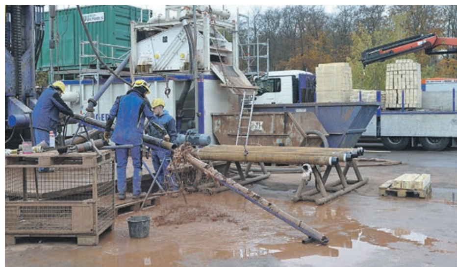
Frisch aus der Erde hochgeholt: Die Bohrung wird gespült.
