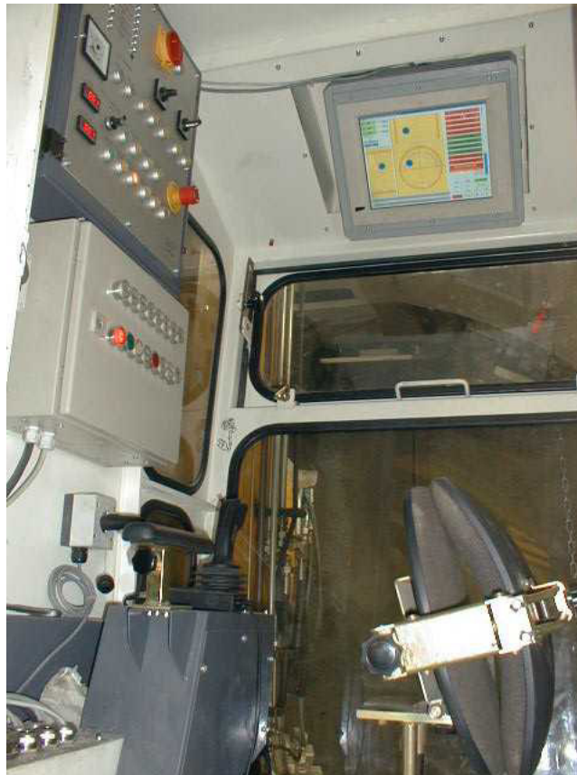
Abbildung 58: Beispiel für Steuerkabine und fernhandierte Steuerung einer Tunnelbohrmaschine, Projekt Dublin Port Tunnel [Bildarchiv Herrenknecht AG]
