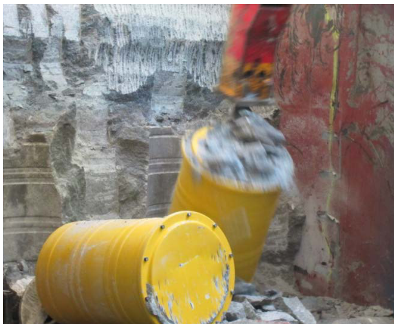
Abbildung 45: Versuche mit Hydraulikhammer zum Freilegen von Gebinden in Steinsalzbeton [56]
