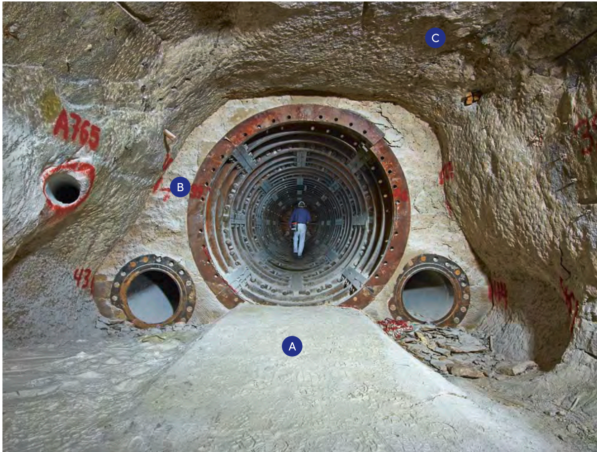
Das Dammjoch, gebaut im Jahr 1914, befindet sich auf der 700-Meter-Sohle
