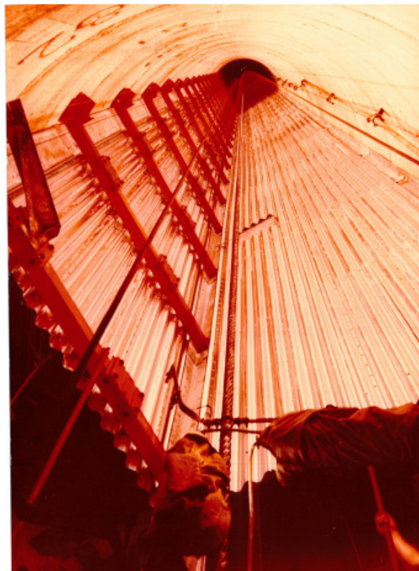
Abb. 2.6-2 Wetterscheider Schacht Asse 2
