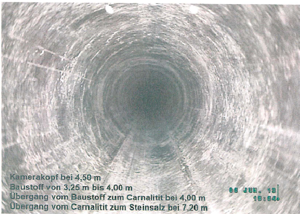
Abbildung 8: Bohrloch im Bereich des Messintervalls – Teufenangaben bezogen auf Kontur (nicht Standrohr)
