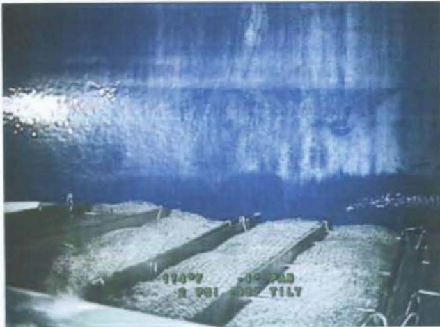
INSPEKTION VON FILTERBÖDEN IN GLAS-AUSGEKLEIDETEN BEHÄLTERN
