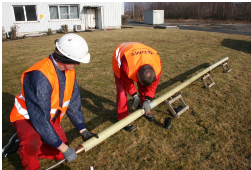
Darstellung 2: Zusammengebaute richtungssensitive 3D-Bohrlochradarsonde Modell 85.
