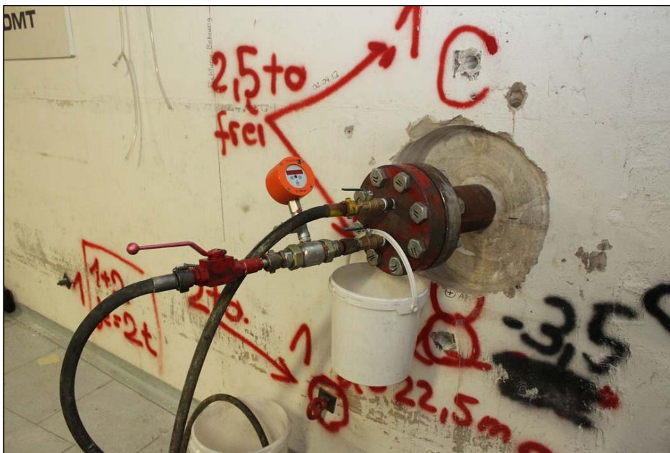
Abbildung 4: Druckprüfung zum Nachweis der Dichtheit des Standrohres am 09.04.2013
