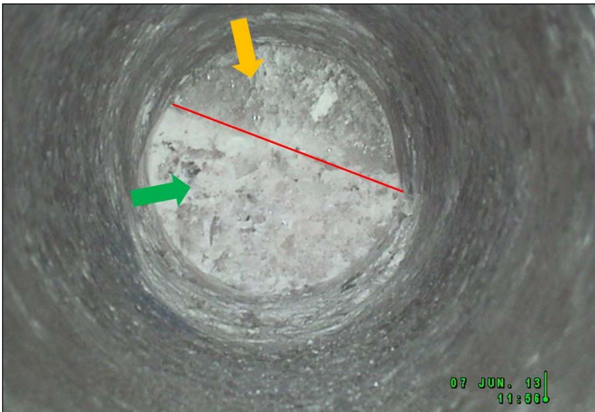
Abbildung 6: B 7/750-A3, Bohrteufe 23,0 m, Aufnahme vom 07.06.2013, Versatzmaterial (grüner Pfeil) und Steinsalz (orangener Pfeil)
