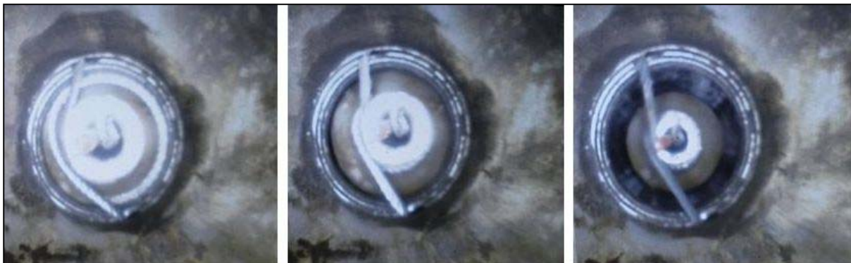
Abbildung 10: Fangen der Sonde mit Kamerabegleitung
