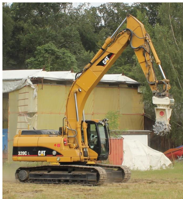
Abbildung 1: Funkgesteuerter Hydraulikbagger Caterpillar 320 CL
