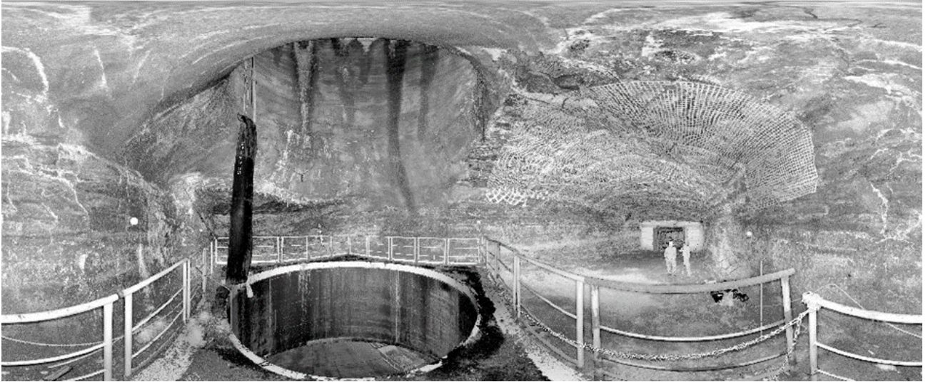
Abbildung 43: Beispielhaftes Abbild einer Laserscan-Messung in einem Füllort (Quelle: Redpath Deilmann GmbH)
