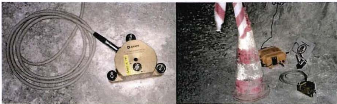
Abbildung 12: Installation von Sensor (links) und Messequipment (rechts) am Standort "S595W"
