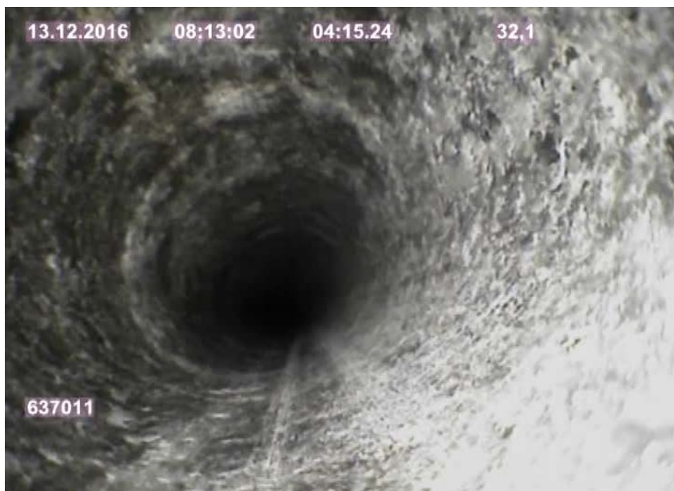
Foto 10c: Bohrloch bei 32,10 m
