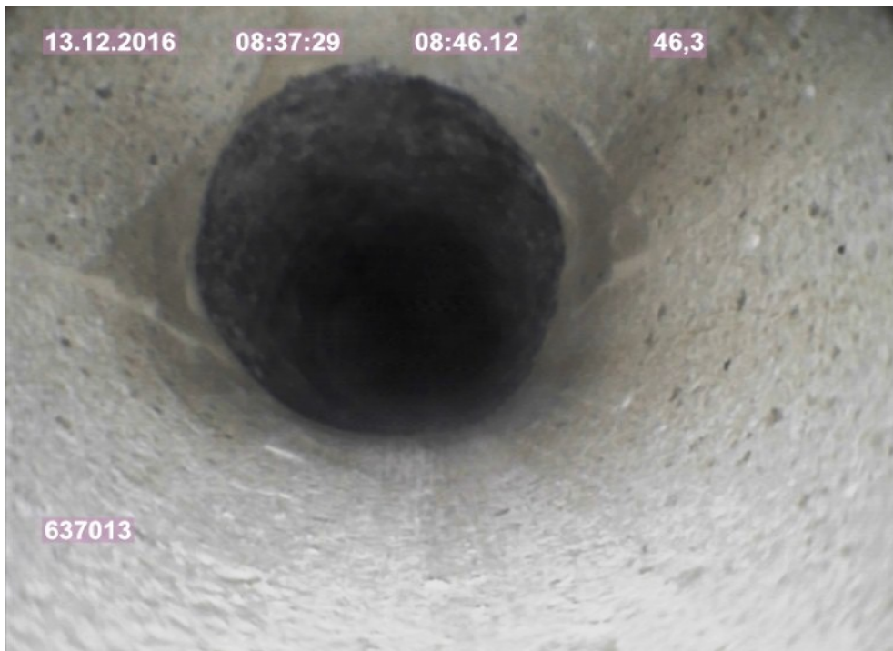
Foto 9d: Übergang Sorelbeton/Steinsalz bei 46,40 m
