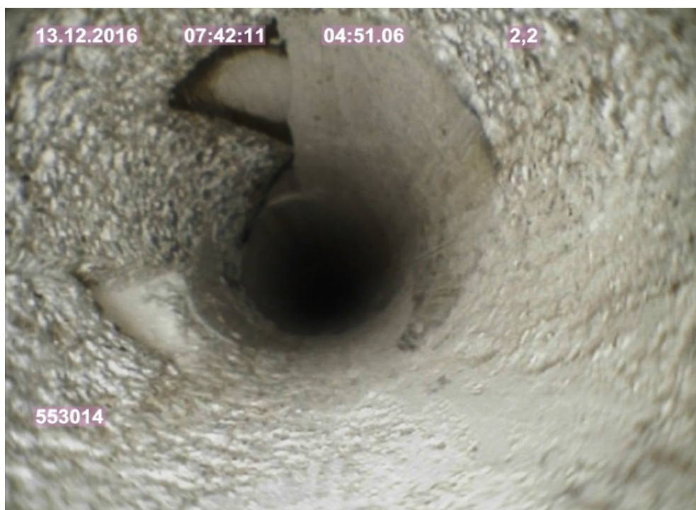
Foto 3b: Übergang Mauer/Betonkörper bei 2,10 m
