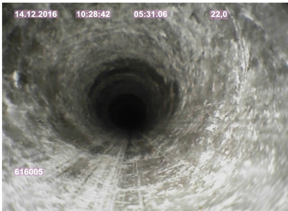
Foto 8a: Bohrloch bei 22,00 m
