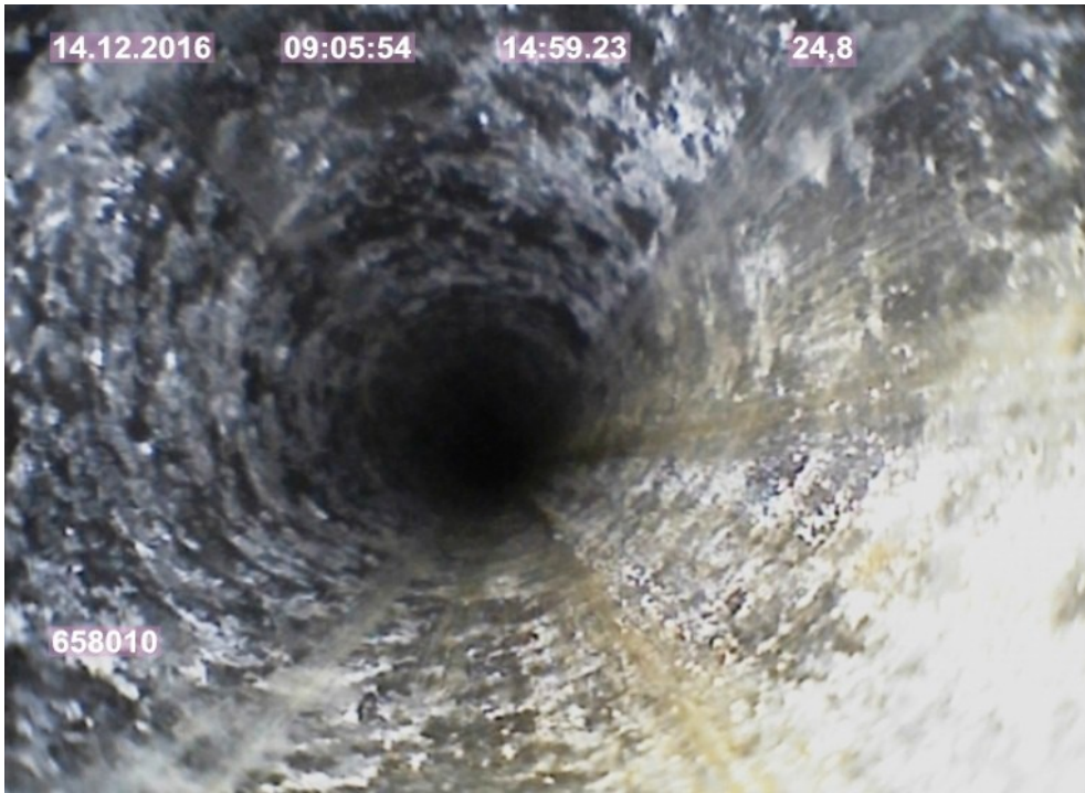
Foto 11k: Bohrloch feucht bei 24,80 m
