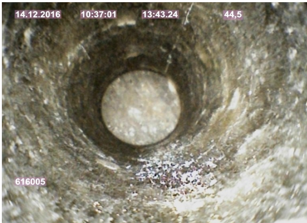
Foto 8d: Bohrlochende bei 44,62 m leicht feucht
