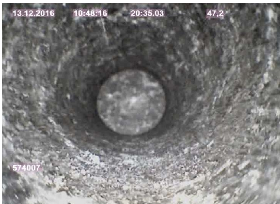
Foto 5j: Bohrlochende bei 47,20 m
