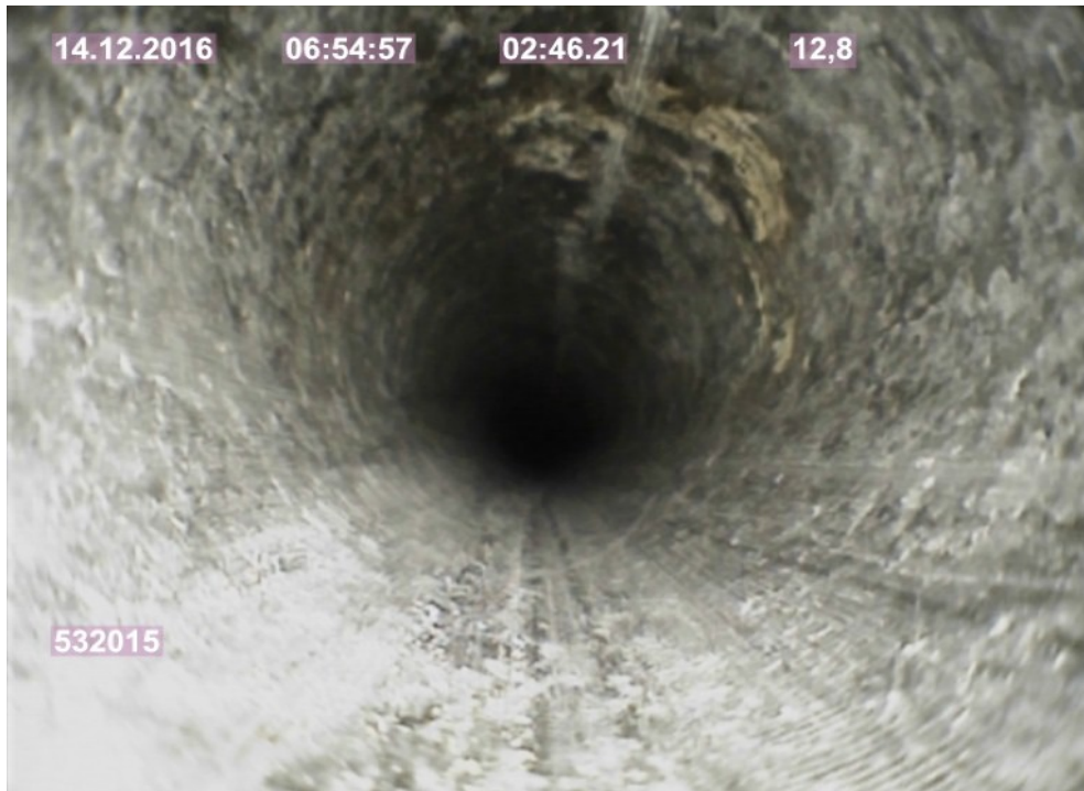
Foto 1a: Ausbruch Stoß/Firste bei 12,80 m
