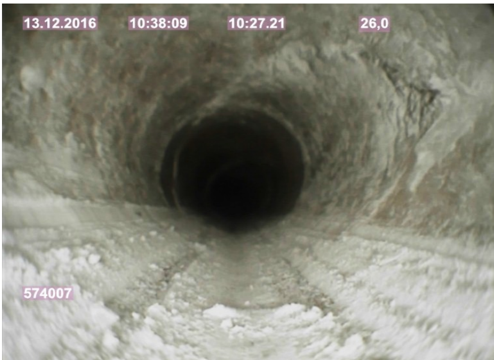
Foto 5f: Bohrloch bei 26,00 m
