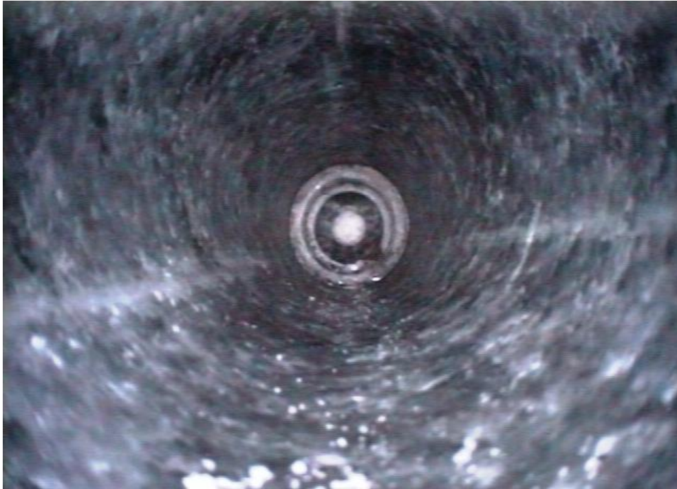
Foto 2i: Bohrlochende bei 57,41 m
