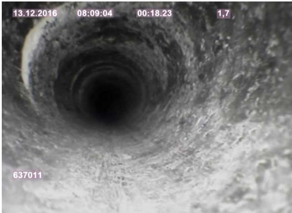
Foto 10a: Bohrloch bei 1,70 m, leicht porös
