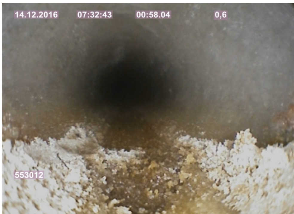
Foto 2b: Bohrloch feucht bei 0,70 m
