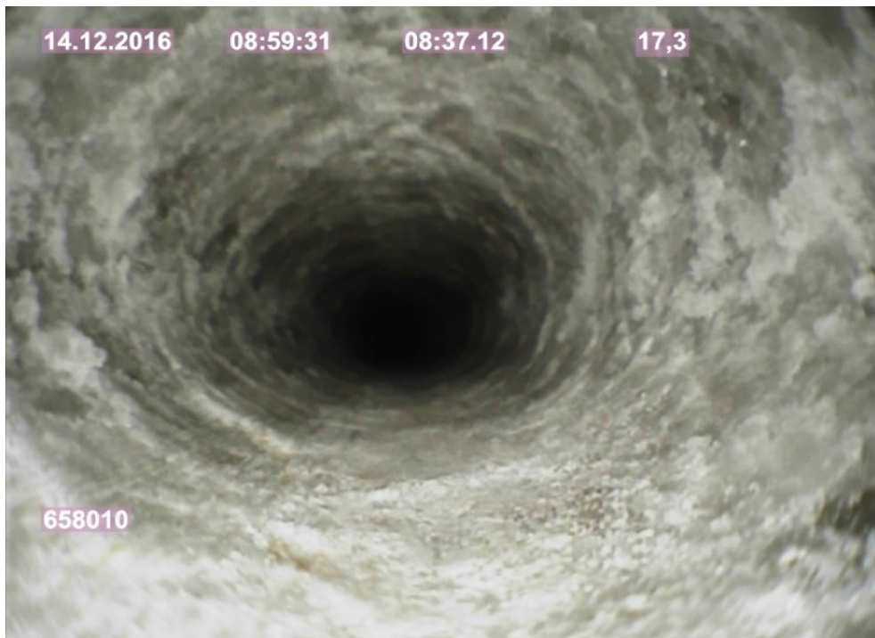
Foto 11f: Riss in der Sohle bei 17,30 m nicht sichtbar
