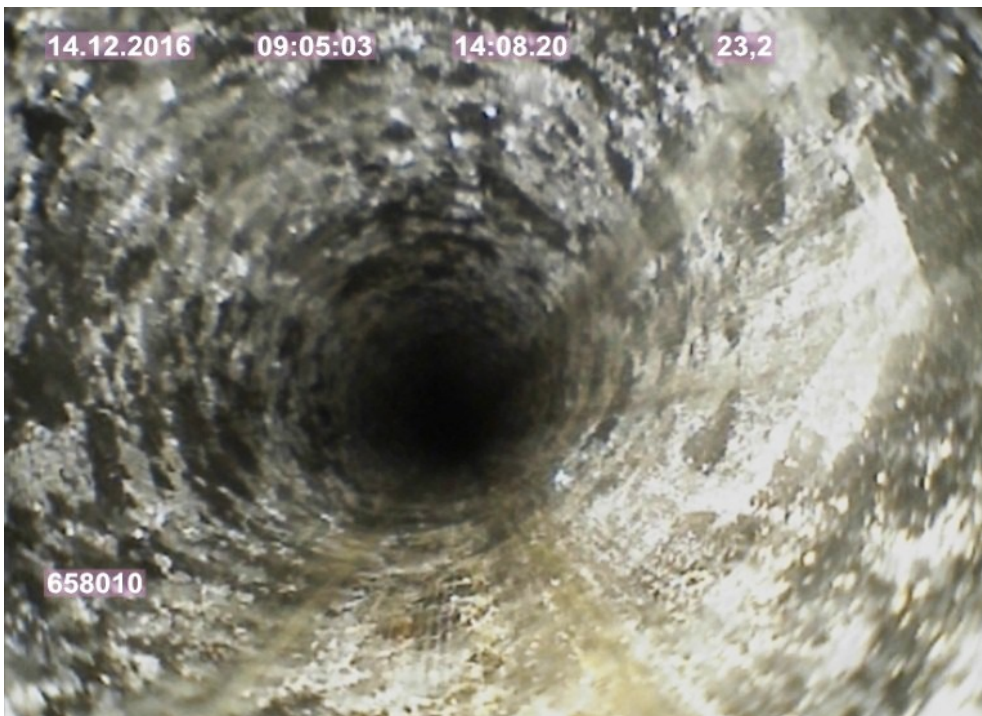
Foto 11j: Bohrloch feucht bei 23,30 m
