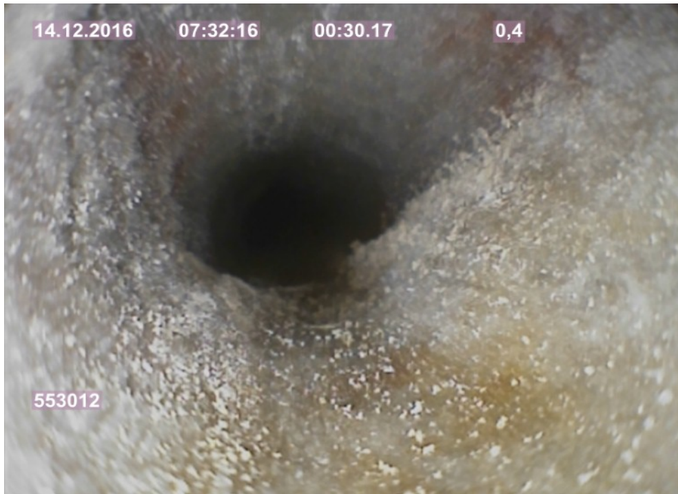
Foto 2a: Bohrloch feucht bei 0,40 m
