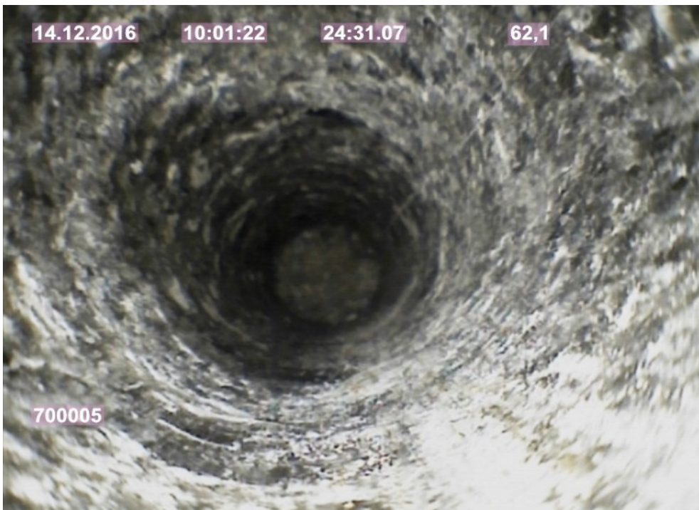
Foto 12f: Bohrlochende bei 61,82 m
