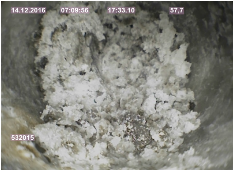
Foto 1g: Ausbruch und Bohrlochende bei 57,96 m Teufe
