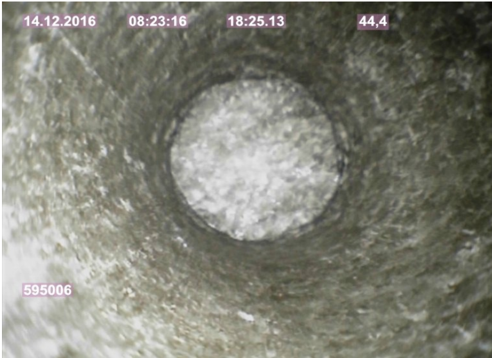
Foto 6j: Bohrlochende bei 44,14 m
