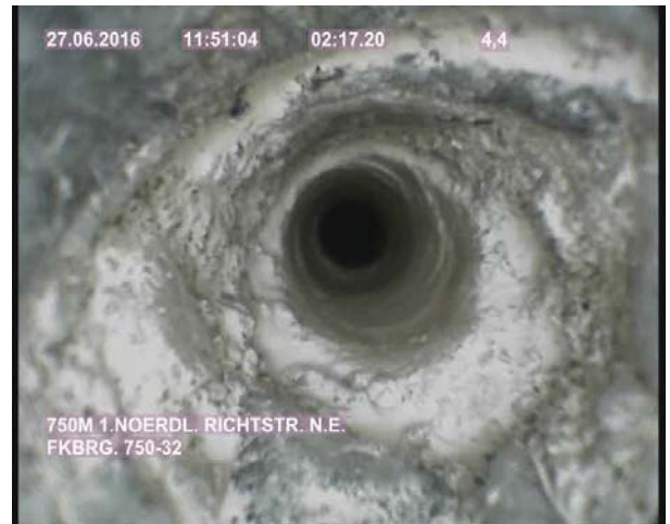
Bild 47: FKBrG. 750-32 – Position bei 4,5 m Übergang Steinsalz–Sorelbeton
