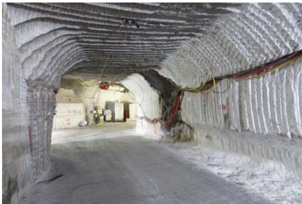
(a) Nachgeschnittener südöstlicher Füllortstoß mit Unterschneidung durch ehemaligen Luttenkanal
