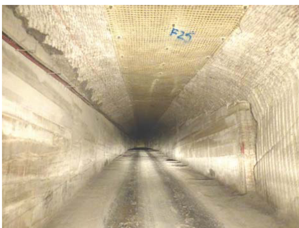
(a) Westlicher Wendelstreckenabschnitt von der 725-m- zur 750-m-Sohle mit Stabilisierungsmauern an Nord- und Südstoß
