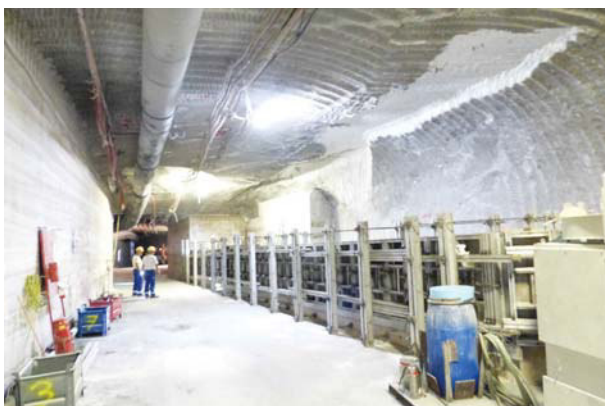
(a) Erstellung der Schalungsmauer für das Stützbauwerk im Bereich der nordwestlichen Streckenaufweitung mit Anschluss an den stabilisierten Pfeiler
