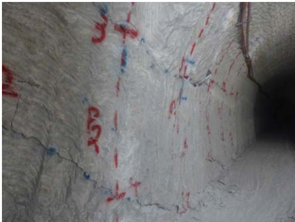
(a) Südstoß im Ostteil der Wendelstreckenumfahrung zur 775-m-Sohle mit steil einfallenden Trennflächen und Fissurometer 037F
