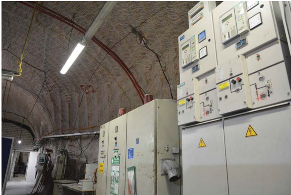
Abbildung 4.10: Fotoaufnahme des Risses im Pfeiler zwischen E-Werkstatt/490 und Abbau 8/490 vom 03.01.2017, Blickrichtung: Südost
