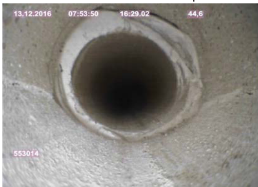
Bild 3: Bohrung 553014; 44,6 m Bohrlochteufe; Aufnahme vom 13.12.2016
