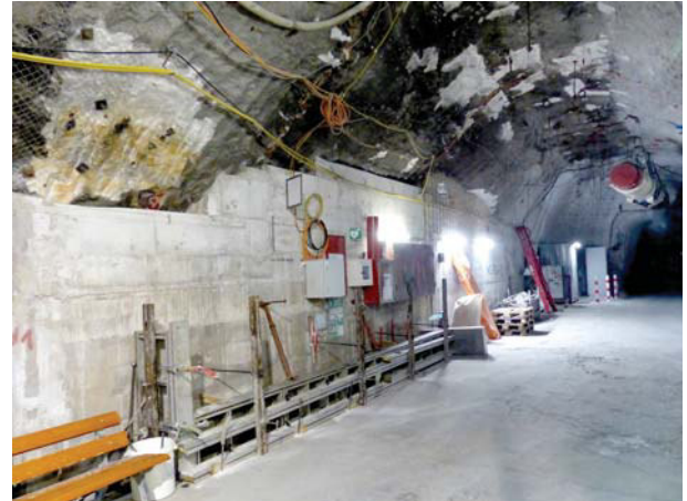
(b) Einschalung eines kleinen Sorelbetonsockels westlich des verfüllten Hauptquerschlags nach Norden
