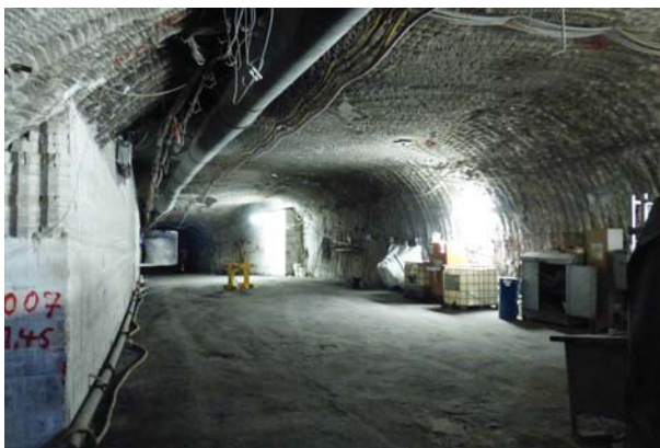
(a) Streckenaufweitung westl. des Pausenplatzes mit großer offener Spannweite und bereits bestehenden Stützbauwerken am südl. und nordwestl. Stoß
