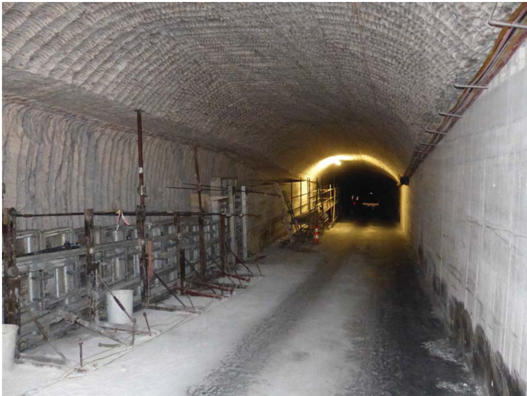
Abbildung 4.33: Stabilisierung des oberen Wendelstreckenabschnitts zwischen der Wendelkehre 725 und der 750-m-Sohle durch Erstellung von Sorelbetonmauern entlang der nachgeschnittenen Stöße
