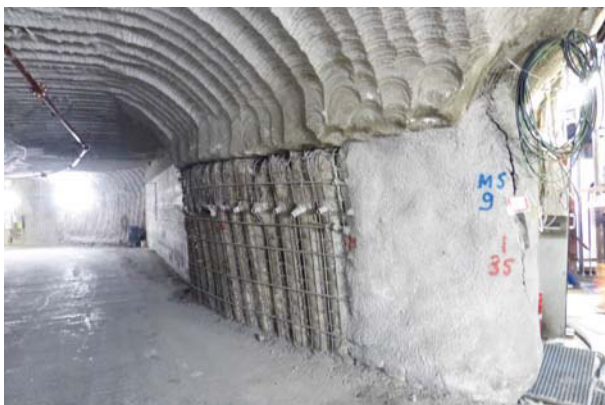
(a) Aus Bullflexelementen aufgebaute südöstlicher Pfeiler mit Messstelle MS9 in mit Spritzbeton sa- nierter Pfeilerecke
