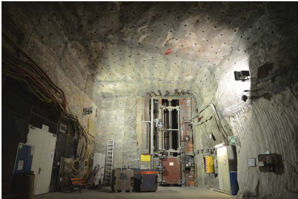
Abbildung 4.14: Fotoaufnahme des Füllortes Schacht 2/490 vom 03.01.2017.
