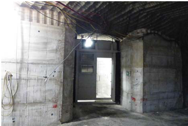
(a) Neues Wettertor und mit Sorelbeton stabilisierte Stöße unmittelbar an der Einbindung zur nördlichen Richtstrecke nach Westen
