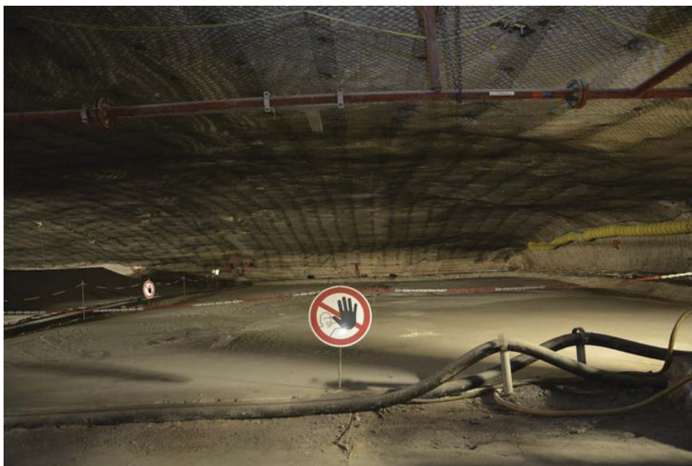
Abbildung 4.1: Fotoaufnahme des verfüllten Lösungsspeicherbeckens 1 (LSB 1) im Abbau 3/490 vom 03.01.2017.
