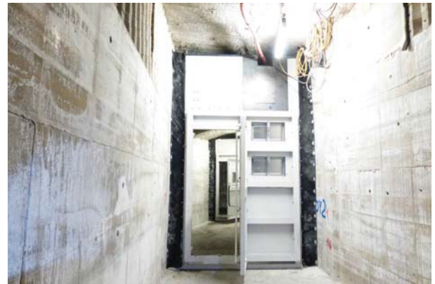
(b) Neue Wettertore in der mit Sorelbetonmauern stabilisierten Zugangsstrecke zum Füllort Schacht 4/750
