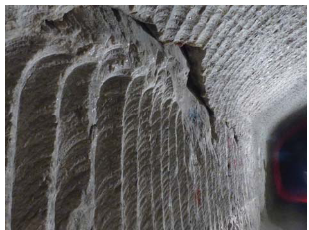
(b) Nachgeschnittener östlicher Wendelstreckenabschnitt von der 725-m- zur 750-m-Sohle mit steil einfallenden Trennflächen im Übergang Nordstoß zur Firste
