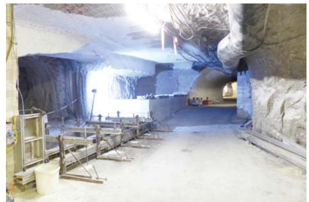
(b) Errichtung eines Stützbauwerks vor dem ehem. Holzlager und Vorbereitung der Schalungsmauer vor dem westl. Zugang zu Abbau 4a(Na2)
