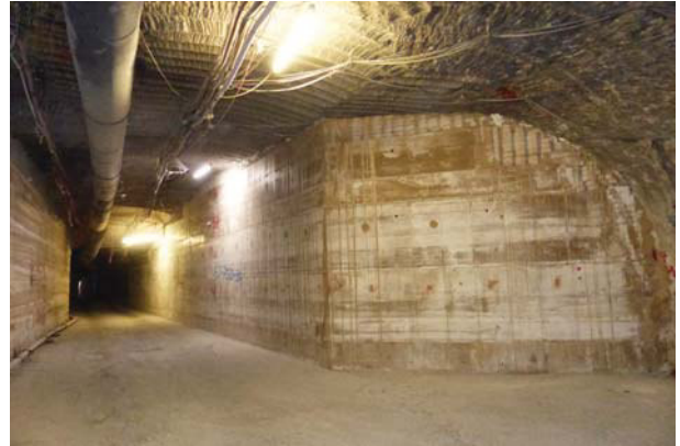
(b) Bis zum Firsttextensometer FIEX750-05 fertiggestelltes Stützbauwerk in der nordwestlichen Streckenaufweitung
