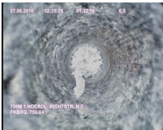
Bild 33: Längliche Salzausblüfung und Kali-einsprenglinge (FKBrg.750-04, Tiefe: 6,30 m)
