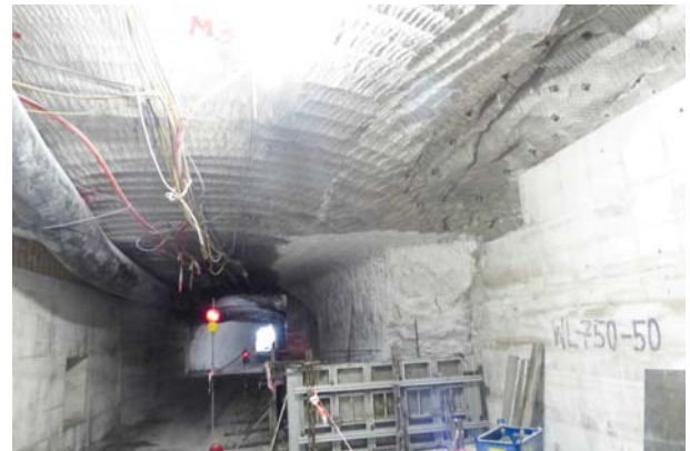
(b) Stabilisierung des entfestigten westlichen Kleinpfeilers durch ein Stützbauwerk aus Sorelbeton
