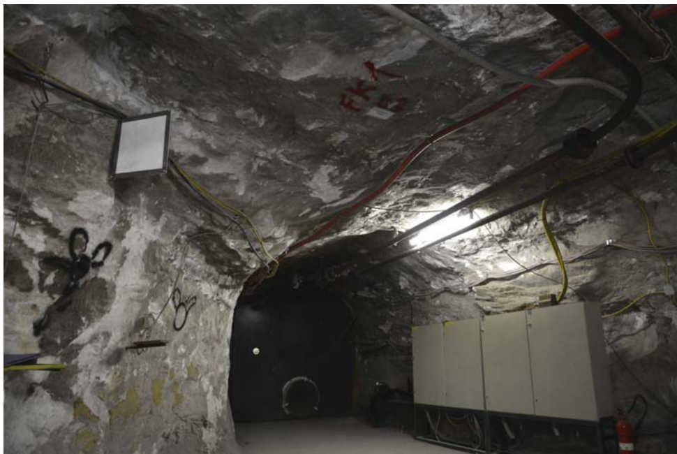
Abbildung 4.15: Fotoaufnahme des Füllortes Schacht 4/490 vom 03.01.2017.
