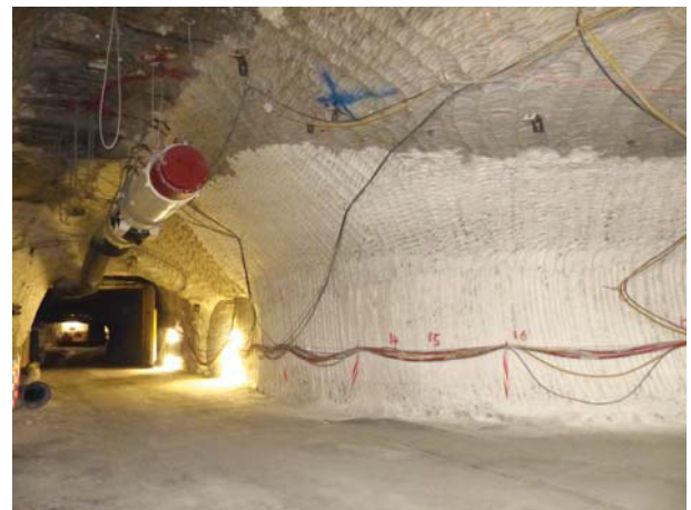
(b) Bis zum Übergangsbereich zur Firste nachgeschnittener Südoststoß am Übergang zur nördlichen Richtstrecke nach Osten
