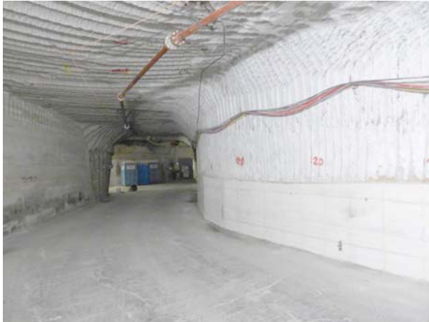
(a) Sanierter südöstlicher Stoß mit Stützmauer- elementen aus Sorelbeton innerhalb des Luttenkanals
