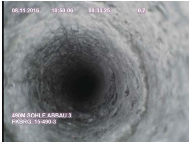
Abbildung 4.2: FK-Brg. 15/490-3, Tiefe: 0,7 m
