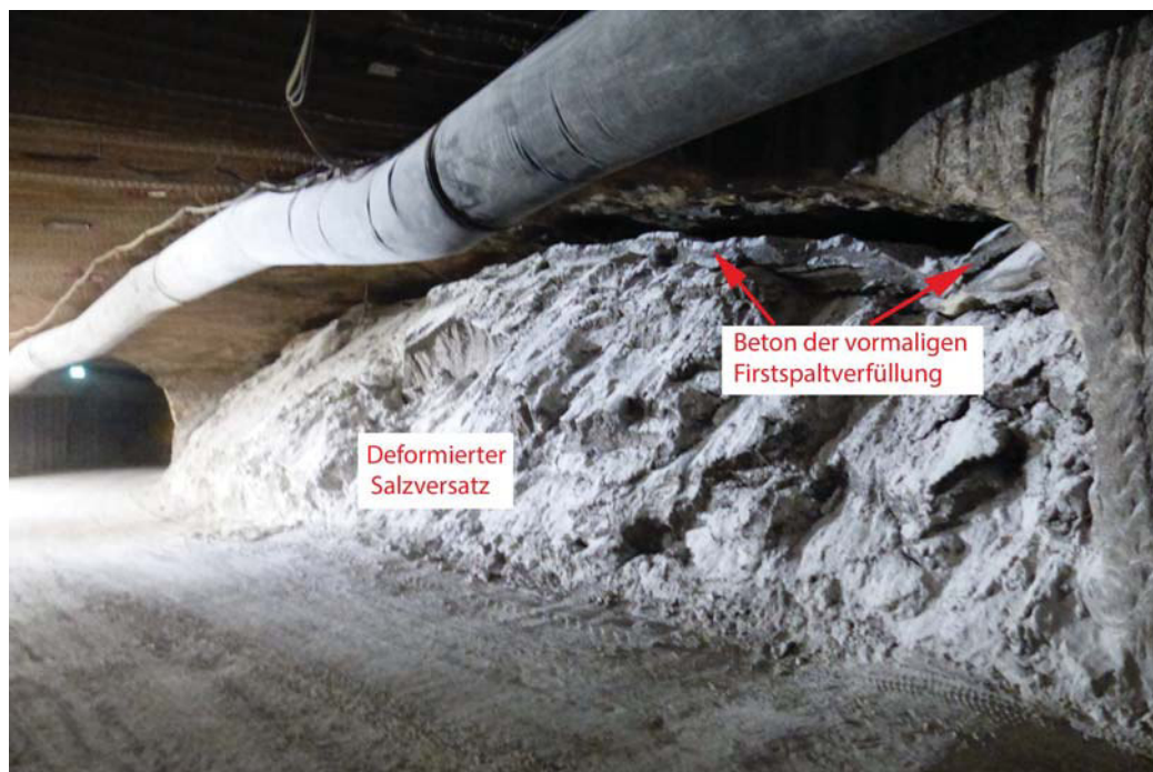
Abbildung 4.22: Abbau 8a/532, Böschung der Verfüllung mit Firstspalt, Blick nach Südwesten, Stand: 02.02.2017
