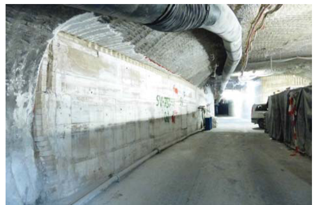
(b) Verfüllter Zugang zu Abbau 5a(Na2) mit fertiggestelltem Stützbauwerk südlich des Pausenplatzes
