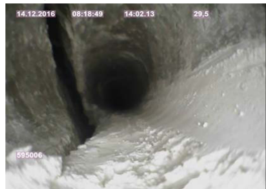
Bild 6: Bohrung 595006; Riss bei 29,4 m Bohrlochteufe; Aufnahme vom 14.12.2016
