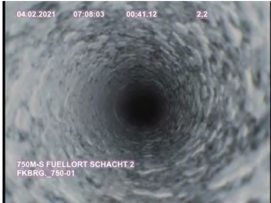
Bild 69: Spuren des Bohrvorgangs und anhaftendes Bohrmehl (FKBrg.750-01, Teufe: 2,20 m)
