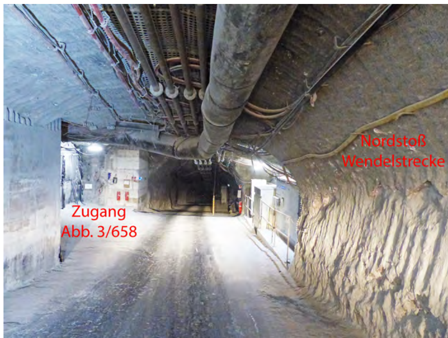
Abbildung 4.16: Östlich und westlich des Zugangs zum Abbau 3/658 am Südstoß erstellte Stützmaurelemente sowie Abschalungen am Nordstoß, Blick nach Westen (05.01.2021)
