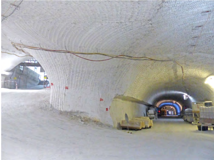
Abbildung 4.55: Nördliche Richtstrecke nach Osten (rechts) mit nachgeschnittener Kontur, betonierter Sohle und eingefräster Nische zur Aufnahme einer Stützmauer am Südstoß. Auch im Bereich der Zufahrtsrampe zum Abbau 5/750 (Na2) erfolgte ein umfassender Konturnachschnitt, Blick nach Nordwesten (05.01.2021)
