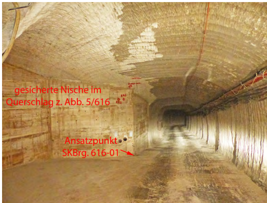
Abbildung 4.14: Gesicherte Nische im Querschlag zum Abbau 5/616 auf der 616-m-Sohle mit Übergang zu Stützmaurelement am Südstoß des Pfeilers 4/5 und Ansatzpunkt SKBrg. 616-01, Blick nach Südwesten (05.01.2021)
