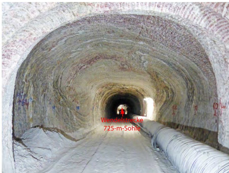
Abbildung 4.27: Von den Bohrern für die Versorgungsbohrung zu den Kavernenstrecken auf der 825-m-Sohle abgehende Flucht- und Wetterstrecke in Richtung der Wendelstrecke auf der 725-m-Sohle mit dem Übergang vom Carnallitit ins Tonliniensalz, Blick nach Südwesten (06.01.2021)
