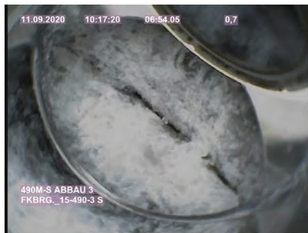
(b) Rissstruktur bei ca. 0,6 m bis 0,7 m Bohrlochteufe (Befahrung mit Spiegel)
