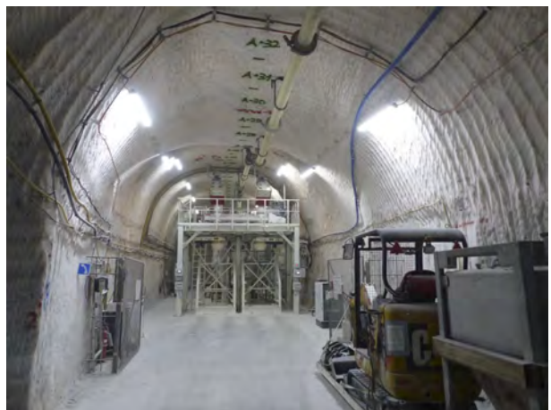
(b) Blick nach Südwesten in den Standort der Baustoffanlage 51BA, Stand: 06.01.2021
