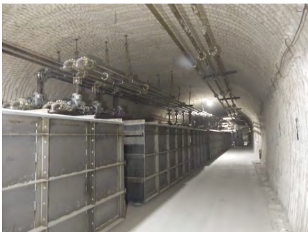
(a) Blick nach Südwesten in den Bereich der Lösungsspeicherbecken mit Ausbau für das Lösungsmanagement, Stand: 06.01.2021
