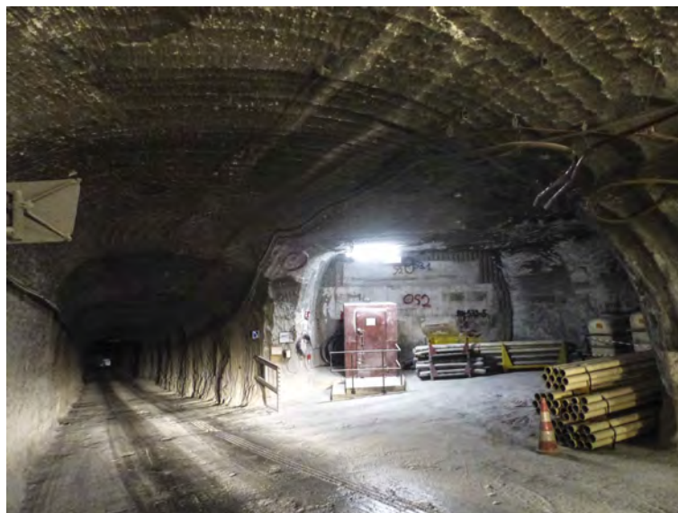
Abbildung 4.11: Blick von der Wendelstrecke auf die Abschlussmauer zur Abbaubegleitstrecke der 532-m-Sohle, 05.01.2021
