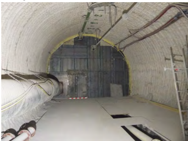
(c) Blick nach Südosten auf die Wetterwand in der Abwetterstrecke von Schacht 2, Stand: 06.01.2021
