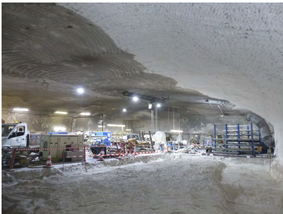
Abbildung 4.8: Blick auf die laufenden Sanierungsarbeiten am nordöstlichen Stoß des Abbaus 2/511 auf der 511-m-Sohle, Stand: 05.01.2020
