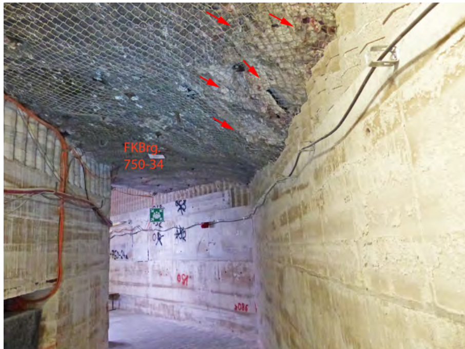
Abbildung 4.51: Durch Stützbauwerke stabilisierter Zugang zum Füllort Schacht 4/750 mit Systemankerung und Firstkontrollbohrungen an der entfestigten Firste sowie mit Verbundsteinpflaster befestigter Sohle (03.02.2021)
