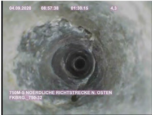
Bild 75: FKBrG. 750-32 – Position bei 4,2 m Aufgelockerter Bereich bis 4,5 m
