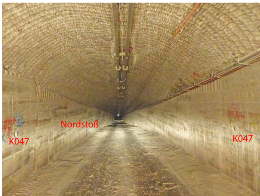
Abbildung 4.19: Westlicher Wendelstreckenabschnitt von der 725-m- zur 750-m-Sohle mit durch Stabilisierungsmauern saniertem Nord- und Südstoß (Lage Konvergenzmessstelle K047), Blick nach Südosten (05.01.2020)
