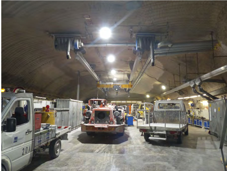
Abbildung 4.5: Blick nach Osten in die Kfz-Werkstatt mit der Kranbahn, Stand: 06.01.2021
