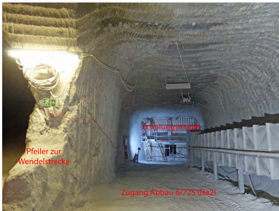
Abbildung 4.28: Errichtung einer Schalungsmauer im westlichen Zugang zum Abbau 6/725 (Na2) auf der 725-m-Sohle, nach Freiladen und Vorbereitung des Abbaus zur Verfüllung, Blick nach Südosten (05.01.2021)
