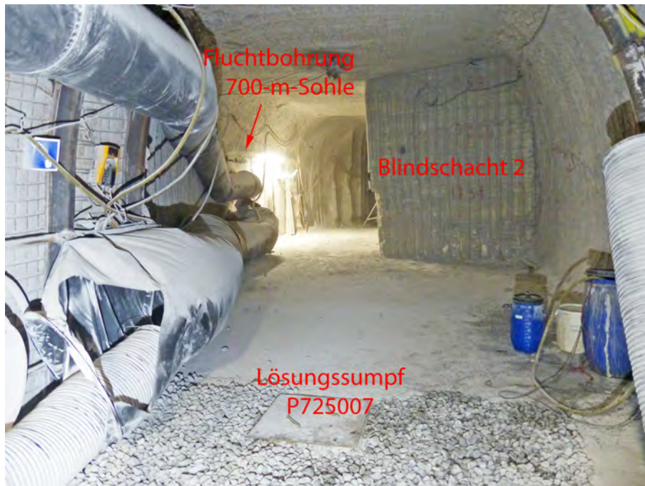
Abbildung 4.44: Nachgeschnittener Pfeiler 4/5, östlich des Lösungssumpfs (P725007) mit abgemauertem verfüllten Blindschacht 2 sowie nördlich davon in einer Nische verlaufende Fluchtbohrung zur 700-m-Sohle, Blick nach Osten, 06.01.2021
