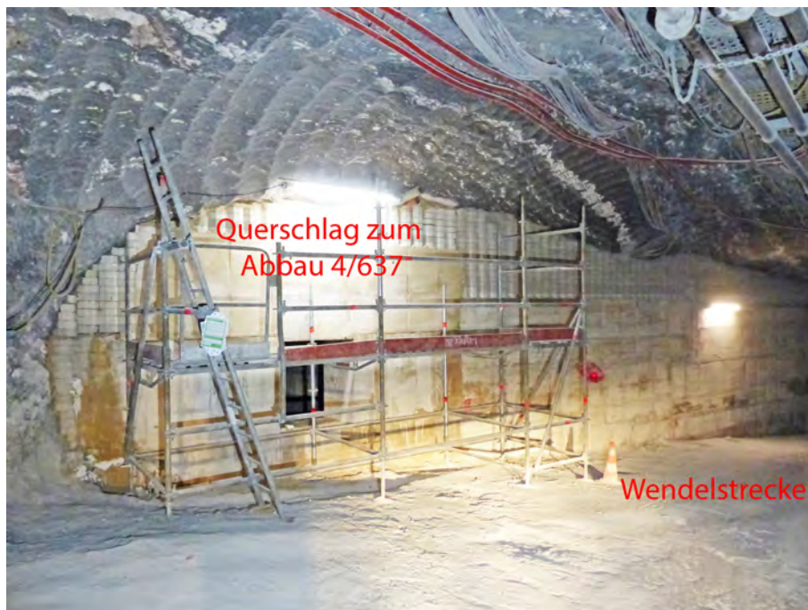
Abbildung 4.15: Abgemauerter Zugang des Querschlags zum Abbau 4/637 auf der 616-m-Sohle in östlicher Verlängerung der bereits erstellten Stützmauer am Wendelstreckensüdstoß, Blick nach Südwesten (05.01.2021)
