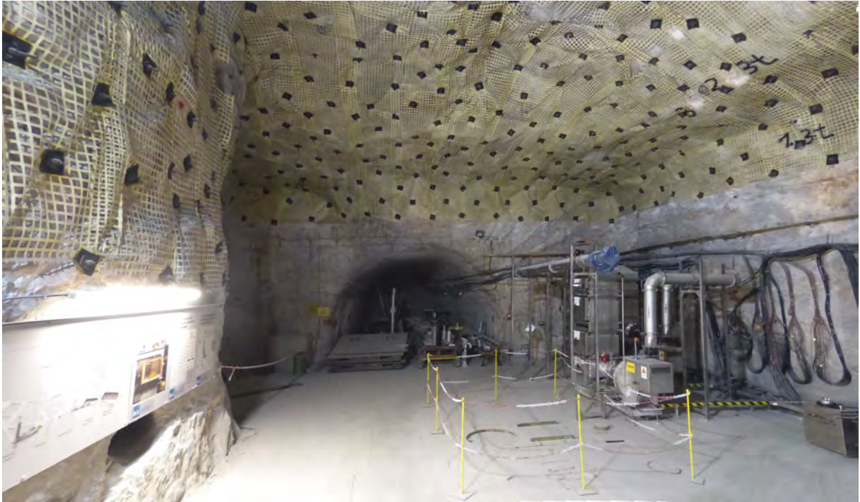
Abbildung 4.10: Blick vom Zugang zum Abbau 8/490 in die Beschickungskammer auf der 490-m-Sohle, Stand: 06.01.2021
