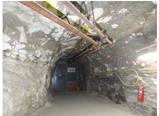
(b) Blick vom Schacht 4 auf den Zugang zum Füllort auf der 490-m-Sohle, Stand: 06.01.2021
