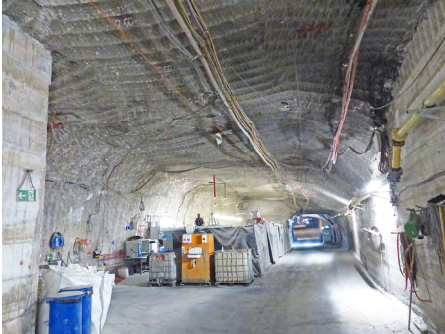
Abbildung 4.54: Als Pausenplatz genutzte Aufweitung der nördlichen Richtstrecke nach Osten, Blick nach Südosten (01.02.2021)
