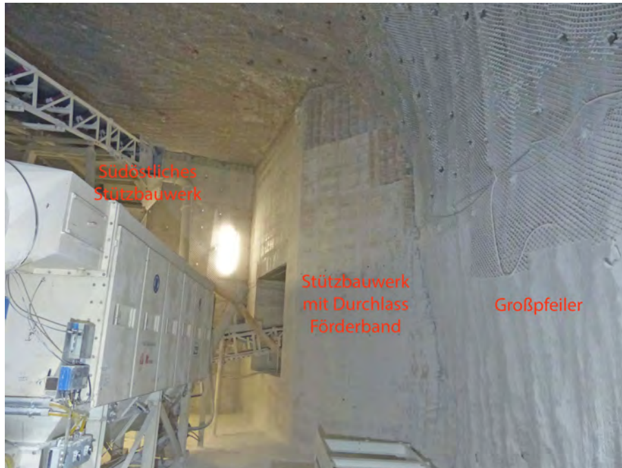
Abbildung 4.24: Fertiggestelltes Stützbauwerks zwischen Großpfeiler und Südstoß mit Anbindung an das firstbündige Stützbauwerk am südöstlichen Stoß der 20BA und Durchlass für das Förderband, Blick nach Südwesten (06.01.2021)
