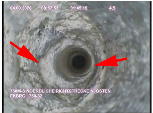
Bild 76: FKBrG. 750-32 – Position bei 4,5 m Übergang Steinsalz–Sorelbeton
