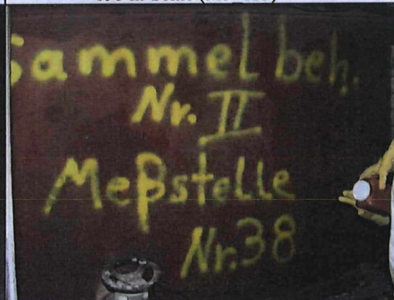
Photo 12: Sammelbehälter SaB2 (40-m 3 -Behälter) auf 725-m Sohle
