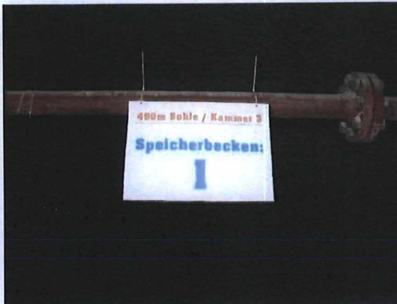
Photo 01: Messstellenbezeichnung Speicherbecken 1 auf 490-m-Sohle (MP SB1)
