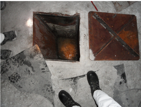
Bild 42: Sohlenschlitz vor dem Querschlag zwischen Kammer 8 und Abbau 9 auf der 750-m-Sohle P 750045 (BS: n. b.)
