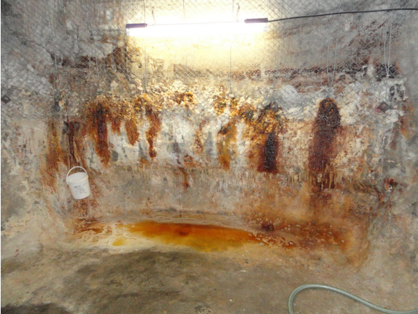
Bild 34 und 35: Laugensumpf östlich Kammer 9 auf der 750-m-Sohle P 750006-1 (BS: MP_36/1)
