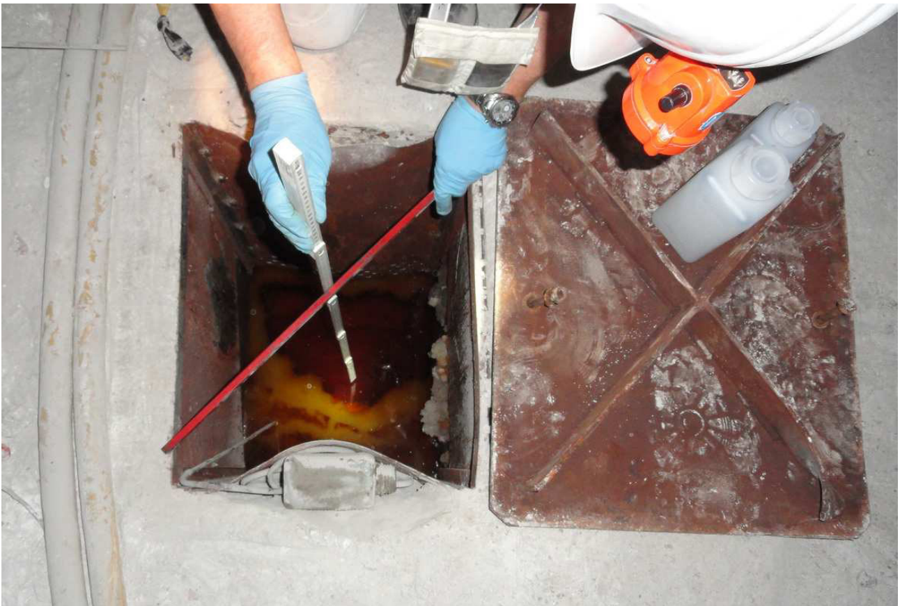
Abbildung 9: Probenahme an der Messstelle P 750041 vor dem östlichen Zugang zu der Einlagekammer 4 auf der 750-m-Sohle.
