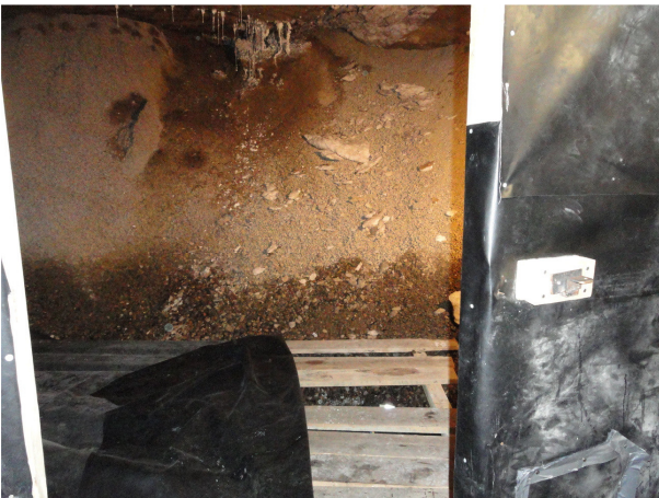
Bild 8 und 9: Frische Zutrittslösung auf der 658-m-Sohle L 658008 (BS: MP_27-Z)
