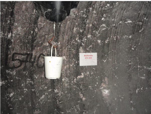
Bild 3: N-Stoß der Wetterstrecke zum Blindschacht 1/574 auf der 574-m-Sohle L 574010 (BS: n. b.)
