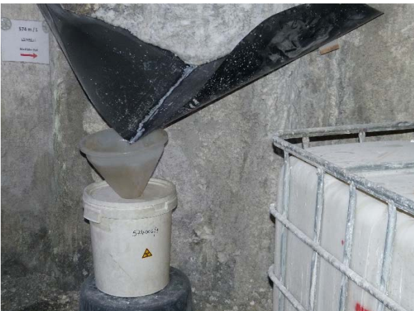
Bild 5: Zugang zum Abbau 3W/574 auf der 574-m-Sohle L574006/1
