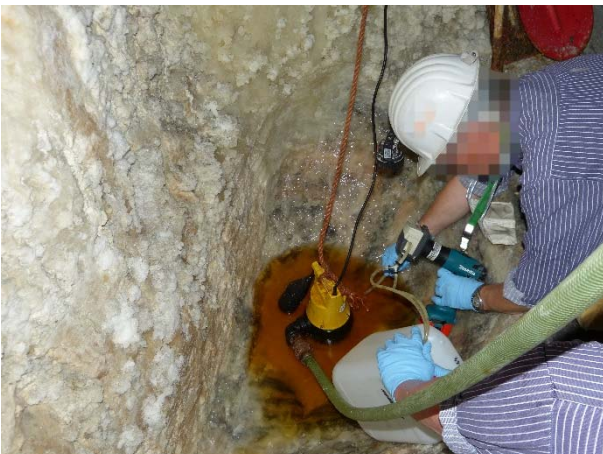
Bild 28: „Reichert-Sumpf-Süd“ auf der 750-m-Sohle P750064
