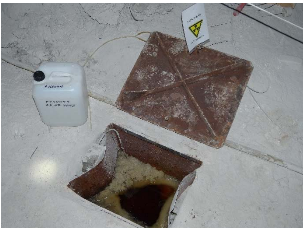
Bild 37: Schlitz vor dem Zugang zur Einlagerungskammer 4E auf der 750-m-Sohle P750041
