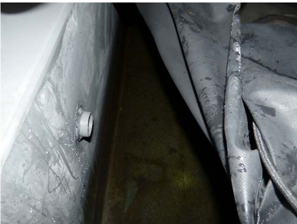
Bild 9: Salz aus L658008-S1 auf der 658-m-Sohle L658008-F
