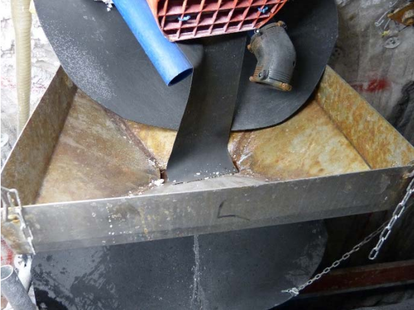
Bild 6: Bohrung 119 zwischen 658–637 Abbau 3 auf der 658-m-Sohle L658020
