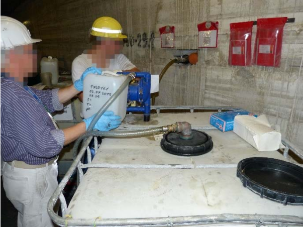
Bild 52: Erkundungsbohrung 750-9, Kaliabbau 9 auf der 750-m-Sohle P750161
