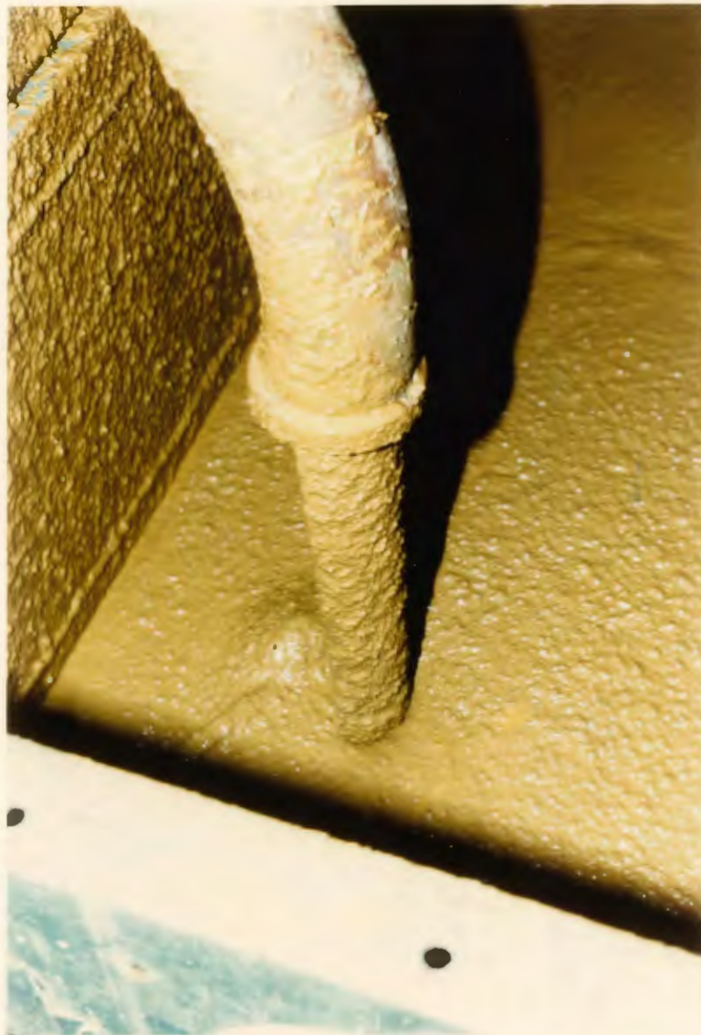
28. Rohraustrag in der Pumpenvorlage - Nebengestein
