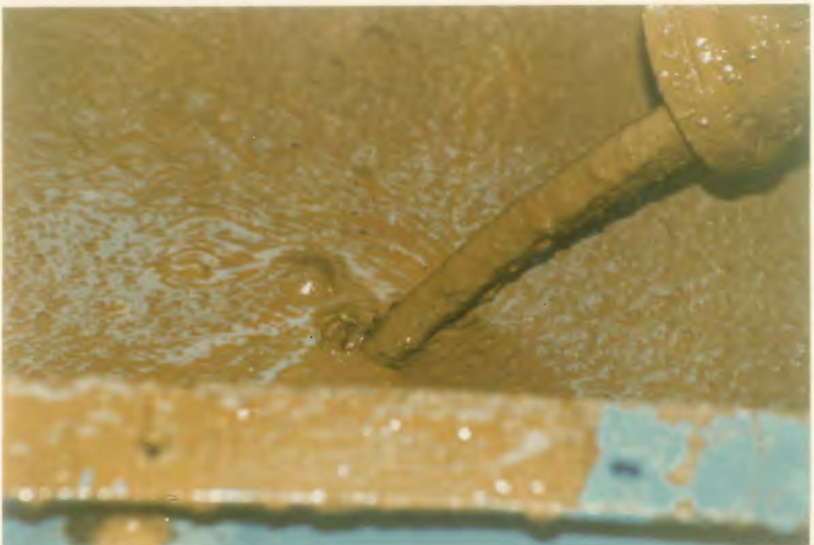
30. Rohraustrag in der Pumpenvorlage - Erz
