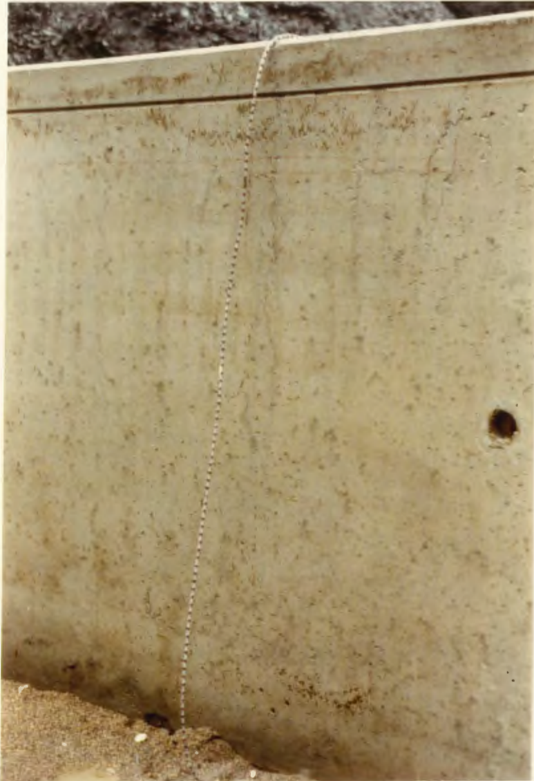
27. Umschlingung des Einschaltungsbauwerks
