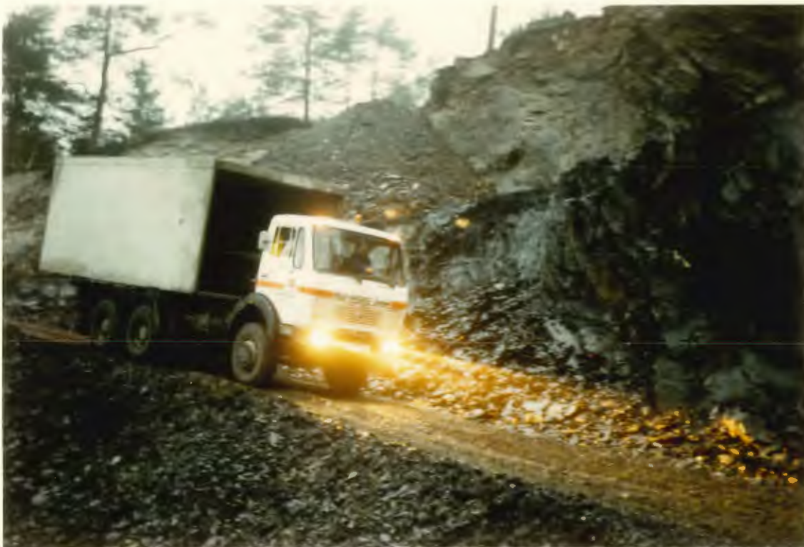
1. Anlieferung des Einschalungsbauwerks (Fertiggerage)
