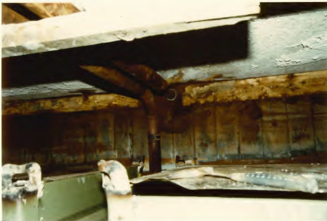
21. Verlorene Versatzrohrleitungen zur Befüllung des zweiten Teilverschlages
