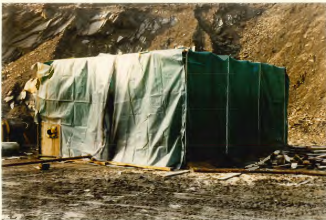
51. Beheiztes Winterbauzelt am Einschalungsbauwerk
