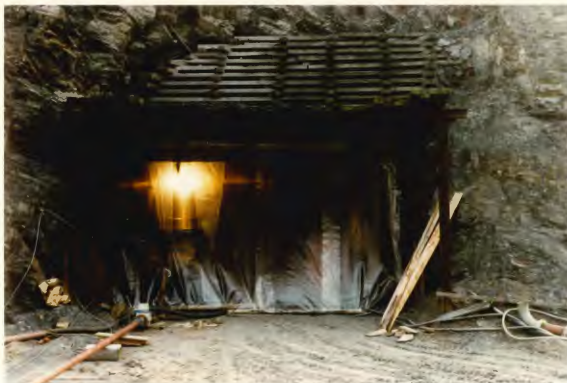
52. Abdichtung Mundloch der Bergeschachtstrecke
