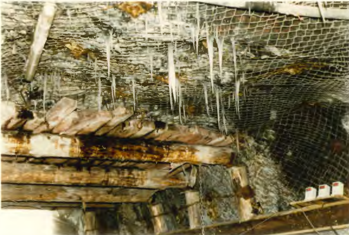
54. Firste der Bergeschachtstrecke
