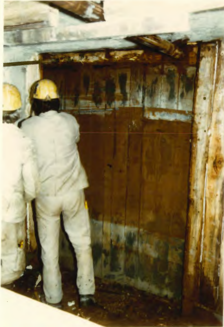
16. Abbau der Blenden
