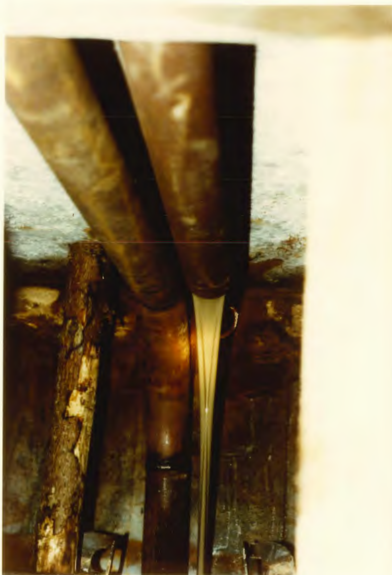
24. Einbringen der Zementsteintrennfuge
