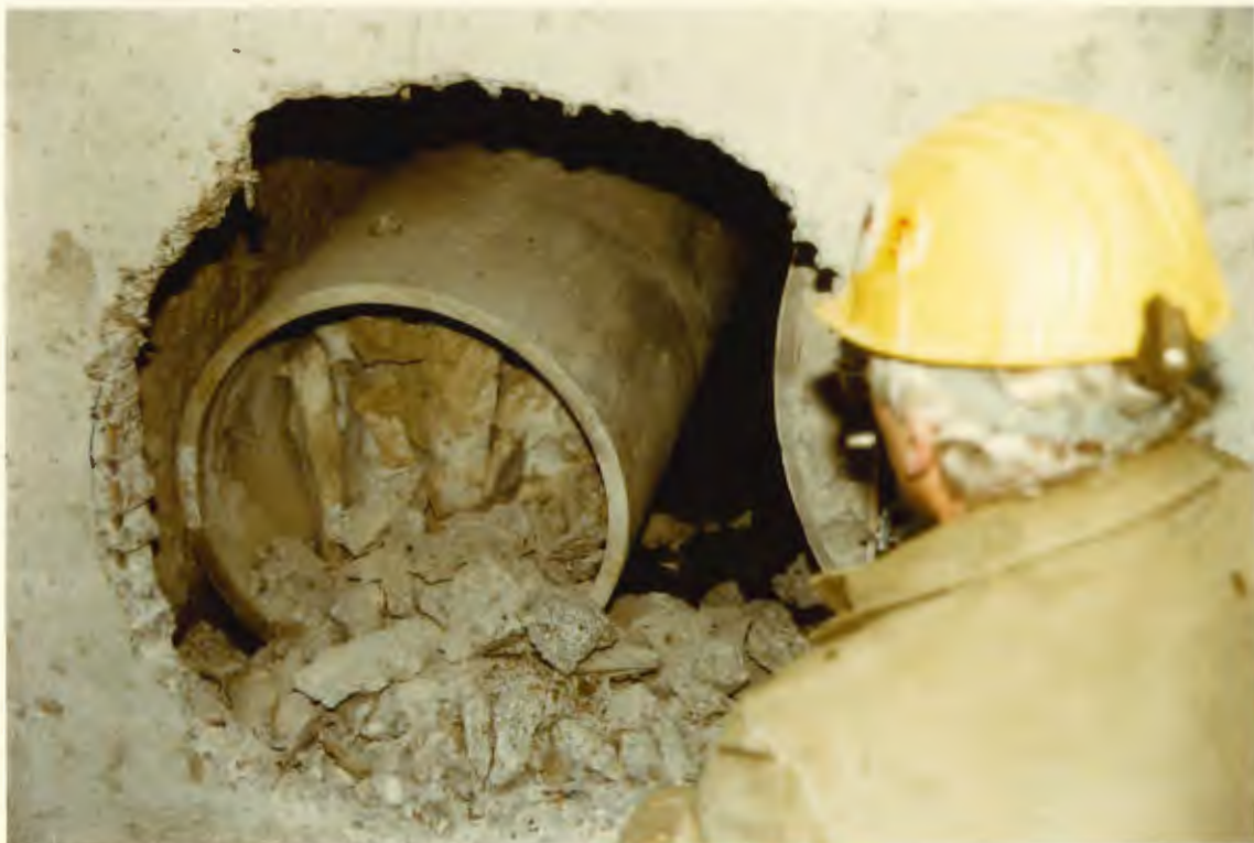
10. Ausbau des hinteren Eternitrohres
