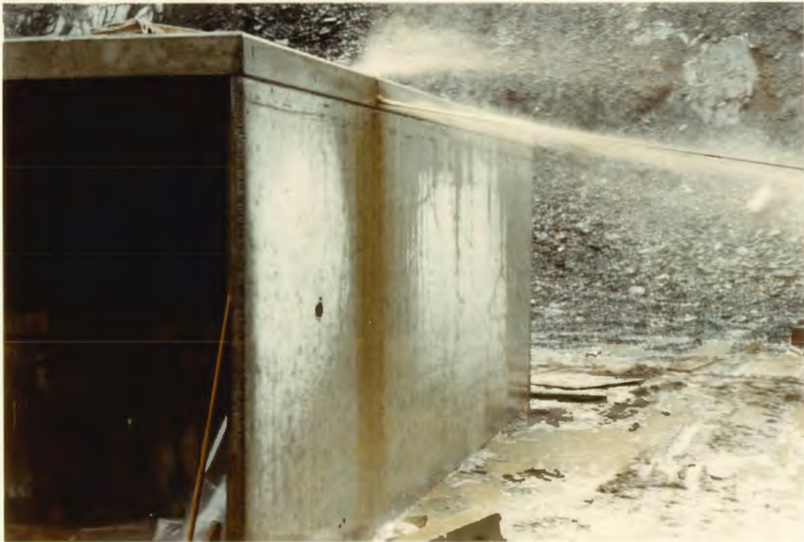
32. Sägeseil in Betrieb
