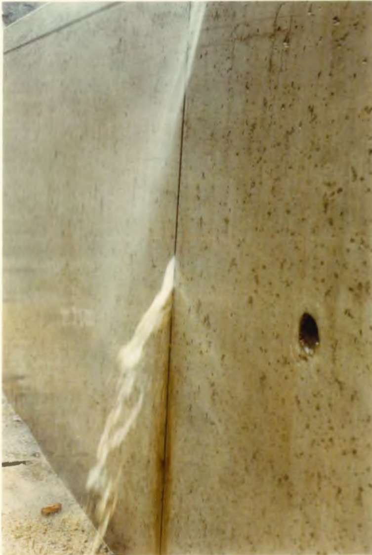
33. Sägeseil in Betrieb
