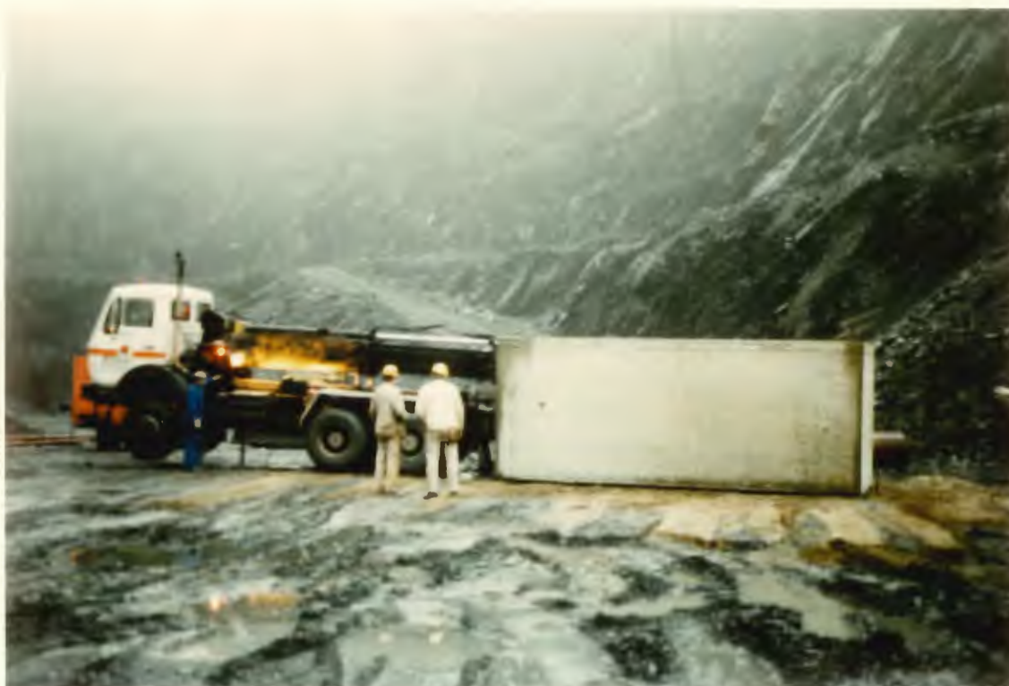
2. Aufstellung des Einschalungsbauwerks (Fertiggerage)
