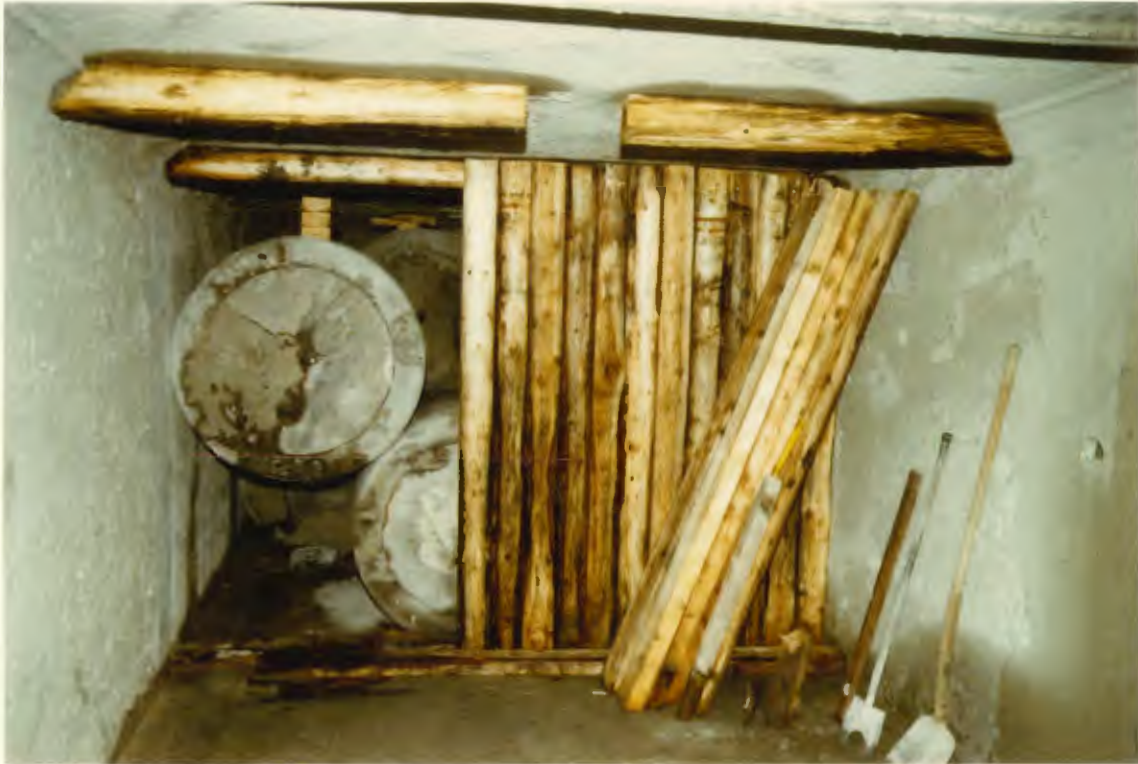
9. Zwickelraum nach Ausbau des vorderen Eternitrohres
