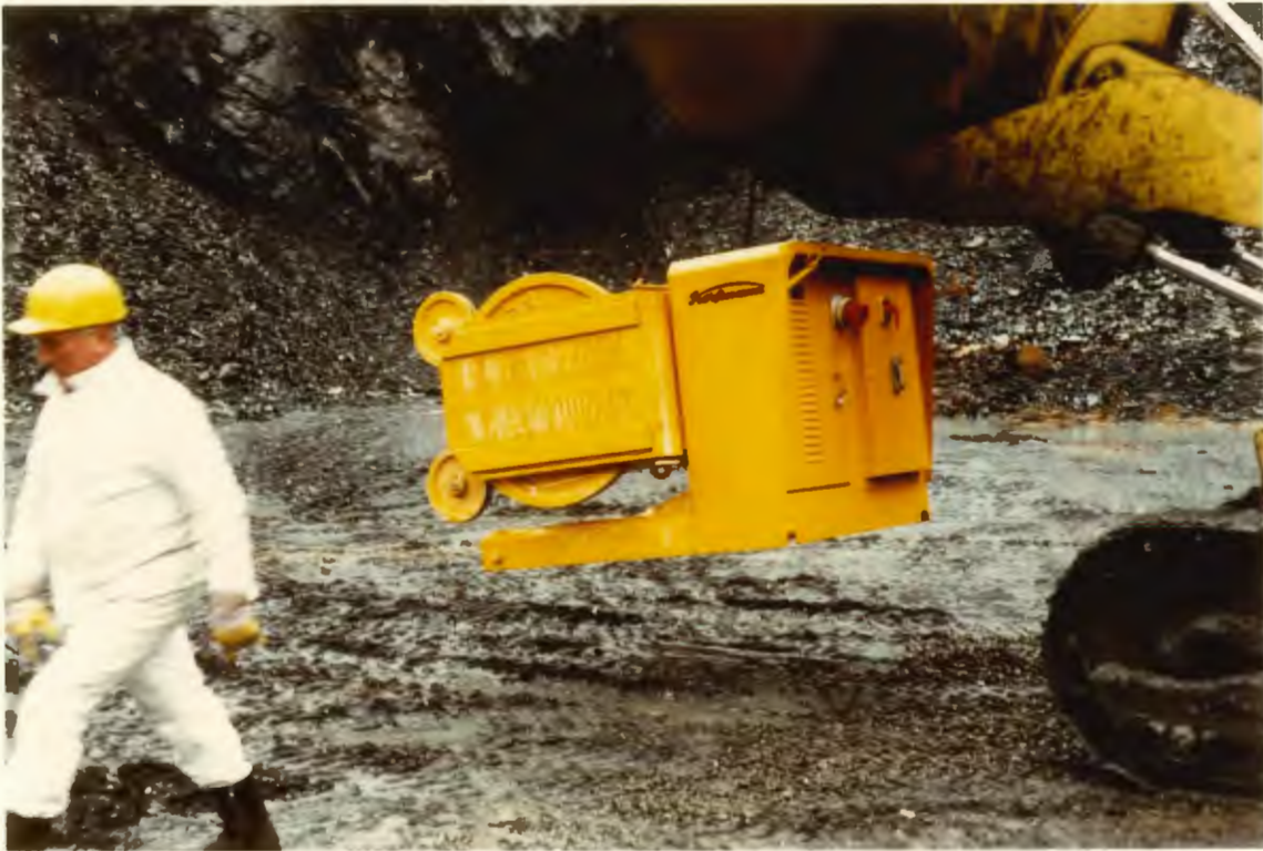
25. Anlieferung des Antriebsaggregates der Seilsäge
