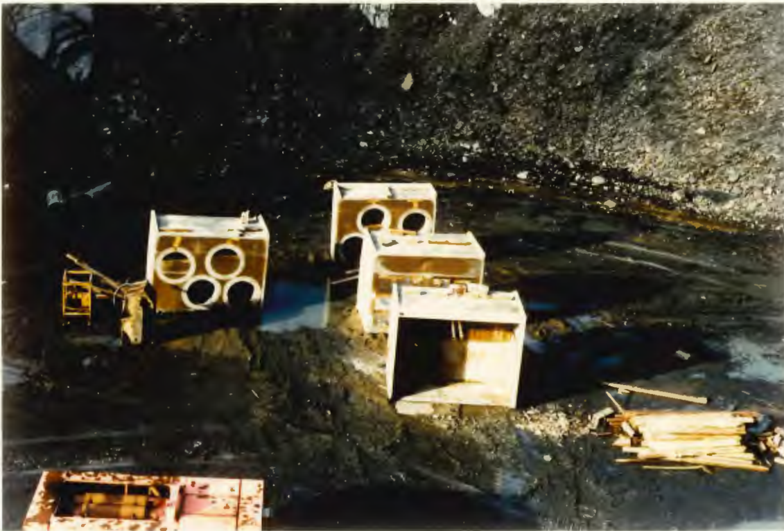
50. Einzelteile des zersägten Einschaltungsbauwerks
