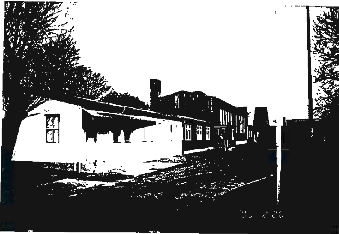
Foto 1: Ostansicht des Gesamtgebäudes
