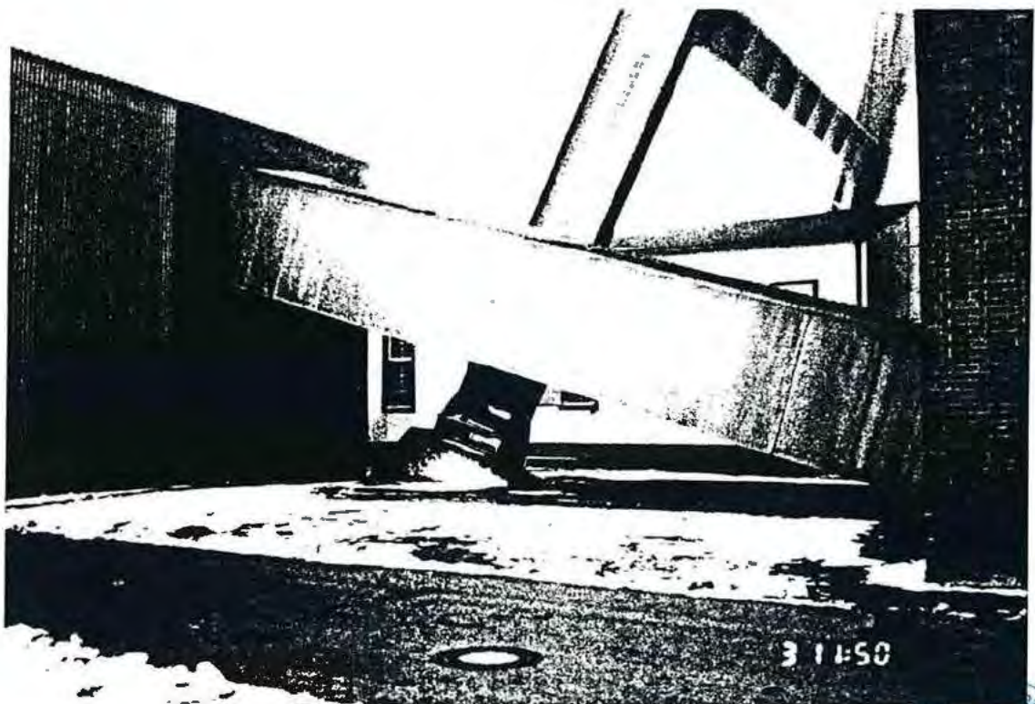
Foto 4: Verkleidung der Bandanlagen mit Asbestzementplatten
