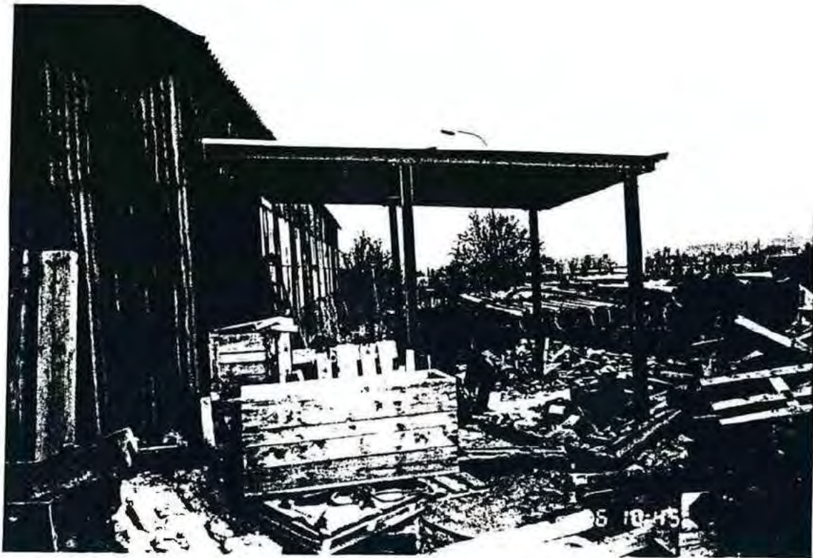
Foto 3: Vordach mit Wellasbestzementplatten-Eindeckung
