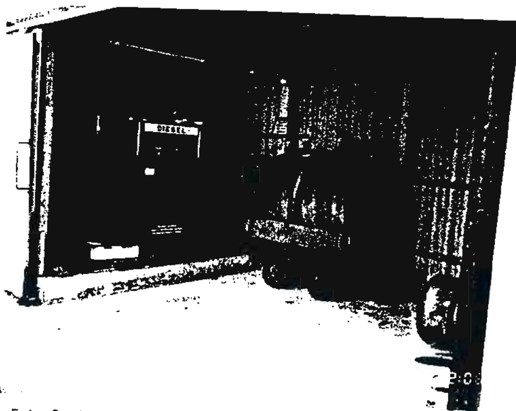
Foto 3: Innenansicht mit Zapfsäule
