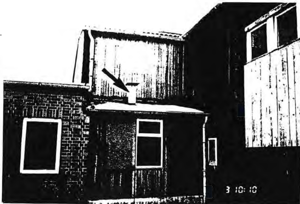
Foto 9: Westansicht Anbau mit Asbestzementlüftungsrohr
