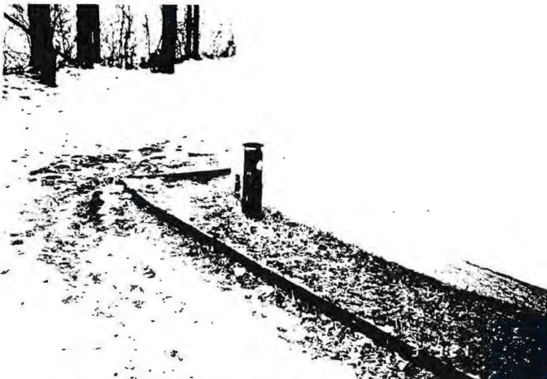
Foto 5: Lüftungsrohr neben Südwand des Gebäudes
