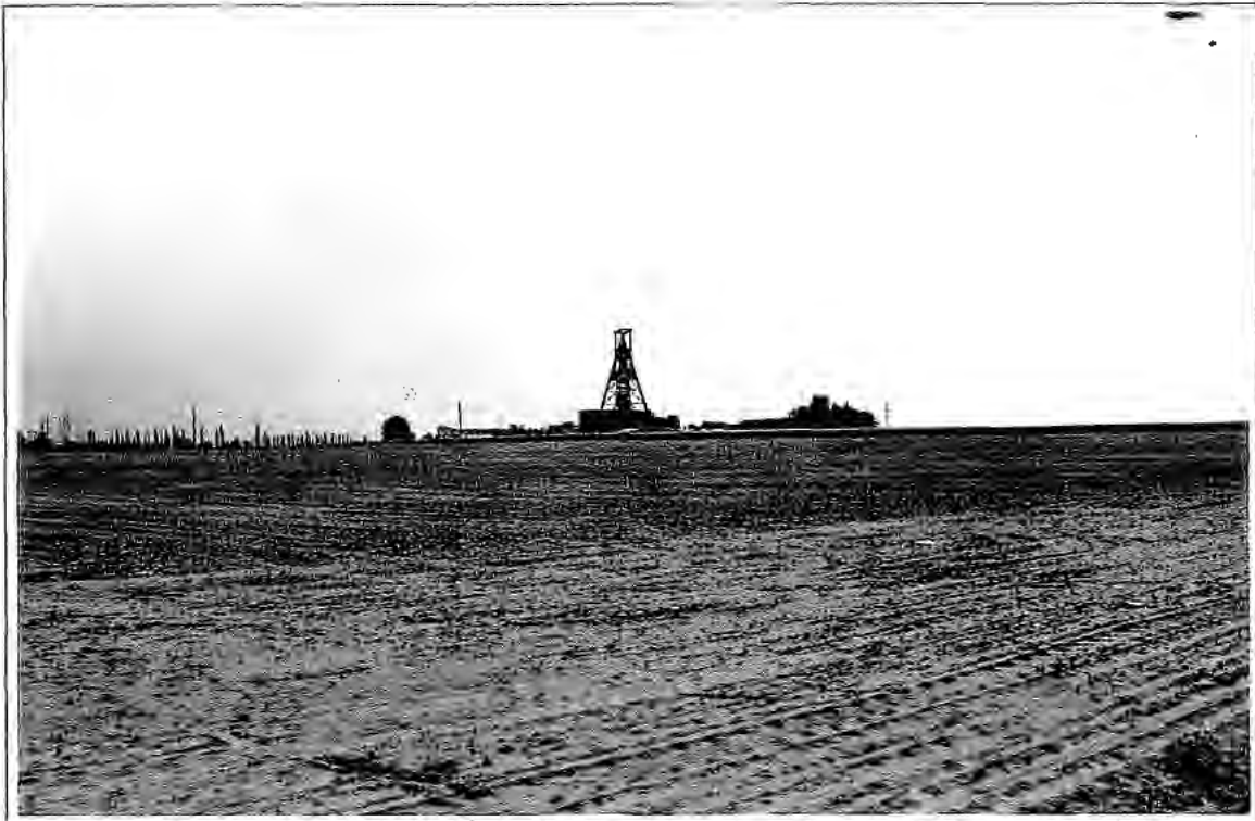
Foto 3: Tagesanlagen Schacht Konrad 1 von der Ortschaft Sauingen (Blickrichtung von Nordosten)
