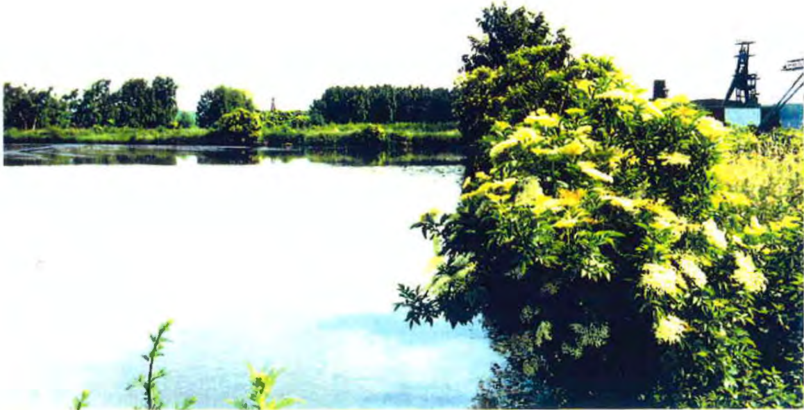
Foto 6: Blick über die Schlamm- und Klärbecken (Blickrichtung von Süden)
