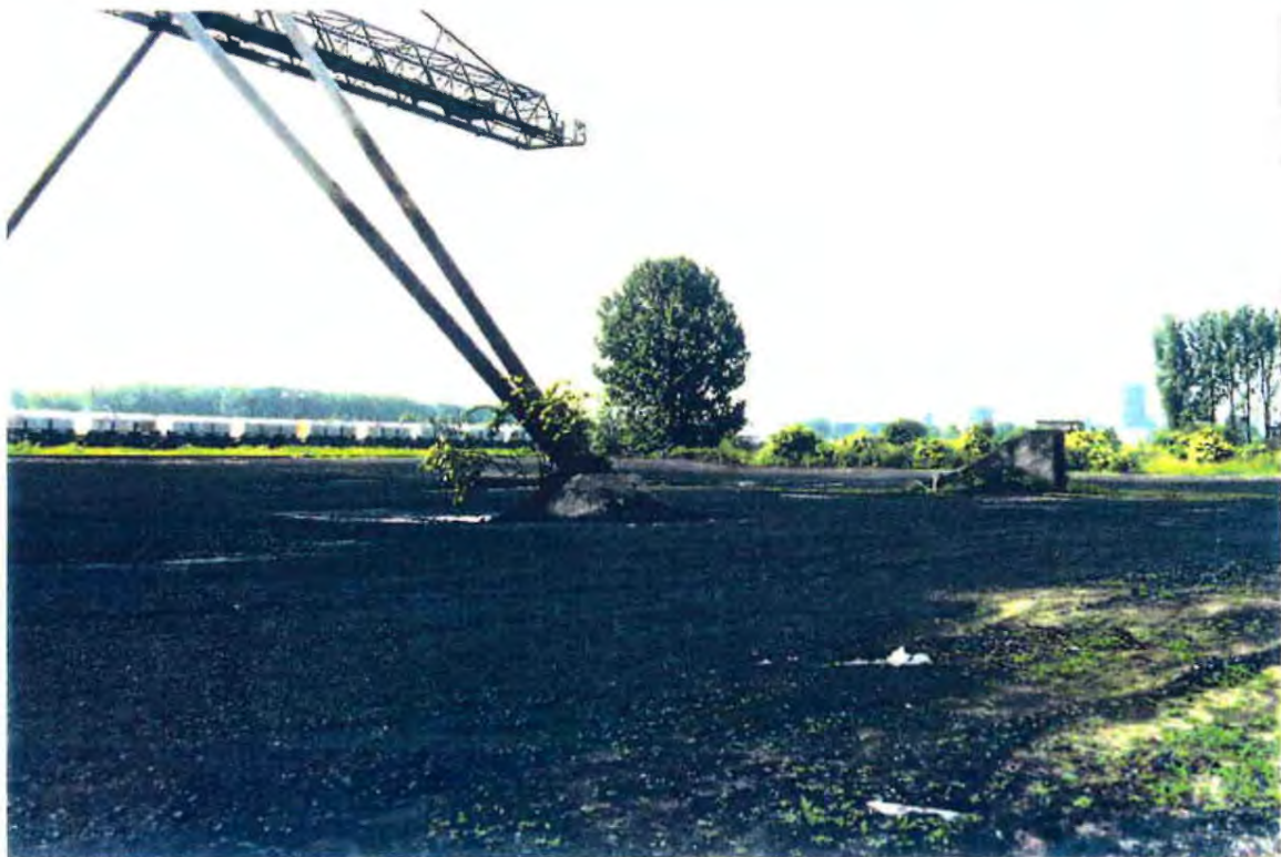
Foto 5: Südlicher Teil der Tagesanlagen Schacht Konrad 2 (Blickrichtung von Norden)
