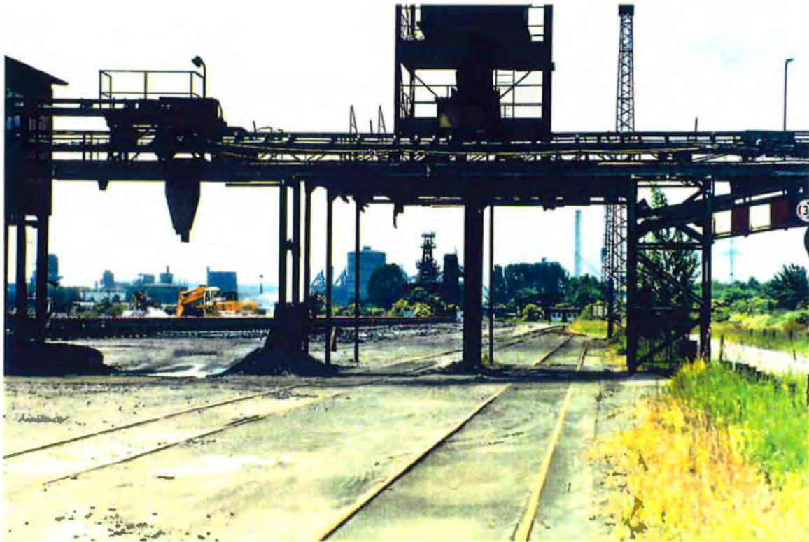
Foto 2: Schlackenwerk Beddingen, Gelände der Tagesanlagen Schacht Konrad 2 und Industriekulisse des Geländes der PSAG (Blickrichtung von Norden)
