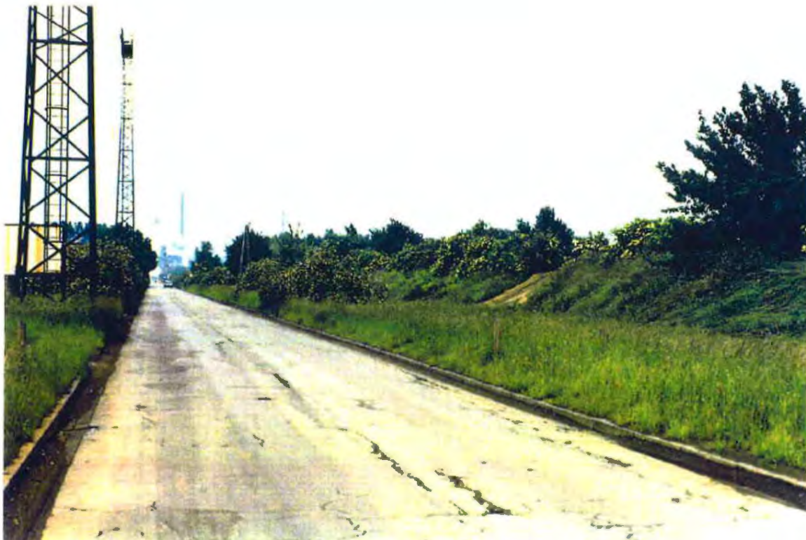
Foto 3: Werkstraße des Untersuchungsgeländes mit Böschung der Schlammbecken (Blickrichtung von Norden)
