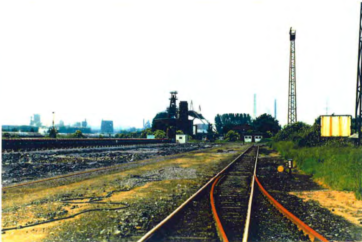
Foto 1: Gleisanlagen des Schlackenwerkes Beddingen, Gelände der Tagesanlagen Schacht Konrad 2 und Industriekulisse des Geländes der PSAG (Blickrichtung von Norden)
