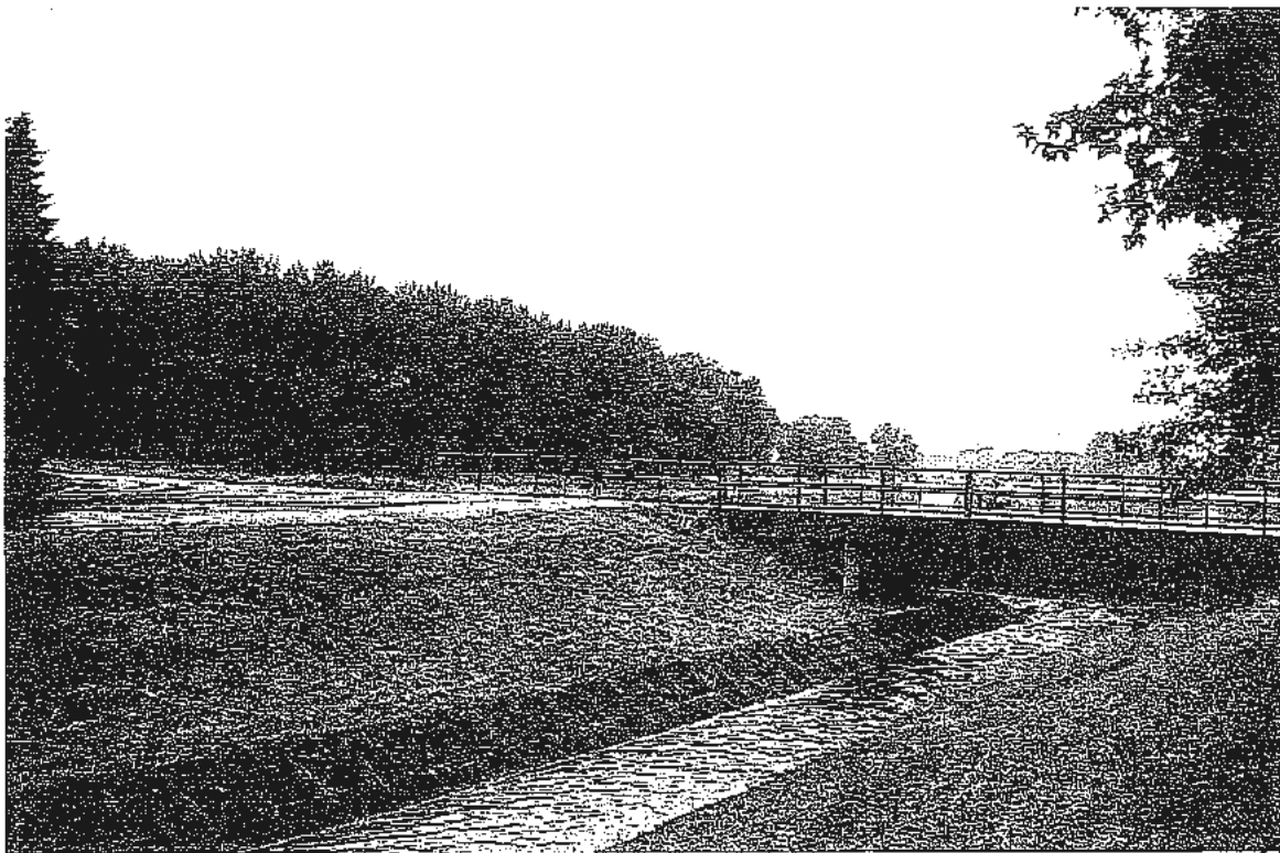
Bild 4: Zulaufgraben mit Regenrückhaltebecken - Bereich der Unterdükerung (Blickrichtung von Süd nach Nord).
