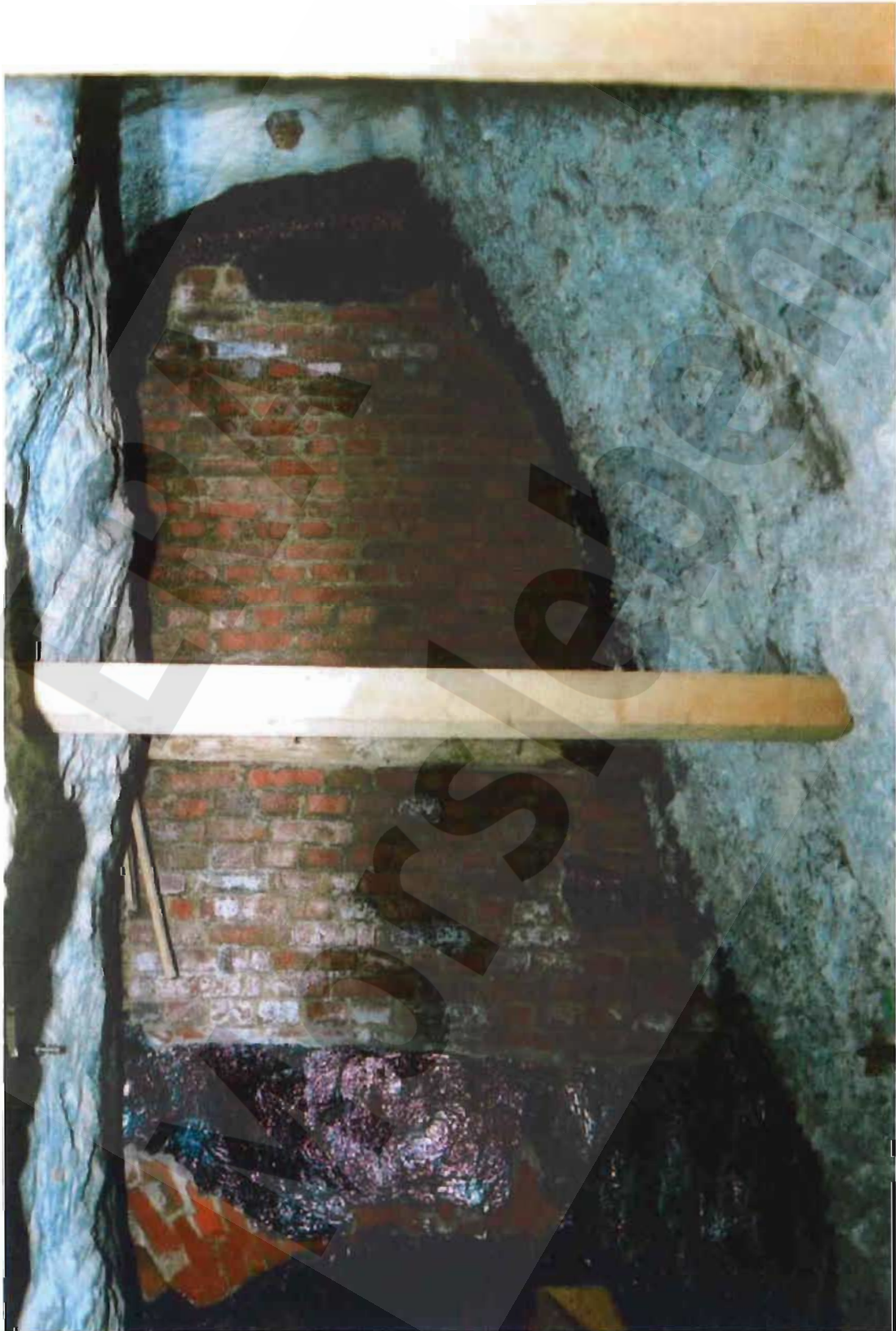
Bild 4: Gewölbesegment 20 von ca. -184 mNN bis -187 mNN Stirnfläche mit Konvergenzstrecke CG001K im Salinar Stand: 21.12.2000
