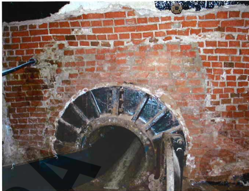
Bild 2: Ostseite des Dammtors Lager H (02AHB/HY001) im 2. Nordquerschlag der -231 mNN Sohle
