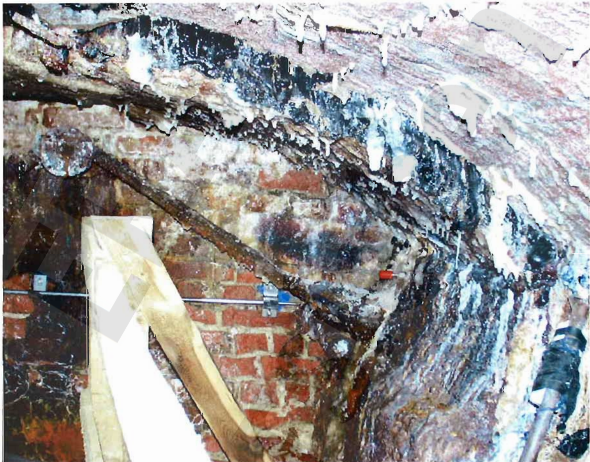
Bild 7: Westseite Gewölbesegment 12 bei -188 mNN und Stirnfläche Gewölbesegment 11 mit den Messstrecken CG007K und CG008E Stand: 23.01.2002
