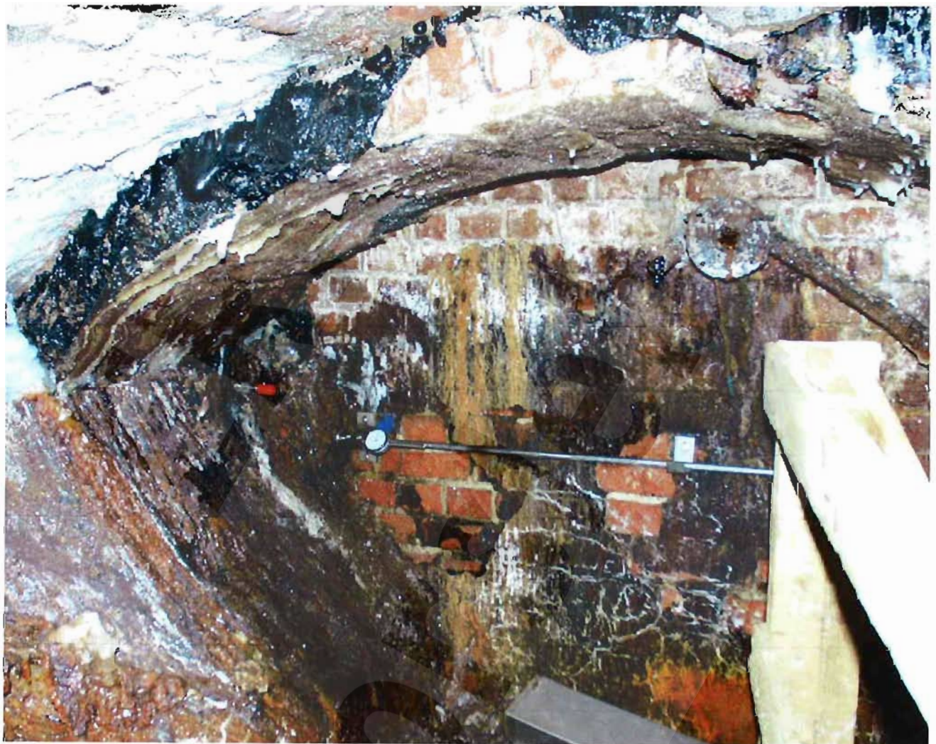
Bild 3: Ostseite Gewölbesegment 12 bei -188 mNN und Stirnfläche Gewölbesegment 11 mit den Messstrecken CG007K und CG008E mit Messuhr Stand: 23.01.2002
