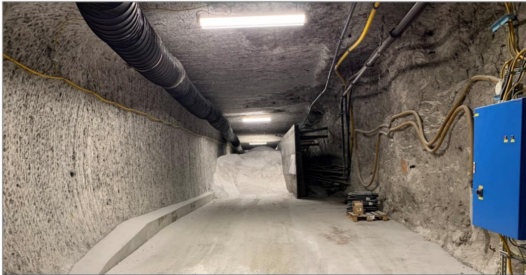
Errichtung eines Baustoffbunkers zur Lagerung des Trockenbaustoffes im Ausrichtungsquerschlag 2. Sohle
