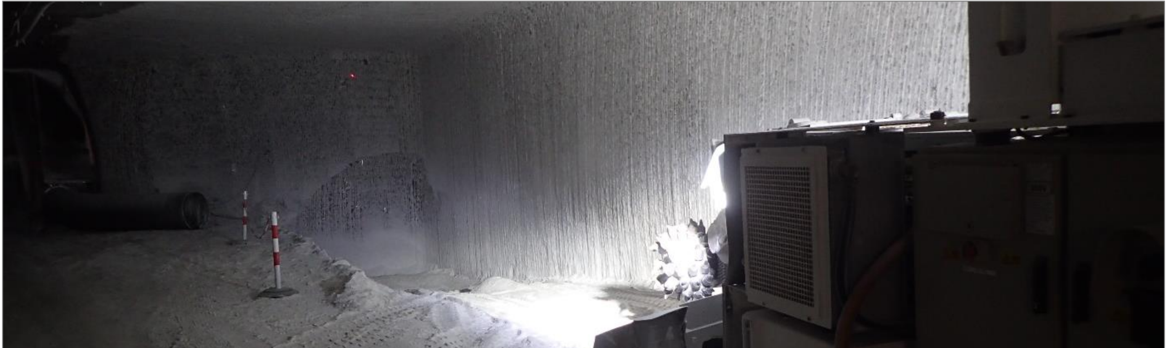
Herstellung der Bohrkammer auf der 2. Sohle
