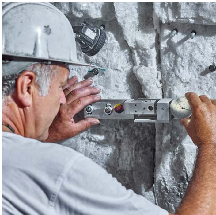
Ablesen eines Fissurometers zur Rissbeobachtung (2016)
