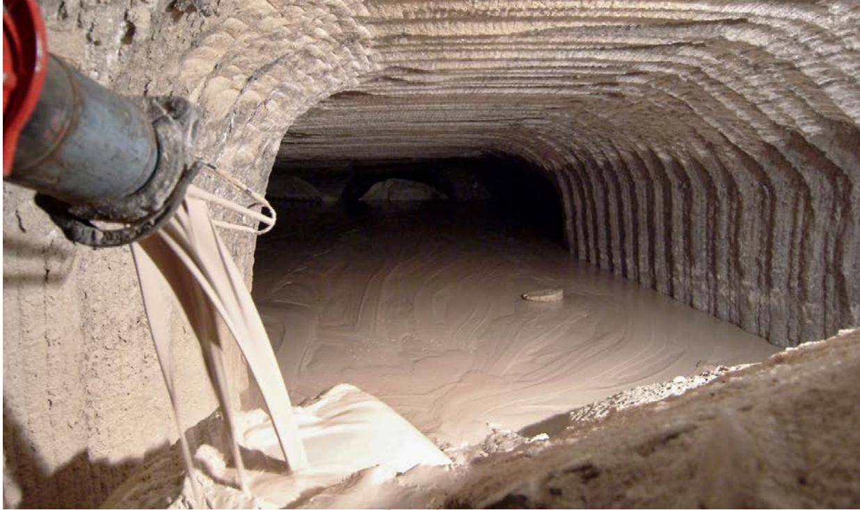
Verfüllung eines Hohlraums mit Sorelbeton (2012)
