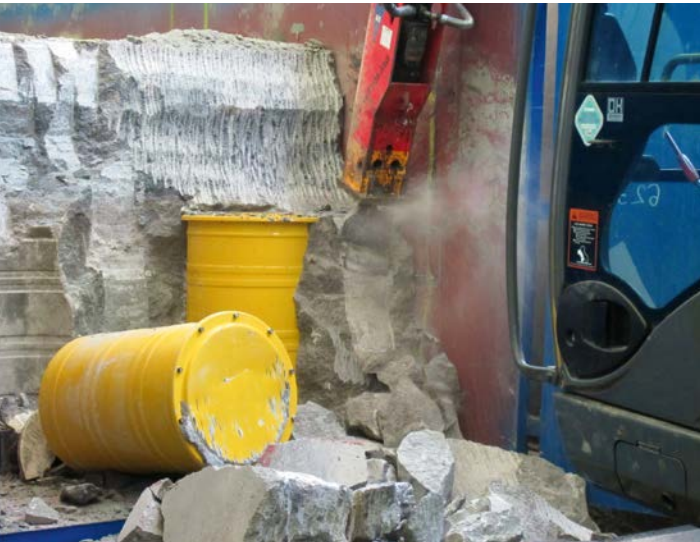
Freilegung von Abfallbehältern im Versuch (2014)
