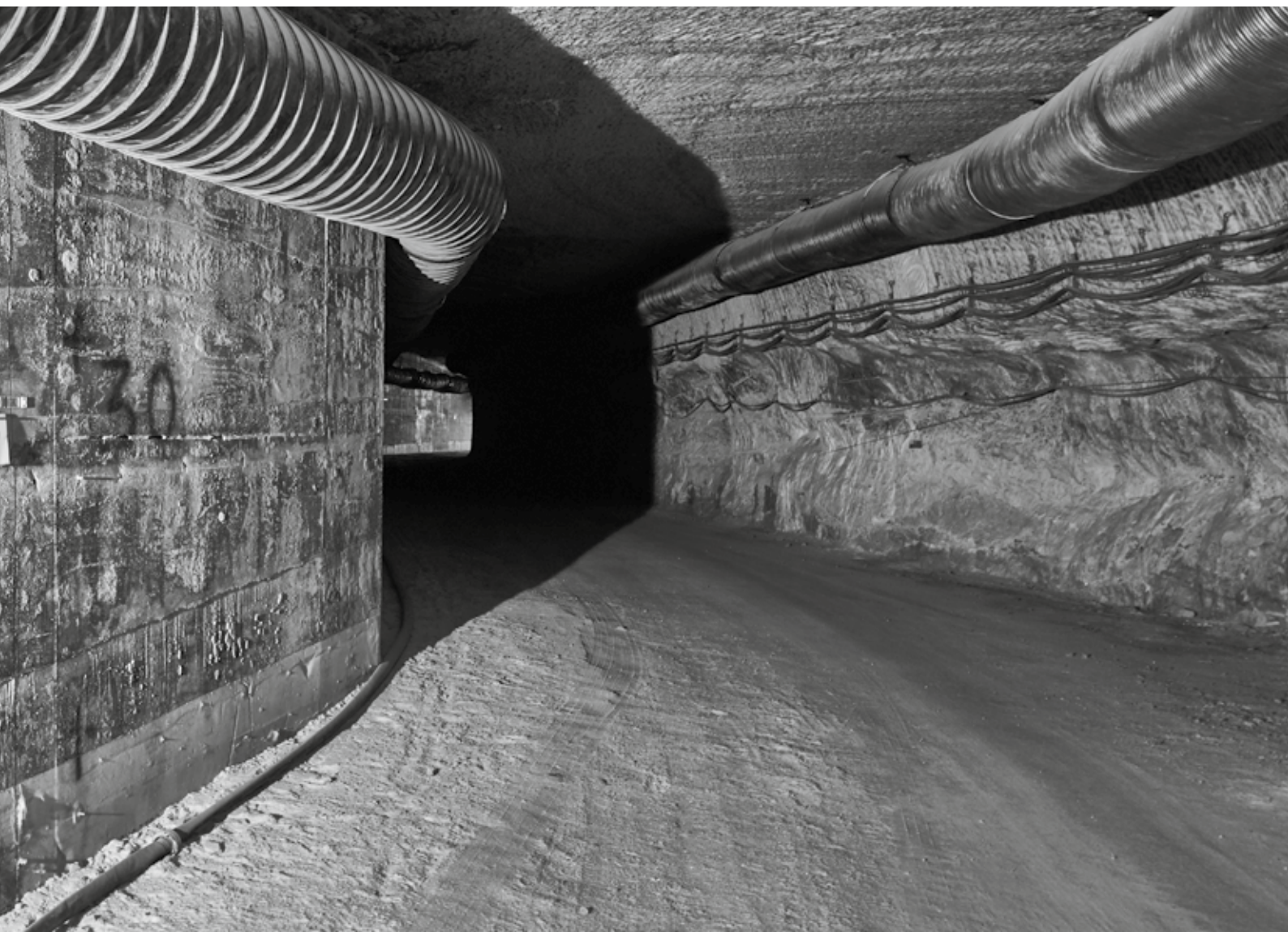
Blick auf einen verfüllten Abbau im Zentralteil der Grube Bartensleben
