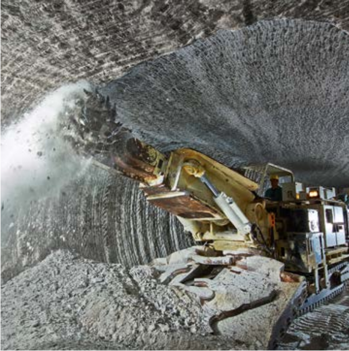
Die Modernisierung von Verbindungsstrecken minimiert den Wartungsaufwand und ermöglicht die Befahrung mit größerer Technik – eine Vorbedingung für die spätere Stilllegung des Endlagers.
