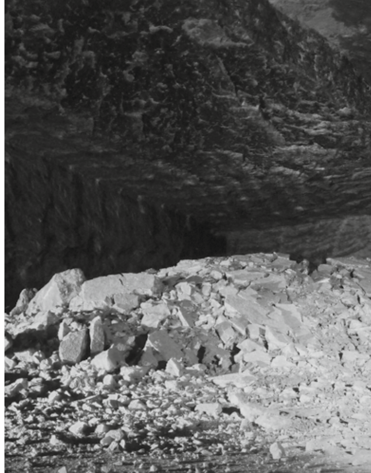
5.000 Tonnen Gestein, die von der Decke des Abbaus heruntergebrochen sind (vor der Stabilisierung des Zentralteils)
