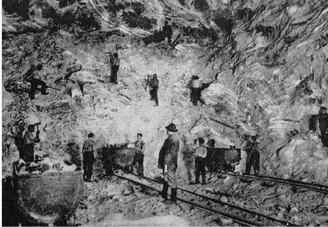
Abbau von Kalisalz ohne elektrische Energie: Gebohrt wird mit der Handbohrmaschine. Die Förderwagen werden mit einer Spitzschaufel beladen.
