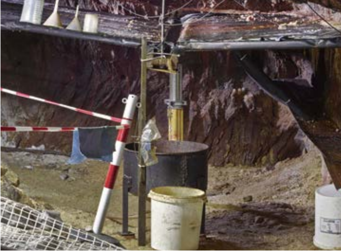
Tropfenzählanlage in Abbau 1a, 1. Ebene (Sohle) Schacht Bartensleben
