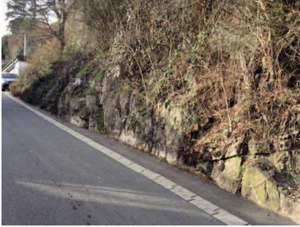
Abb. 11: Granitaufschluß an der nördlichen Seite am Neuer Weg im Stadtteil Ziegelhausen. Enge Zerteilung des Gesteins und deutliche Störungsflächen. (Nr. 4 in Abb. 7).
