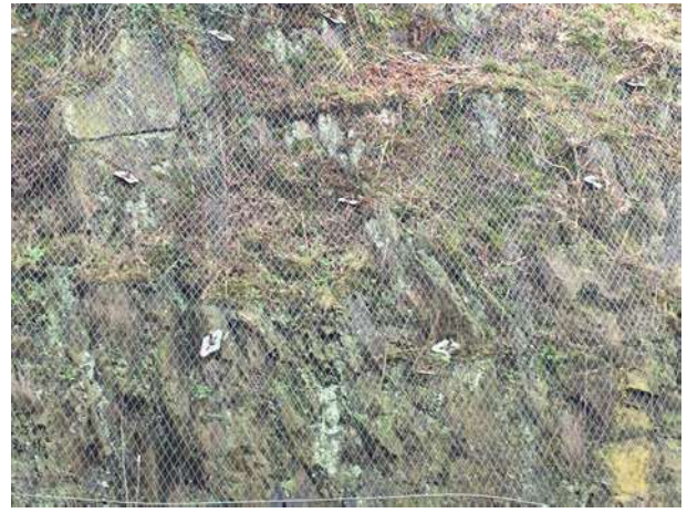
Abb. 14: Granitaufschluß an der südlichen Seite der Schlierbacher Landstraße (B 37) im Stadtteil Schlierbach. Enge Zerteilung des Gesteins. (Nr. 7 in Abb. 7).
