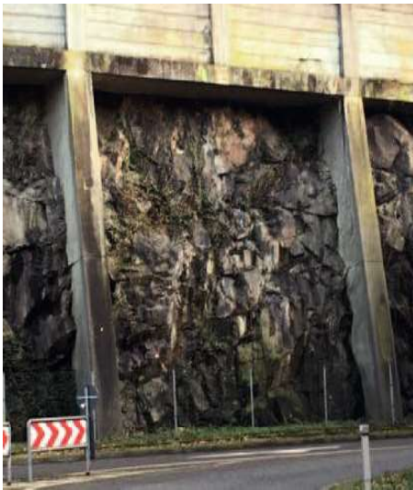
Abb. 20: Granitaufschluß an der südlichen Seite des östlichen Ausgangs vom Schloßbergtunnel im Stadtteil Altstadt. Enge Zerteilung des Gesteins. (Nr. 11 in Abb. 7).
