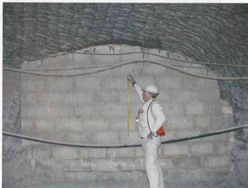
Abbildung 30: Westlicher Zugang zur ELK 8/750 Blick von der 2. südlichen Richtstrecke nach Westen Archiv Nr.: 20081126_17-1.jpg; Aufnahme vom 26.11.2008
