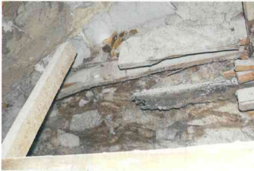
Abbildung 37: Nördlicher Zugang zur ELK 4/750, Wetterverschlag Blick von der 2. südlichen Richtstrecke nach Westen hinter den derzeitigen Wetterverschlag Archiv Nr.: 20090115-1; Aufnahme vom: 15.01.2009
