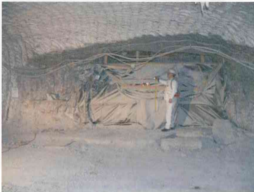
Abbildung 36: Nördlicher Zugang zur ELK 4/750 mit derzeitiger Wetterverschlag Blick von der 2. südlichen Richtstrecke nach Westen Archiv Nr.: 20081126_19-1; Aufnahme vom: 26.11.2008
