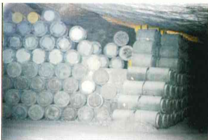
Abbildung 2: Einlagerungskammer 7/750, gestapelte verlorene Betonabschirmung (VBA) Archiv Nr.: e 223, Aufnahme vom 27.10.1977
