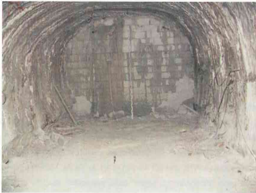
Abbildung 46: Querschlag zwischen Abbau 5/750 (Na2) und ELK 7/750 (Firstniveau) Blick von Abbau 5/750 (Na2) auf das Verschlussbauwerk zum Querschlag zur ELK 7/750 Archiv Nr.: 7_750dig240401_01; Aufnahme vom 24.04.2001
