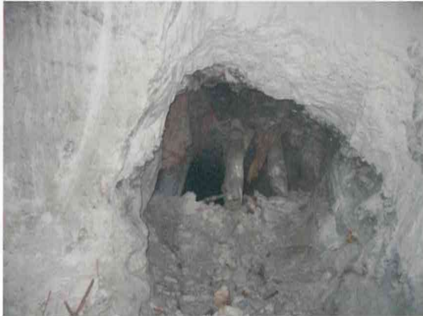
Abbildung 27: Rollloch von der 725-m-Sohle in die Firste der ELK 10/750 Blick von der 725-m-Sohle Archiv Nr.: 20080519_IMG_1298; Aufnahme vom 19.05.2008
