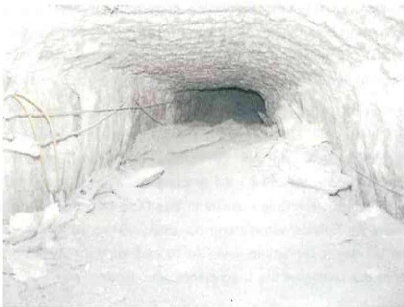
Abbildung 42: Durchhieb zwischen Abbau 3/750 und ELK 5/750 (Firstniveau) Blick von Abbau 3/750 zur ELK 5/750 Archiv Nr.: IMG_4033.jpg; Aufnahme vom 06.05.2009
