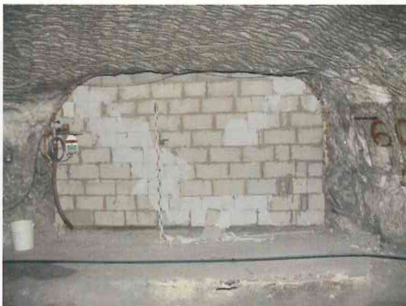
Abbildung 34: Nördlicher Zugang zur ELK 4/750 mit Abschlussmauer Blick von der 2. südlichen Richtstrecke nach Westen Archiv Nr.: 4_750ostdig230401; Aufnahme vom 23.04.2001
