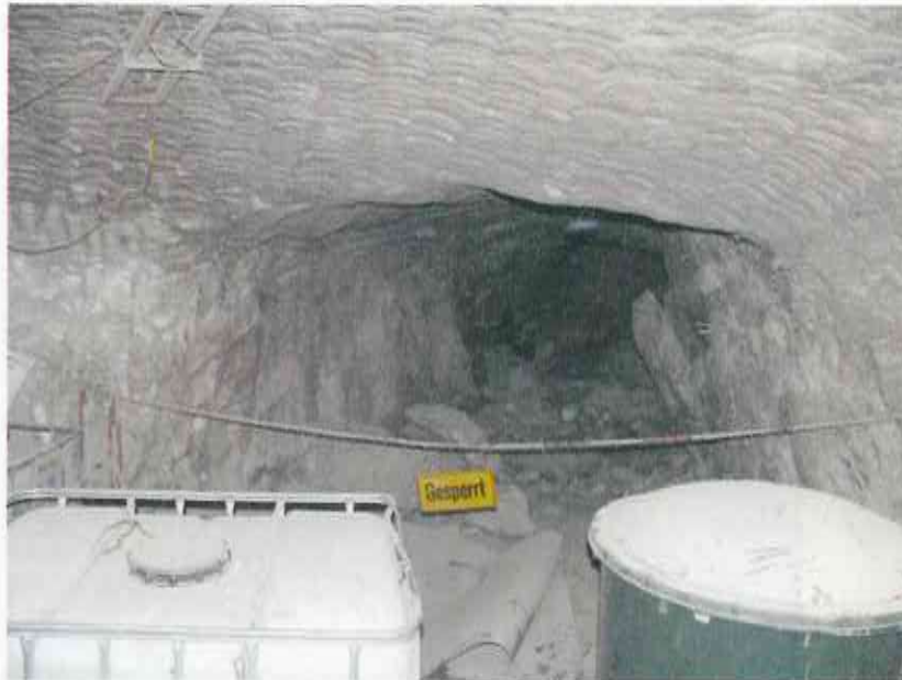
Abbildung 28: Durchhieb zwischen ELK 8/750 und Abbau 9/750 Blick von der 2. südlichen Richtstrecke nach Westen Archiv Nr.: 20081126_14b-2.jpg; Aufnahme vom 26.11.2008
