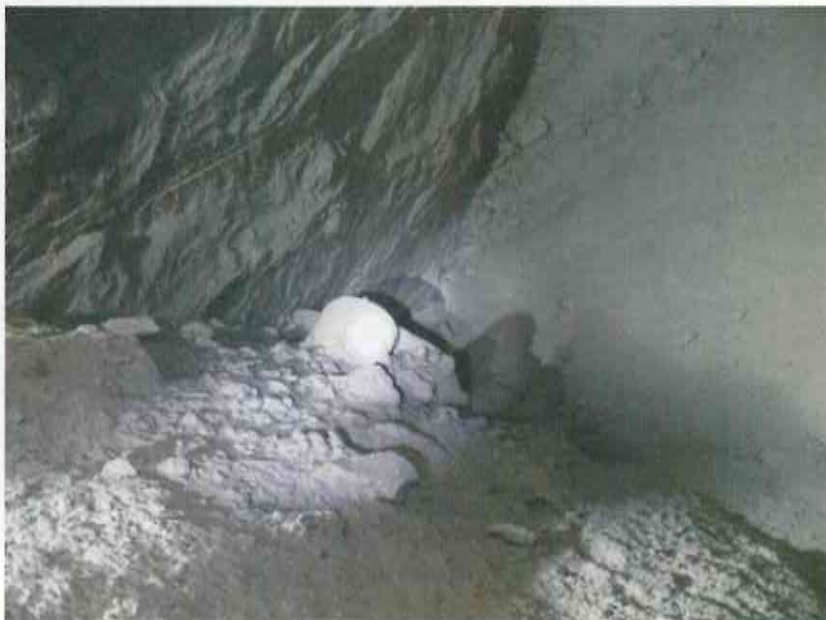
Abbildung 22: ELK 7/725 (Na 2 ), Blick auf die Abkippböschung Archiv Nr.: 20081126_1-3.jpg; Aufnahme vom: 26.11.2008
