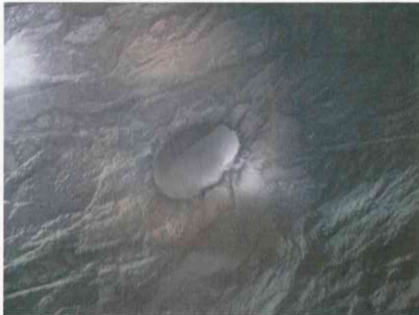
Abbildung 55: Wetterbohrung zw. ELK 7/725 (Na2) und der Wendelstrecke Blick aus der ELK gegen den nördl. Stoß und die Austrittsstelle der Wetterbohrung Archiv Nr.: 20081126_1-1.jpg; Aufnahme vom 26.11.2008
