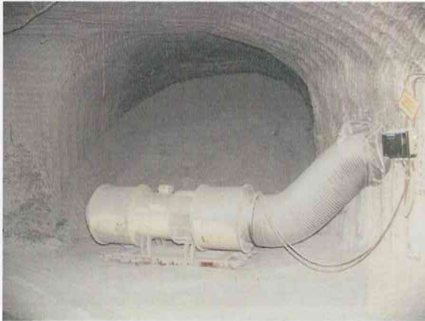
Abbildung 57: Östlicher Querschlag zur ELK 7/725 (Na2) im Firstniveau Blick von der Wendelstrecke i. d. östl. Querschlag zur ELK und gegen d. Wetterbrg. (Abbildung 56) Archiv Nr.: 7_725dig240401_03; Aufnahme vom 24.04.2001
