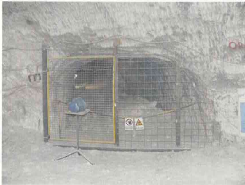
Abbildung 43: Durchhieb zwischen Abbau 3/750 und ELK 5/750 (Firstniveau) Blick von Abbau 3/750 zur ELK 5/750 Archiv Nr.: 20081126_21-1.jpg; Aufnahme vom 26.11.2008
