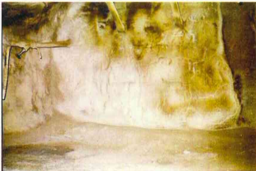
Abbildung 33: Nördlicher Zugang zur ELK 4/750 mit Spritzbeton versehene Schalungsmauer Blick von der 2. südlichen Richtstrecke nach Westen Archiv Nr.: C 603; Aufnahme vom: 27.10.1977
