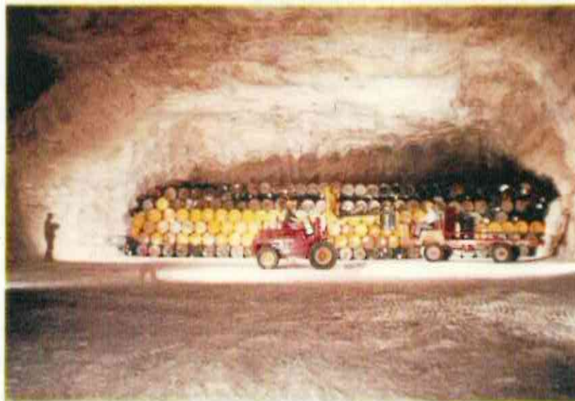
Abbildung 19: ELK 1/750, Gestapelte Fässer auf der Ausgleichsschicht Archiv Nr.: c 301; Aufnahme vom März 1970
