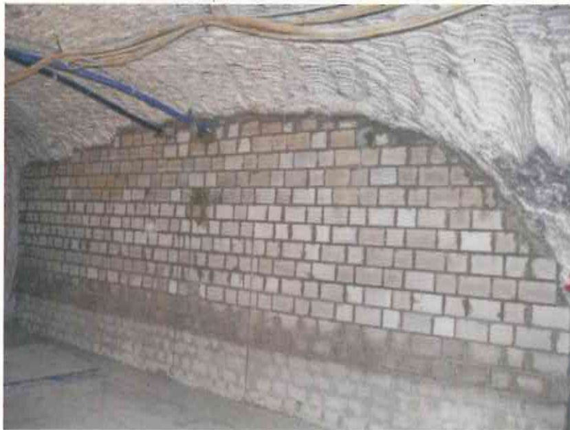
Abbildung 38: Nördlicher Zugang zur ELK 4/750 mit neuer Abschlussmauer Blick von der 2. südlichen Richtstrecke nach Westen Archiv Nr.: L1050648, Aufnahme vom 04.03.2009
