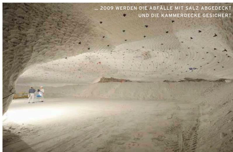
... 2009 WERDEN DIE ABFÄLLE MIT SALZ ABGEDECKT UND DIE KAMMERDECKE GESICHERT
