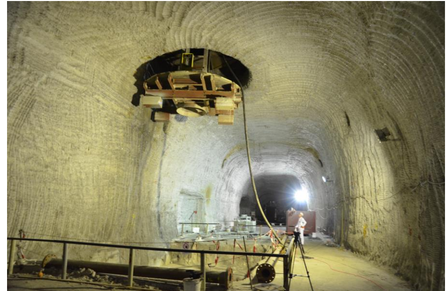
Einkürzen der Baustoffleitung auf der 850-m-Sohle
