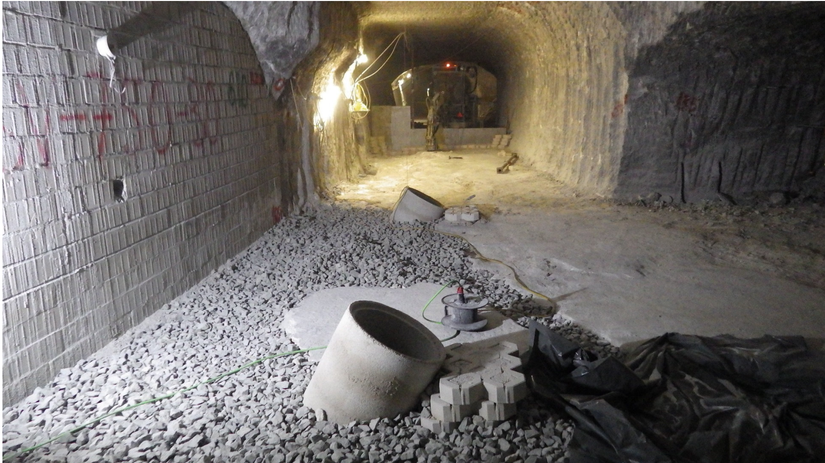
Abbildung 3: SV-750-21, Katasterstelle P7500042, Vorbereite der Schachtringe im Schotterbett, redundante Schachtringsäule vor Zugang ELK 4/750 , 08.11.2016
