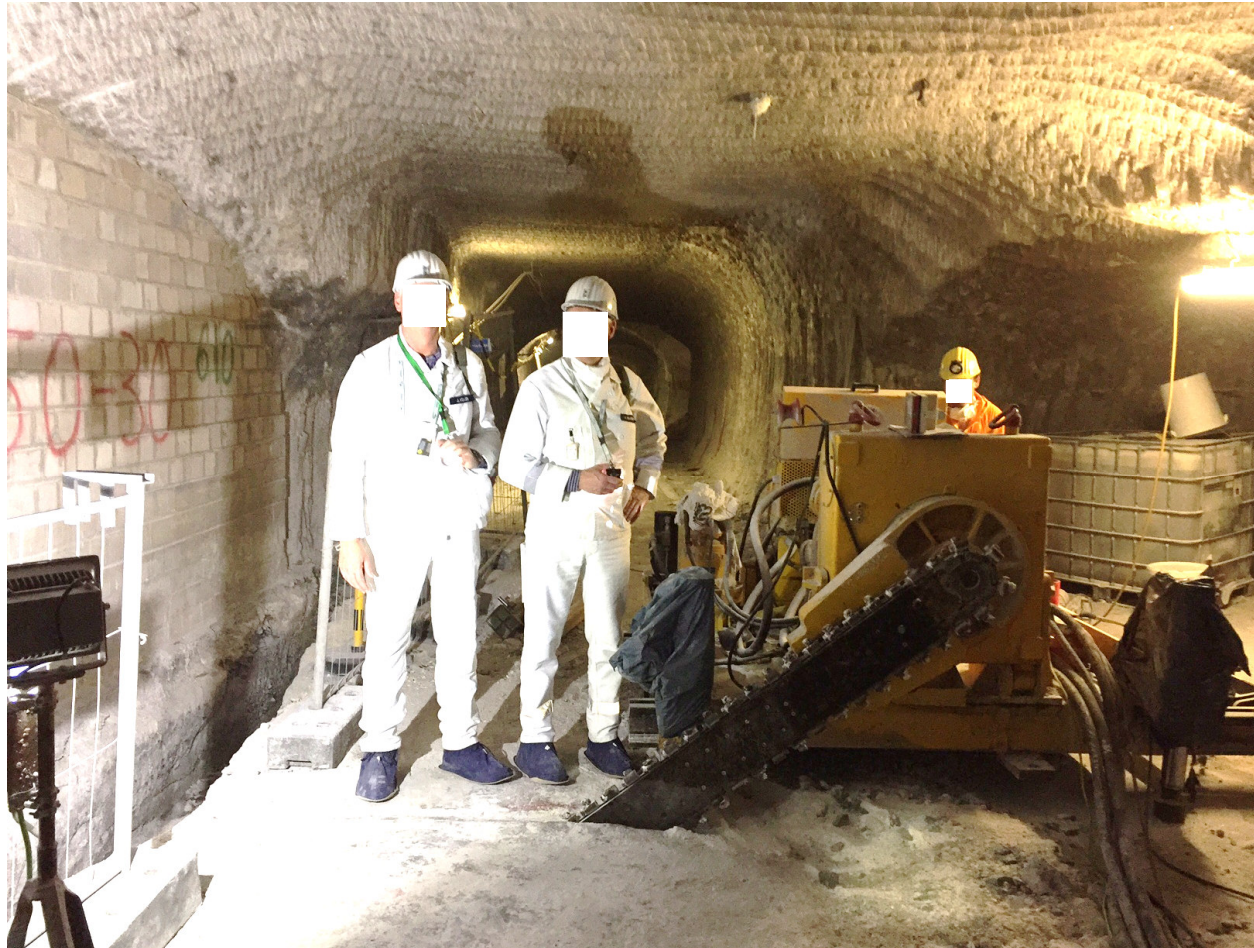
Abbildung 2: östl. Zugangsbereich, Sicherheitsbefahrung und Zustandsbeurteilung des Sägeblattes der Korfmann-Säge, 27.10.2016
