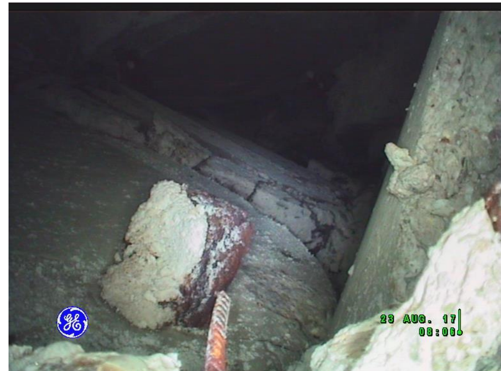
Blick in die Einlagerungskammer (23.08.2017)
