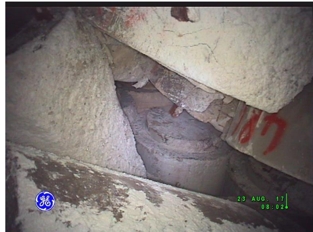
Blick in die Einlagerungskammer (23.08.2017)
