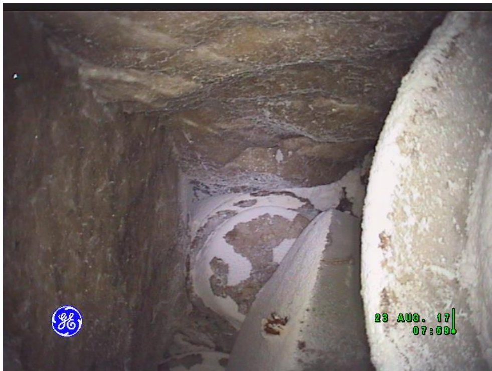
Blick in die Einlagerungskammer (23.08.2017)
