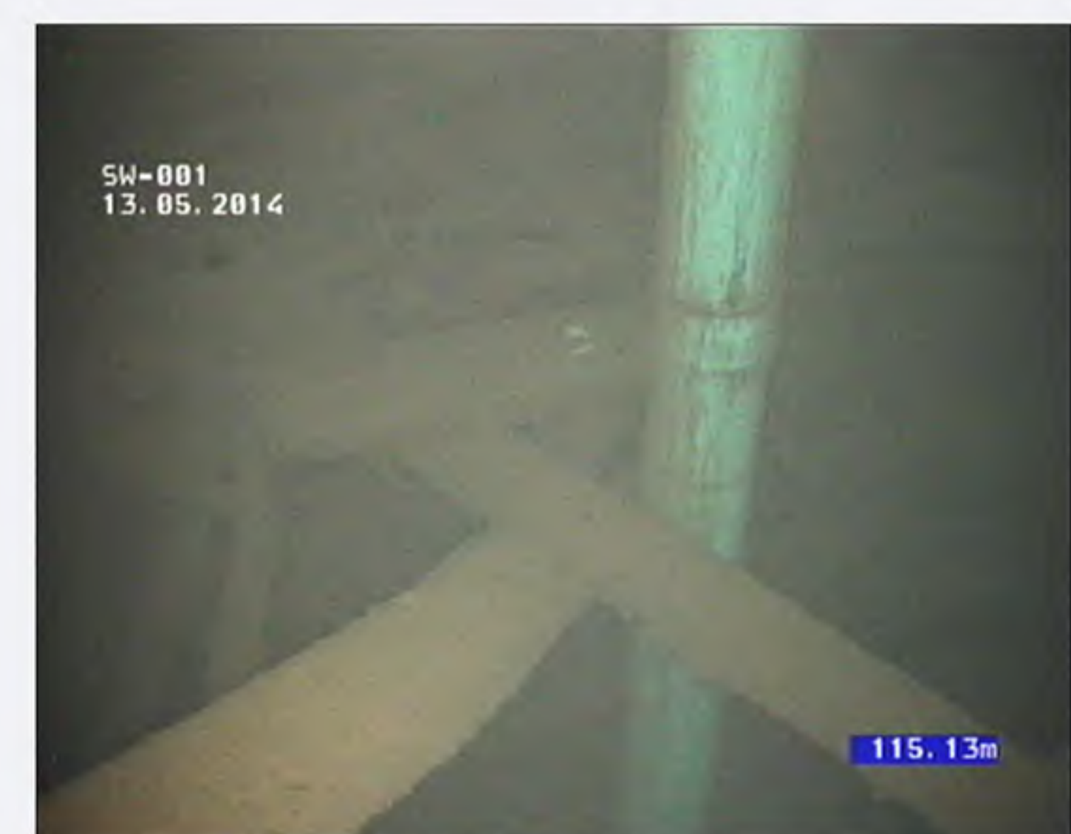
Standbild aus Kamerabefahrung Schacht Asse 1 vom 13.05.2014 bei ca. 115 m Tiefe. Sichtbar sind Teile von verstärkten Einbauten (ggf. Bongossi-Hölzer) und eine vertikal verlaufende, metallische Rohrleitung mit Muffenverbindung
