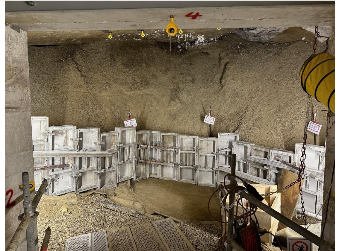
Böschungssicherung mit Schalungswänden
