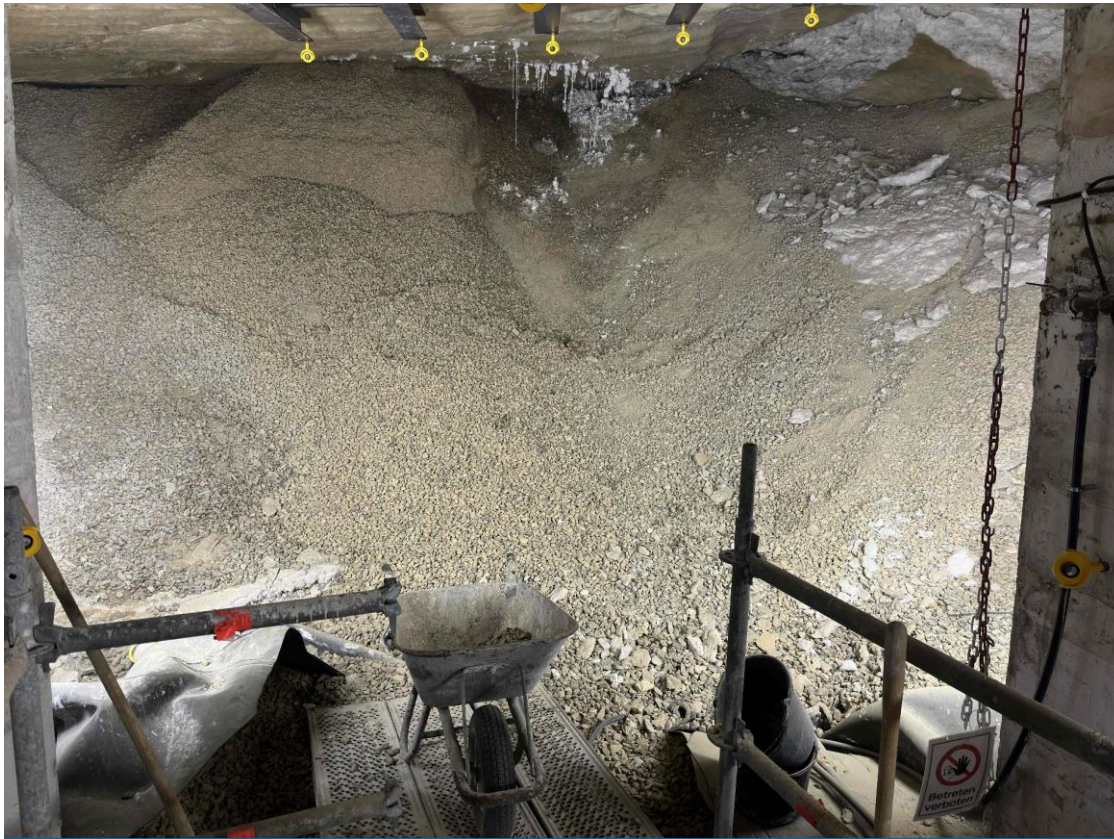
Entfernung des eingebrachten Drainagekieses
