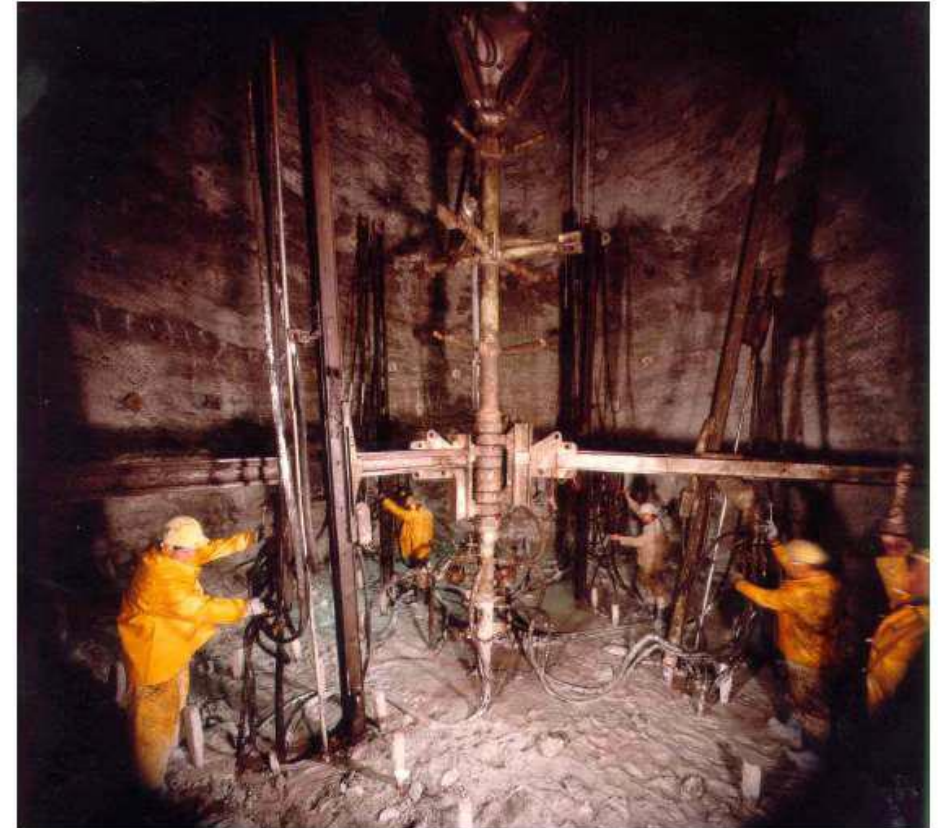
Abteufen mit Bohren und Sprengen
