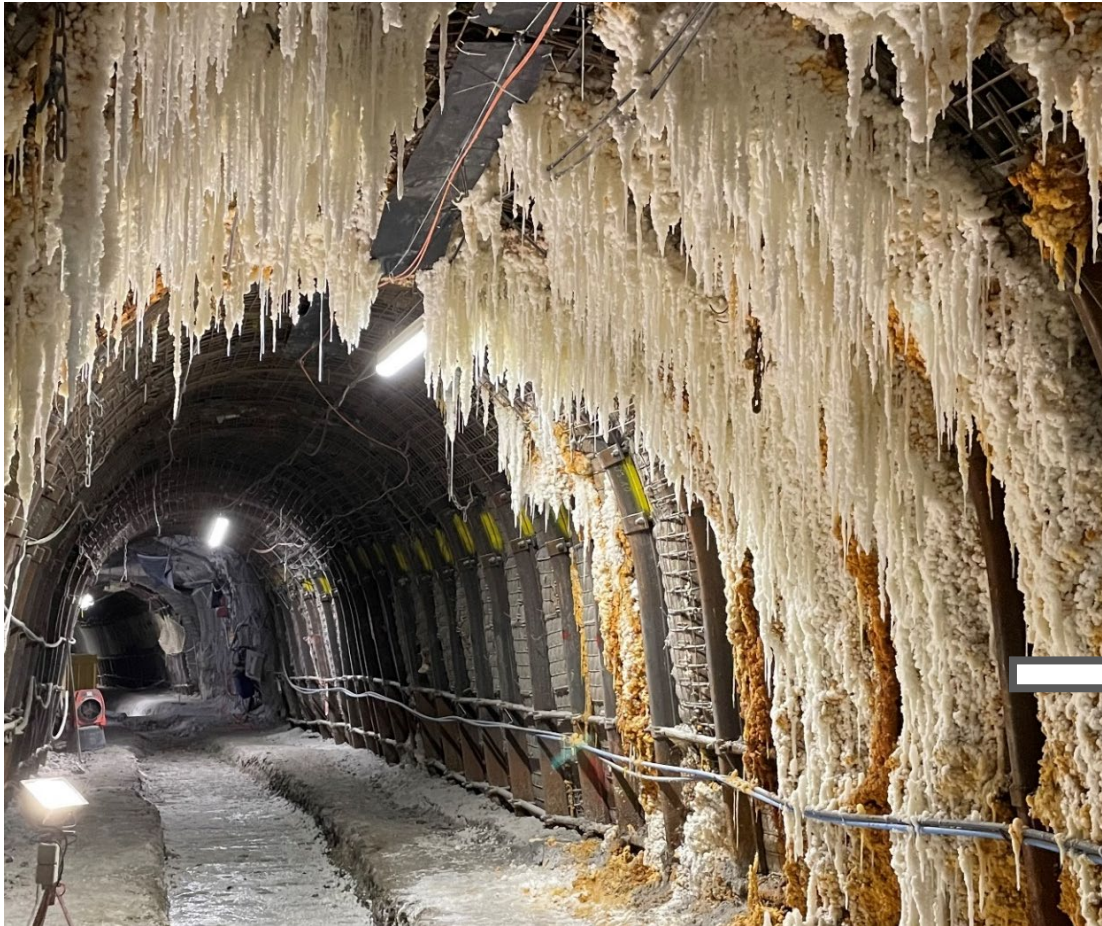
Gleitbogenausbaustrecke Katasterstelle P725004 Abbaureihe 3, 725 m-Sohle
