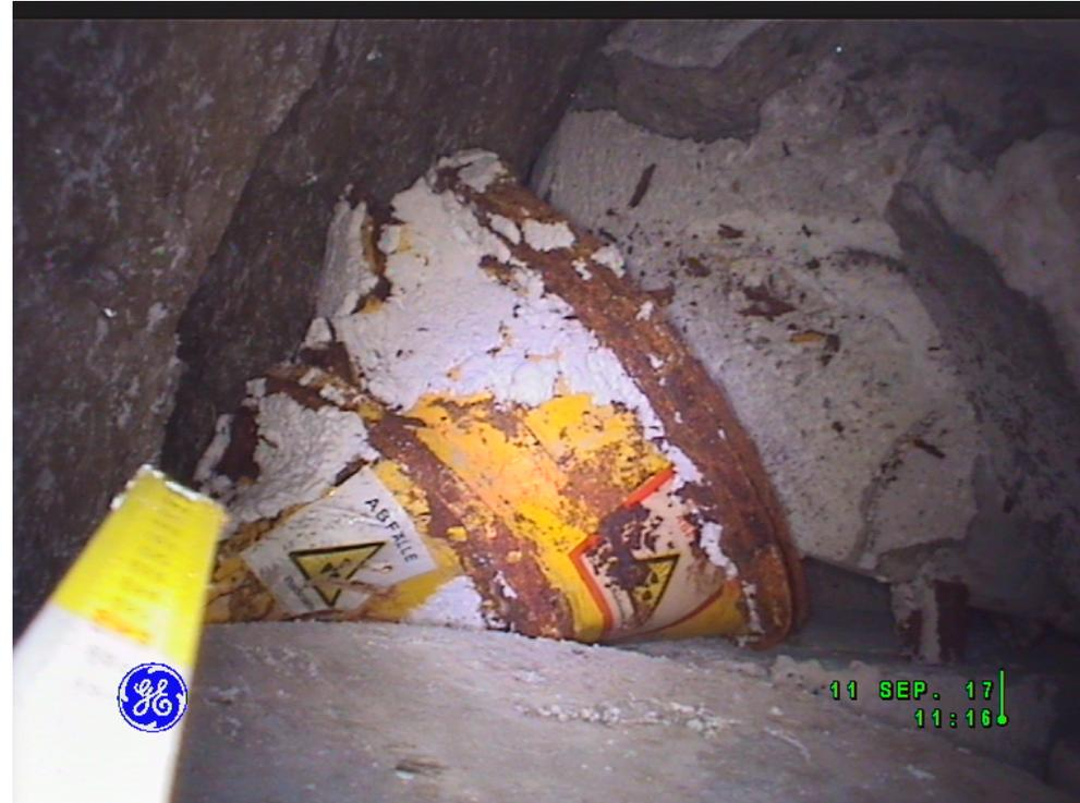
Bilder aus einem angebohrten Hohlraum im Firstbereich der Einlagerungskammer 7/750 (2017)
