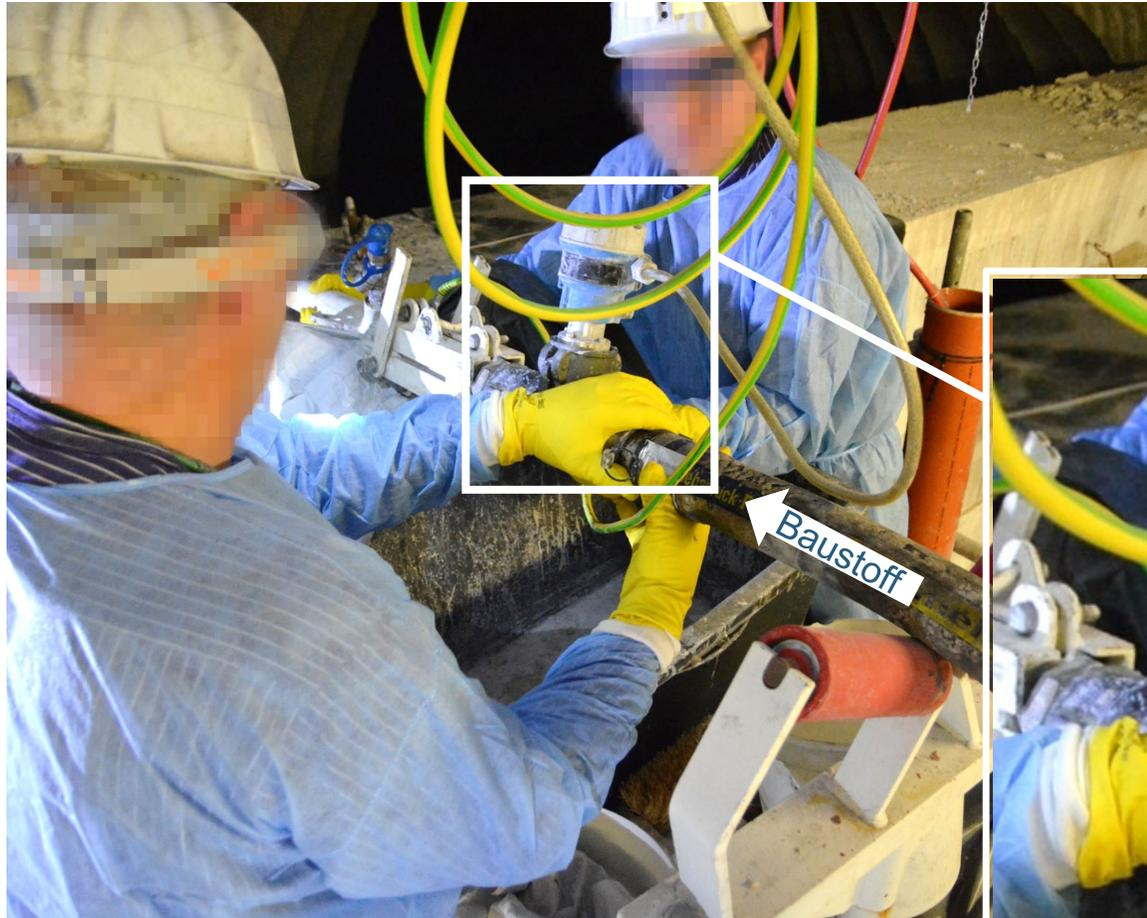
Baustoff-/Betonleitung bis an die Mauerkante
