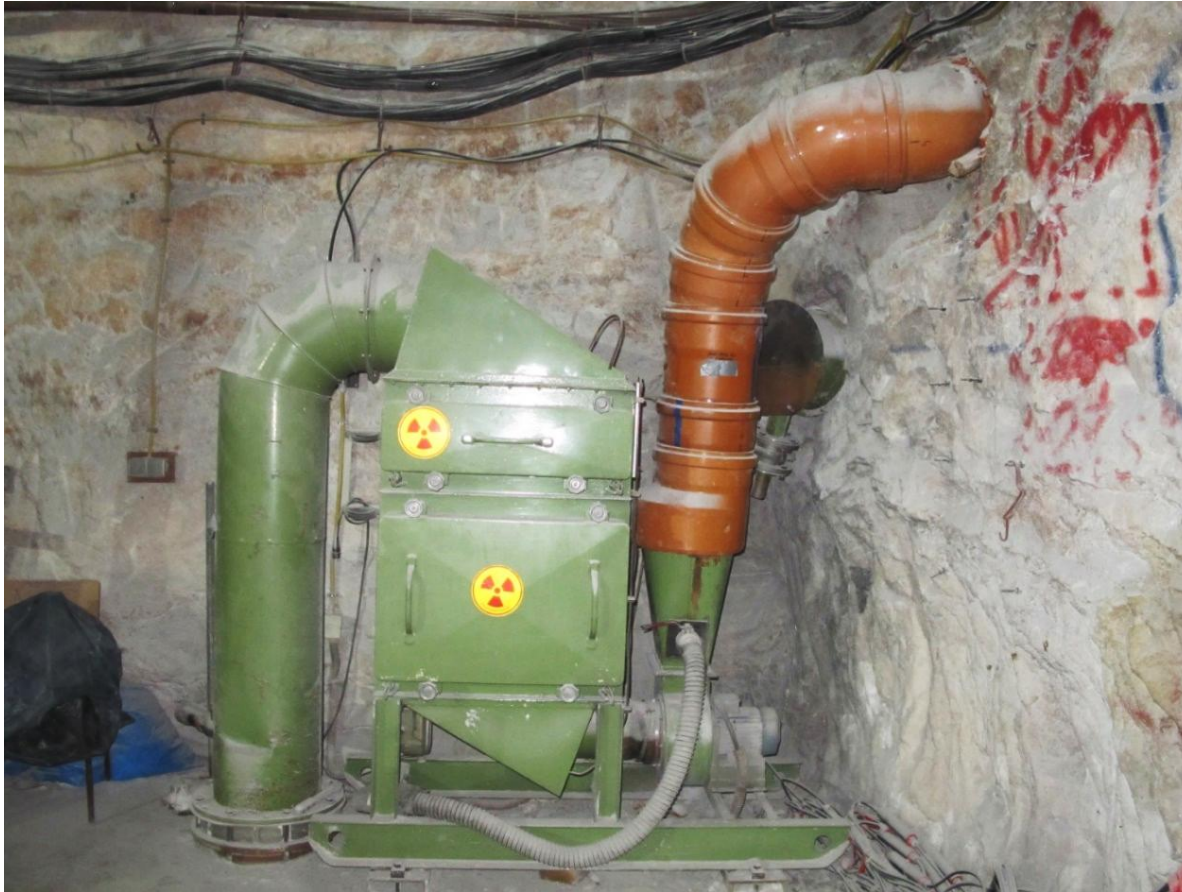
Alte MAW-Abluftfilteranlage
