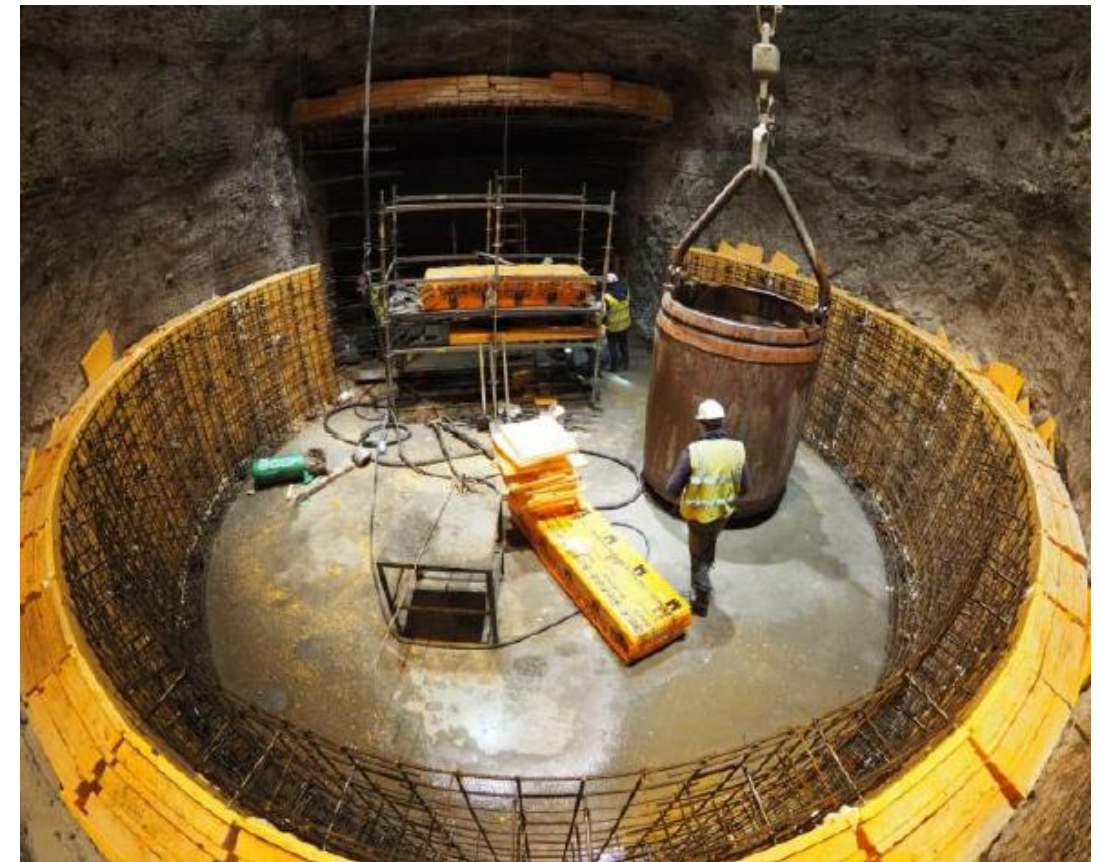
Ausbau im Salinar: Betonausbau mit Quetschfuge
