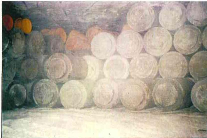
Abbildung 16: ELK 11/750, gestapelte VBA und sonstige Gebinde oberhalb der eingebrachten Ausgleichsschicht zwischen den unteren gekippten Fässern und den oberen gestapelten Fässern
