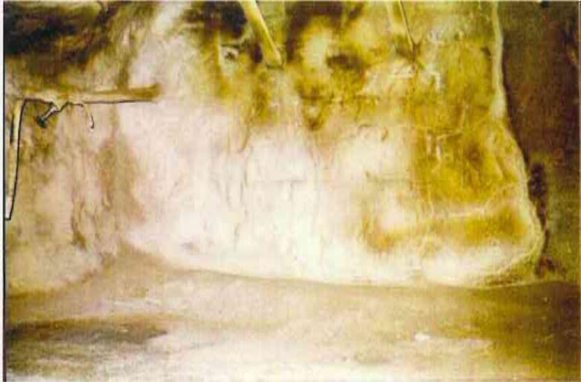
Abbildung 33: Nördlicher Zugang zur ELK 4/750 mit Spritzbeton versehene Schalungsmauer
