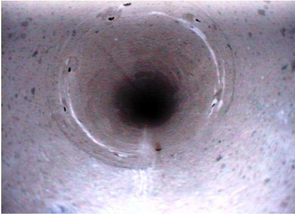
Foto 9a: Schwarze Flecke, leichter Riss/Ausbruch bei 14,65 m
