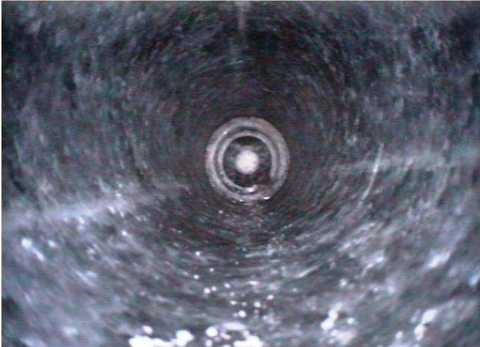
Foto 2e: Bohrlochende bei 57,44 m
