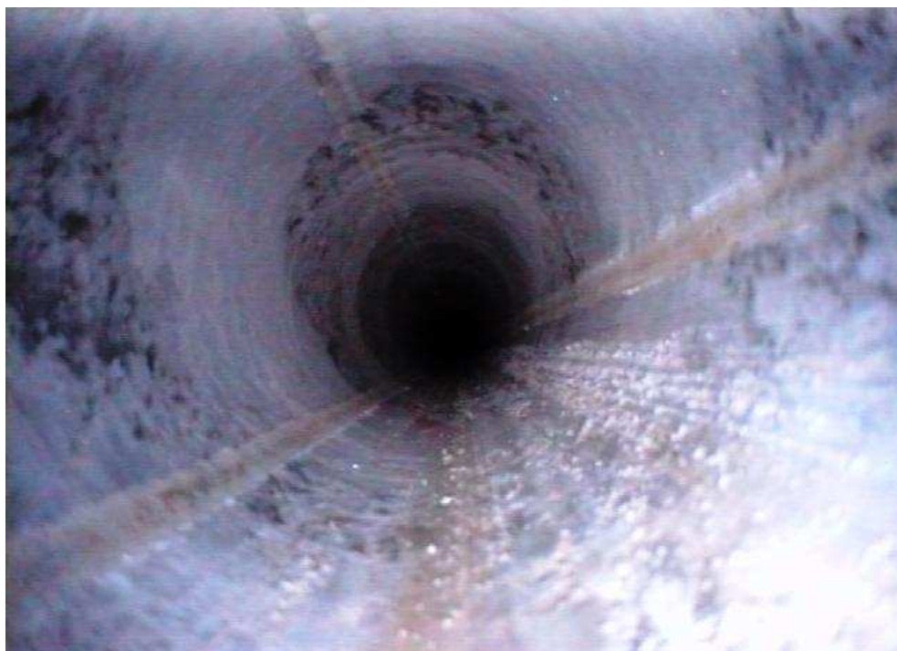
Foto 11g: Braune Stellen in der Sohle bei 28,00 m
