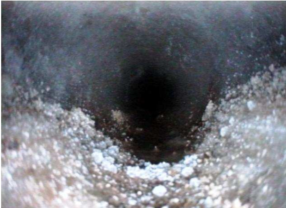
Foto 2a: Bohrloch feucht bei 0,70 m
