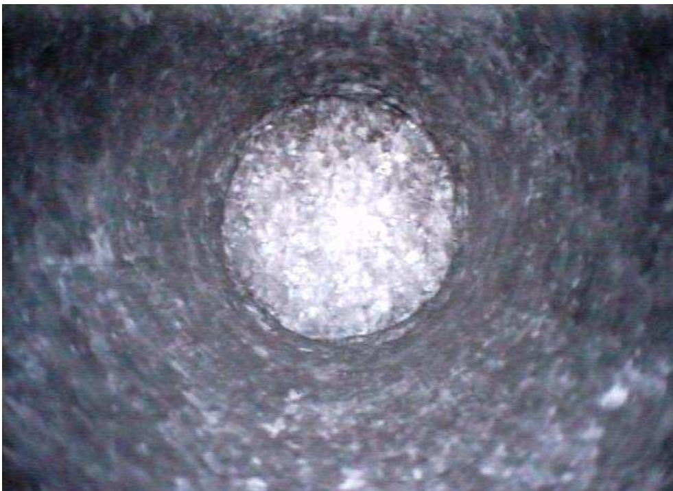
Foto 6h: Bohrlochende bei 44,14 m
