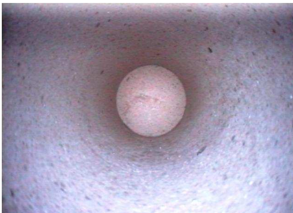
Foto 3j: Bohrlochende bei 47,93 m
