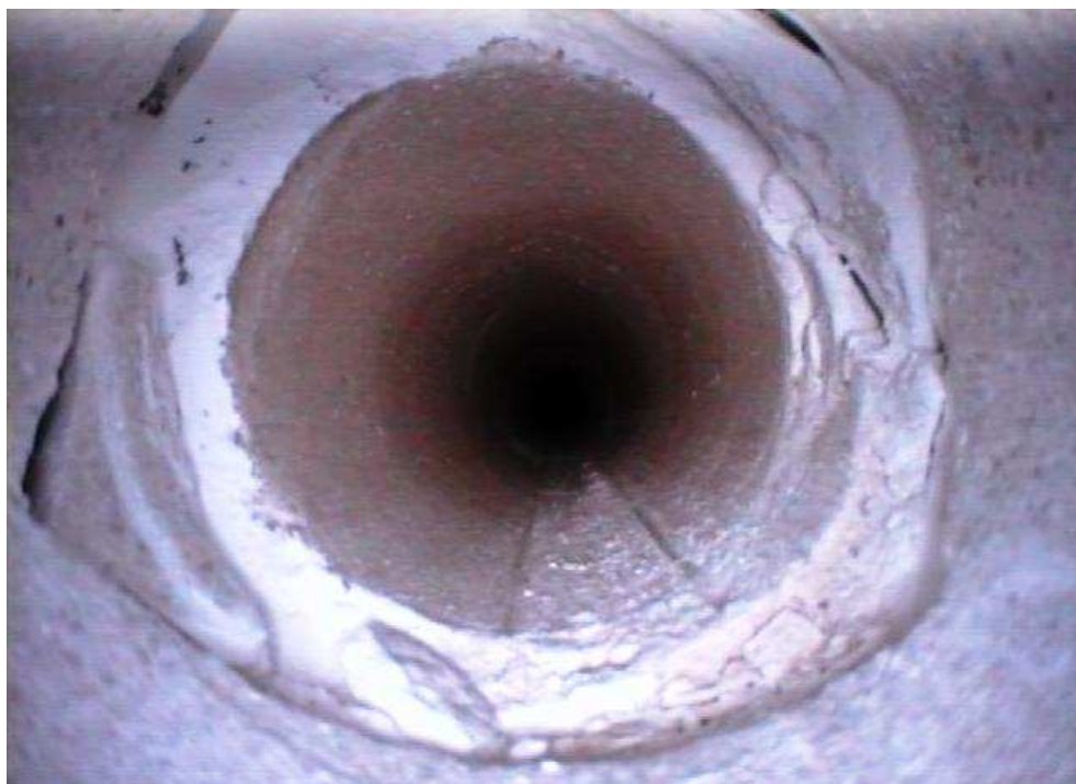
Foto 3i: Kluft bei 44,18 m
