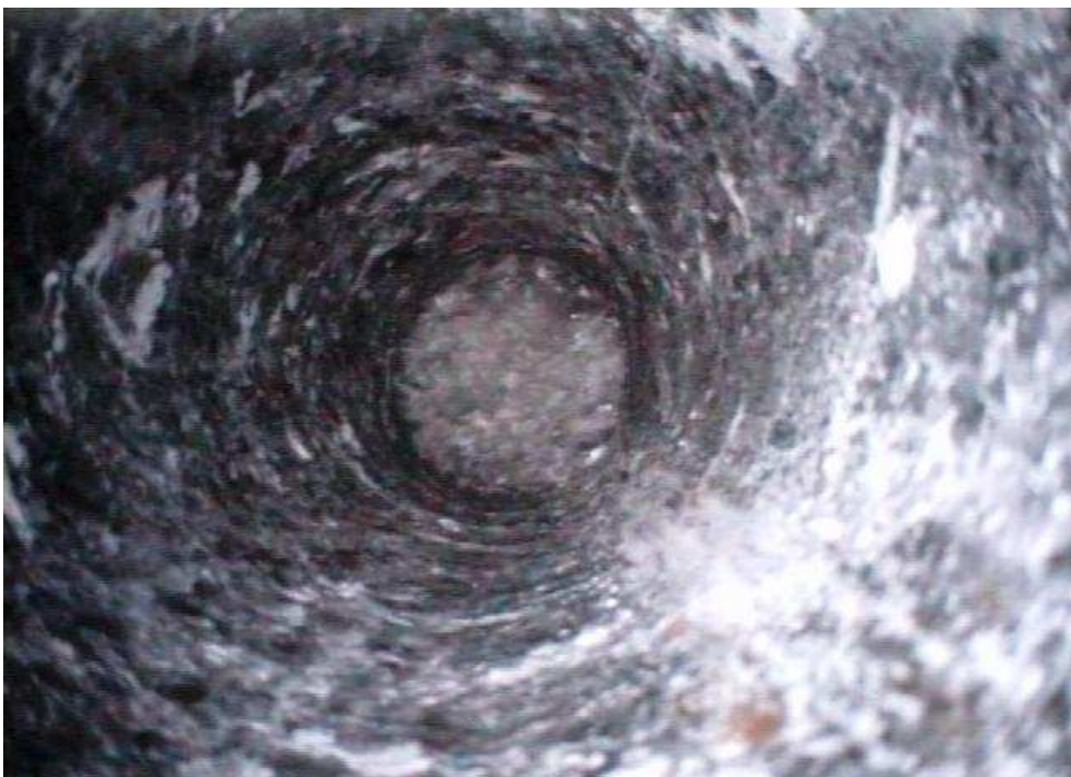
Foto 12f: Bohrlochende bei 61,87 m
