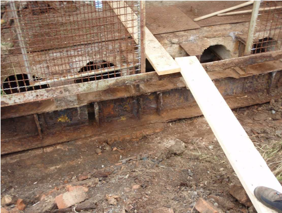
Abbildung 4: Blick auf den freigelegte Schachtabdeckung (Blickrichtung NS)
