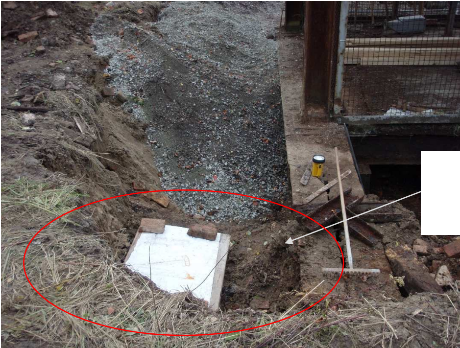
Abbildung 32: Blick auf den zum Teil mit Mineralgemisch gesicherten südlichen Bereich von Schacht Asse 1 (Blickrichtung O-W)
