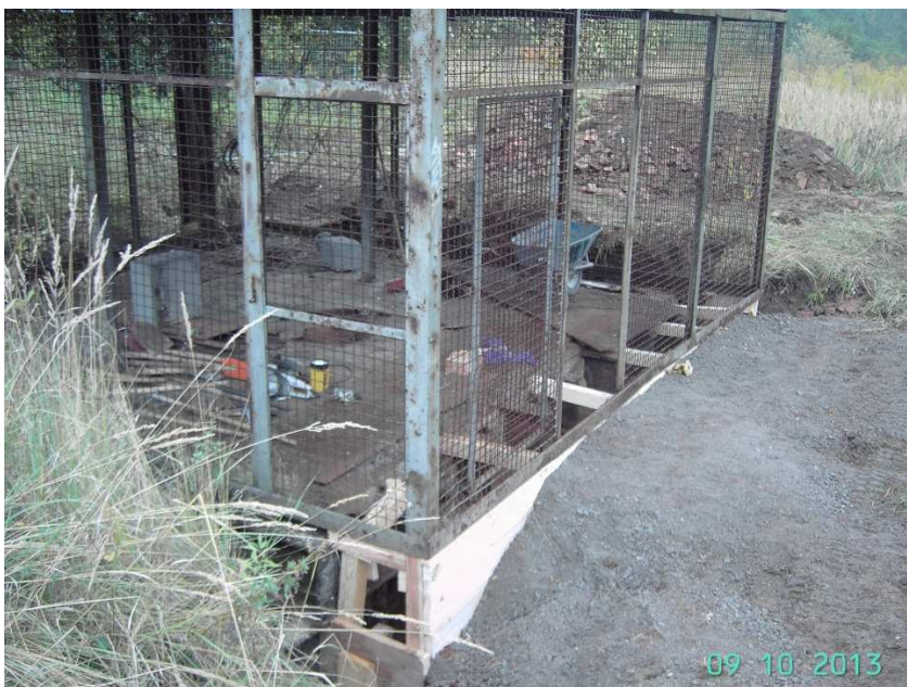
Abbildung 7: Blick auf den mit Mineralgemisch (0-32) verfüllten nördlichen Bereich von Schacht Asse 1 (Blickrichtung NO-SW)
