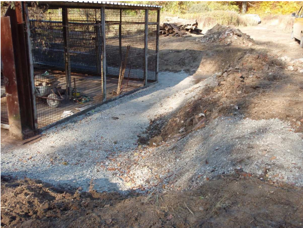
Abbildung 22: Blick auf den mit Mineralgemisch (0-32) verfüllten östlichen Bereich von Schacht Asse 1 (Blickrichtung SO-NW)
