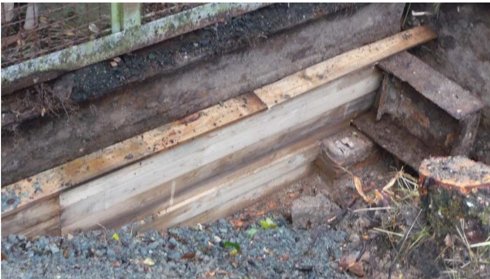
Abbildung 12: Blick auf den mit Holz verschalten und z.T. mit Mineralgemisch (0-32) verfüllten westlichen Bereich von Schacht Asse 1
