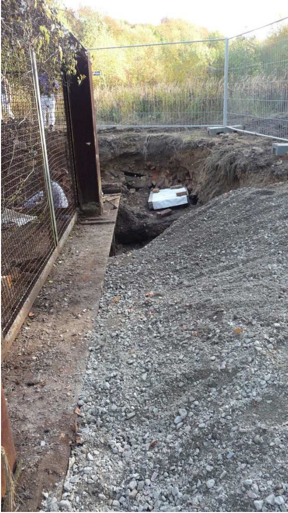
Abbildung 16: Blick auf den mit Mineralgemisch (0-32) aufgefüllten südlichen Bereich von Schacht Asse 1 (Blickrichtung W-O)
