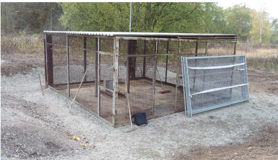
Abbildung 25: Blick auf die Einhausung von Schacht Asse 1 nach Abschluss der Arbeiten (Blickrichtung NO-SW)
