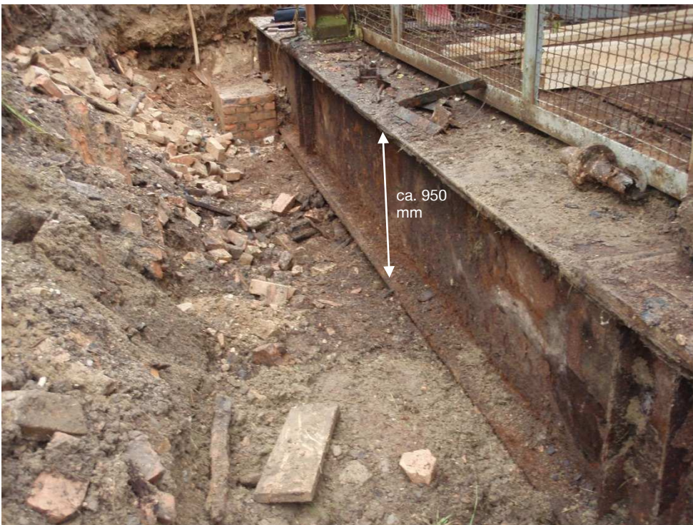
Abbildung 15: Blick auf die freigelegten Doppel-T-Endträger im südlichen Bereich von Schacht Asse 1 (Blickrichtung SO-NW)
