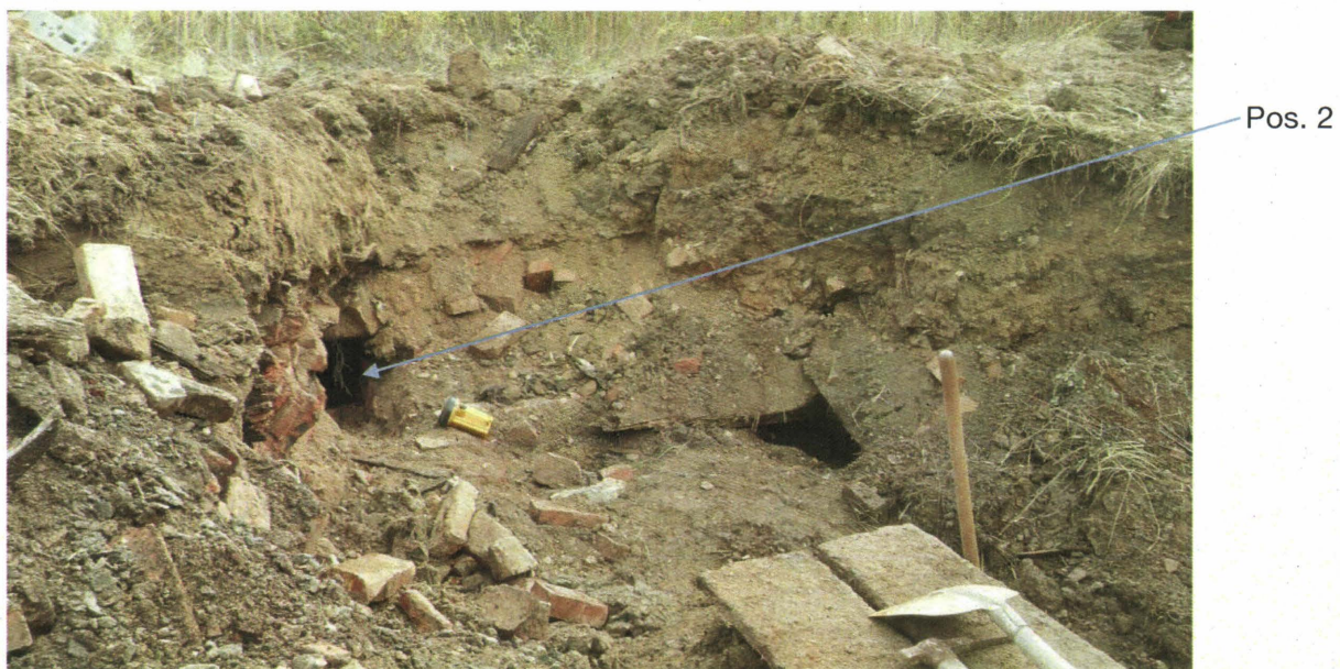
Abbildung 36: Blick auf den noch freigelegten südlichen Bereich von Schacht Asse 1 mit nicht definierten Hohlräumen (Pos. 2) (Blickrichtung NW-SO)
