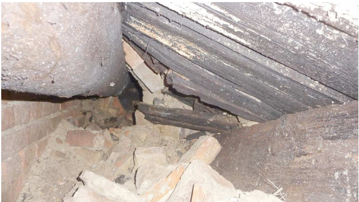
Abbildung 35: Blick auf den Hohlraum im südlichen Bereich von Schacht Asse 1 (Pos. 1) auf einer Länge von ca. 6- 8 m (Blickrichtung N-S)
