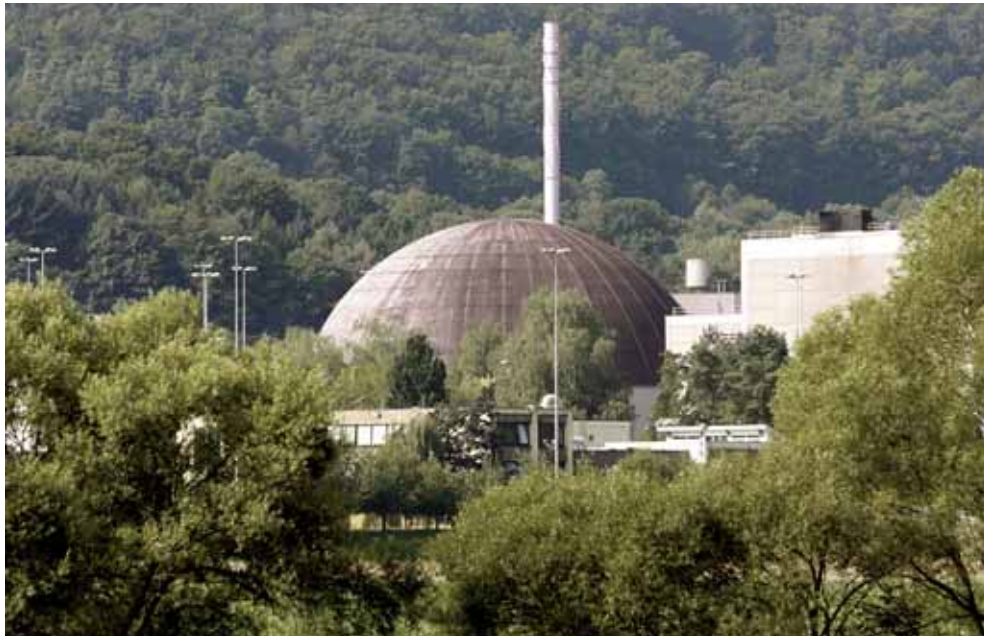
Aus dem seit 2005 stillgelegten AKW Obrigheim kam über die Hälfte der radioaktiven Abfälle, die in der Asse lagern.
