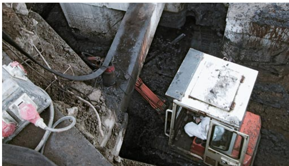
Draußen vor der Tür: Damit während der Sanierung keine giftigen Dämpfe entweichen konnten, wurde über ein Einfamilienhaus eine Halle errichtet. Mitten im Wohngebiet stieß man auf alte Fundamente, in denen sich krebserregende Stoffe gesammelt hatten. Foto: HIM GmbH
