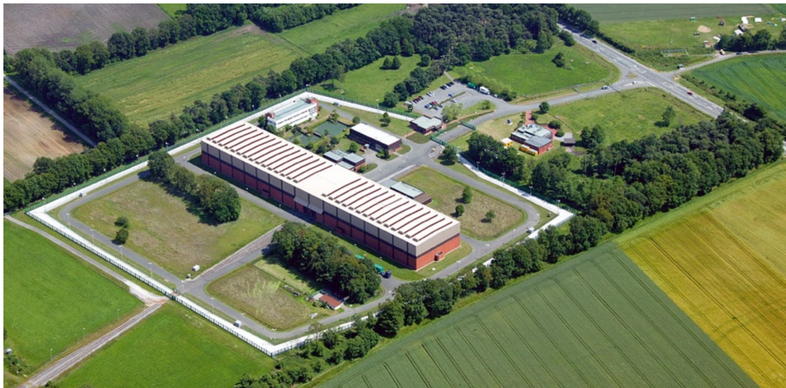
PLÖTZLICH IST SOGAR IM GESPRÄCH, OBERIRDISCHE HALLEN WIE DAS ZWISCHENLAGER IN AHAUS ZU VERBUNKERN, UM DEN ATOMMÜLL AUF UNABSEHBARE ZEIT DARIN ZU LAGERN
