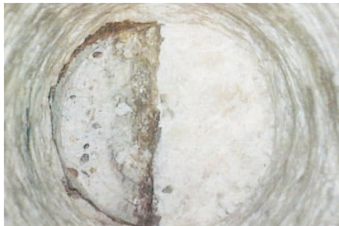
10. Juni 2013: In der Schachanlage Asse II trifft der Bohrer in Kammer 7 nach ca. 23 Metern auf einen betonummantelten Abfallbehälter
